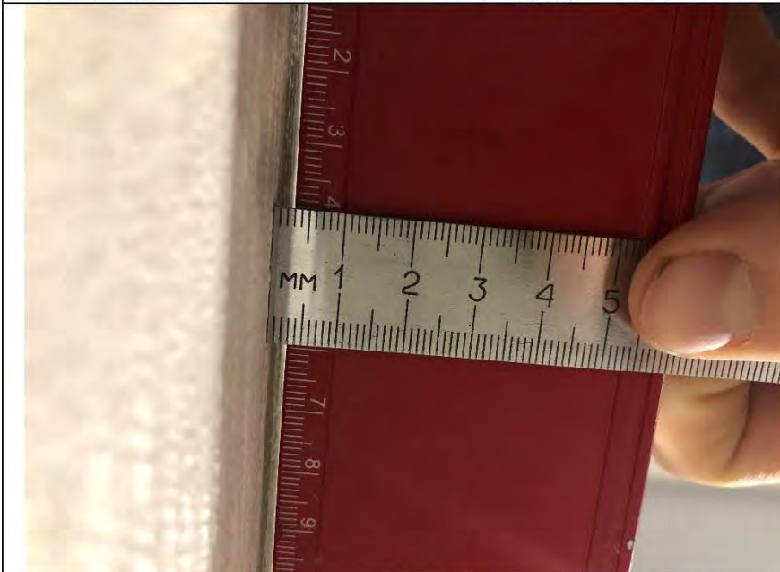
Фото №8. Измерение уровня стен коридора в квартире.
