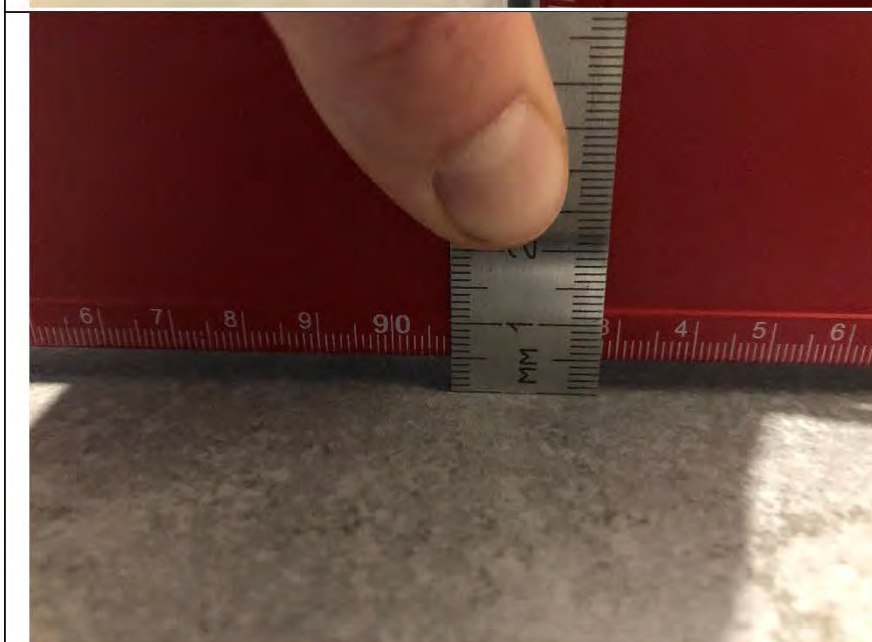
Фото №12. Измерение напольного покрытия коридора в квартире.
