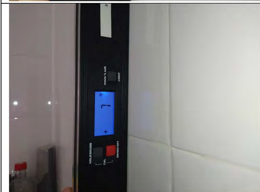
Фото №8. Измерение уровня стен в ванной комнате (керамическая плитка).
