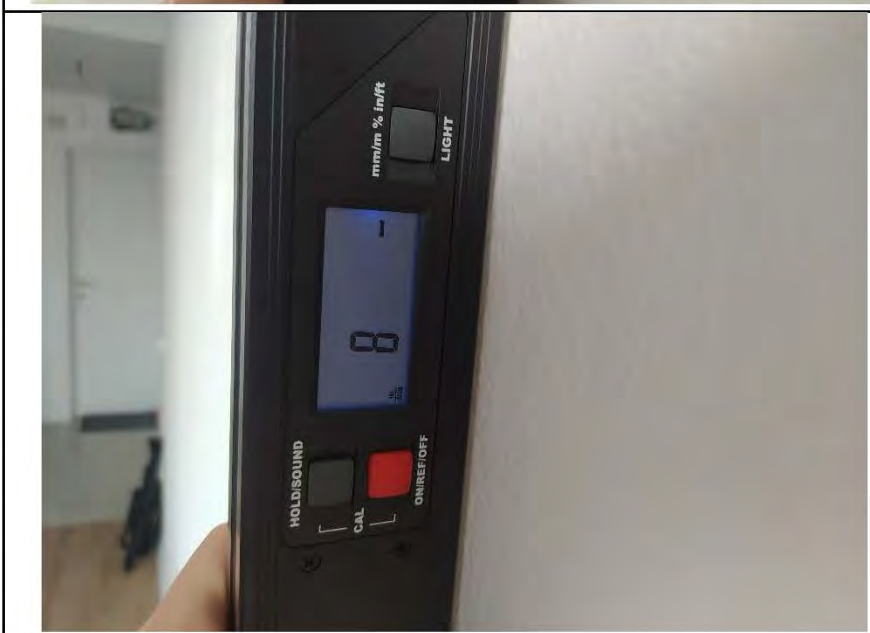
Фото №6. Измерение уровня стен в кухне.
