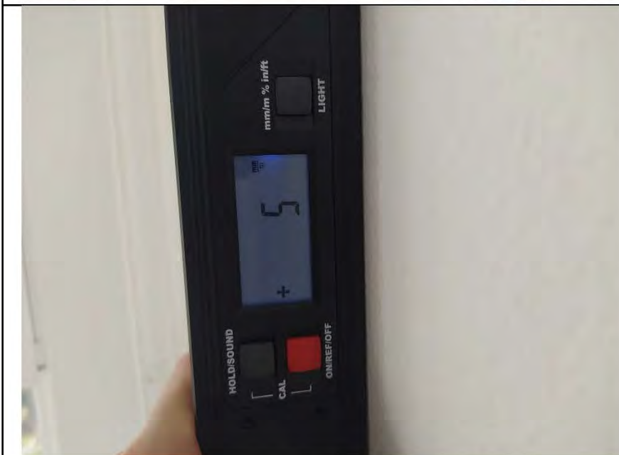
Фото №5. Измерение уровня стен в спальне.
