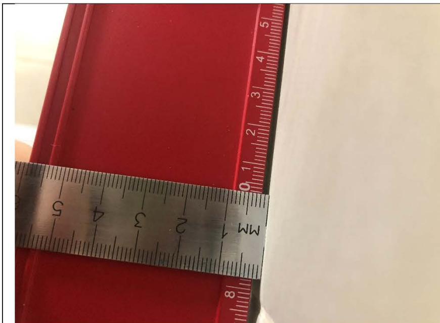
Фото №55. Измерение уровня стен ванной комнаты в квартире.
