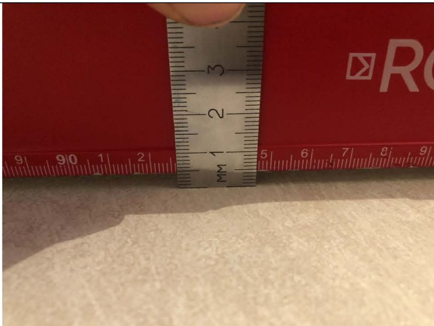
Фото №46. Измерение напольного покрытия в кухне в квартире.
