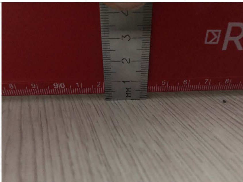
Фото №25. Измерение напольного покрытия в спальне в квартире.
