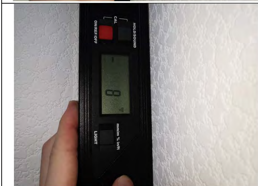
Фото №8. Измерение уровня стен в коридоре.
