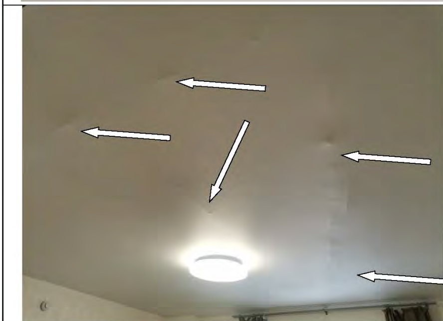
Фото №27. На полотне натяжного потолка в комнате видны инженерные сети.
