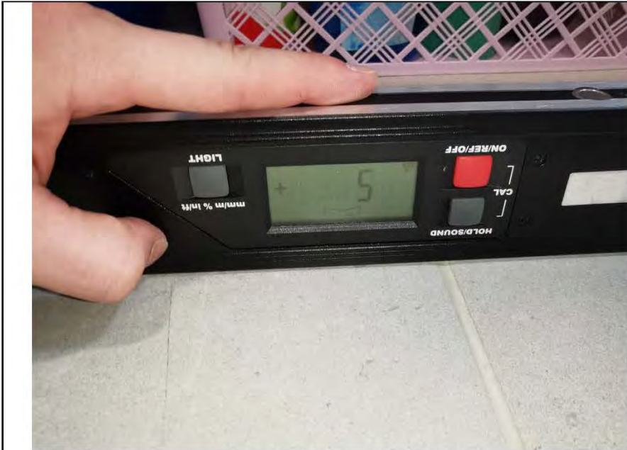
Фото №22. Измерение уровня пола в санузле.
