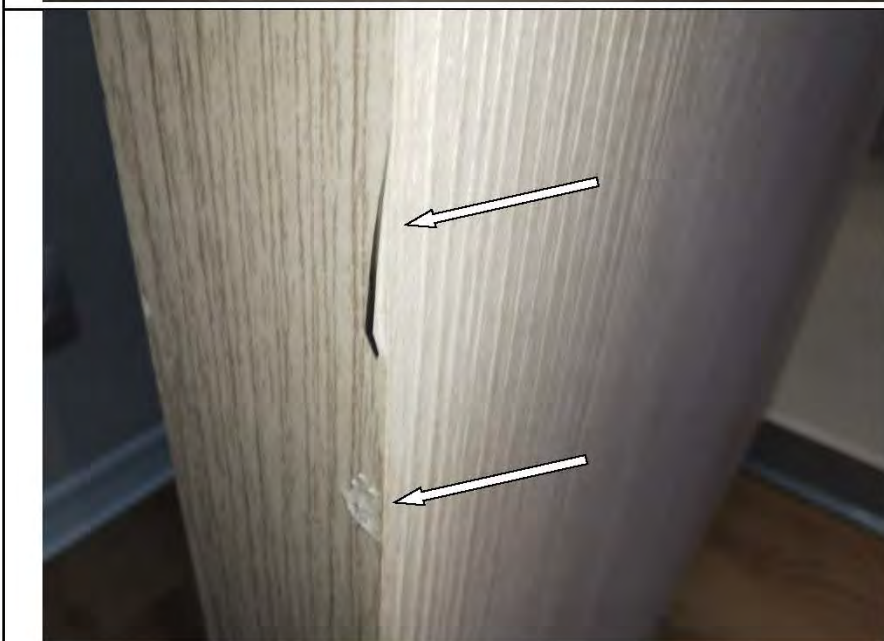
Фото №36. Загрязнение полотна деревянного дверного блока в санузле.
