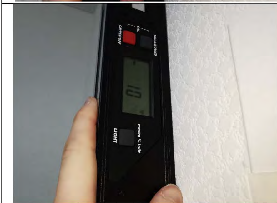
Фото №9. Измерение уровня стен в коридоре.
