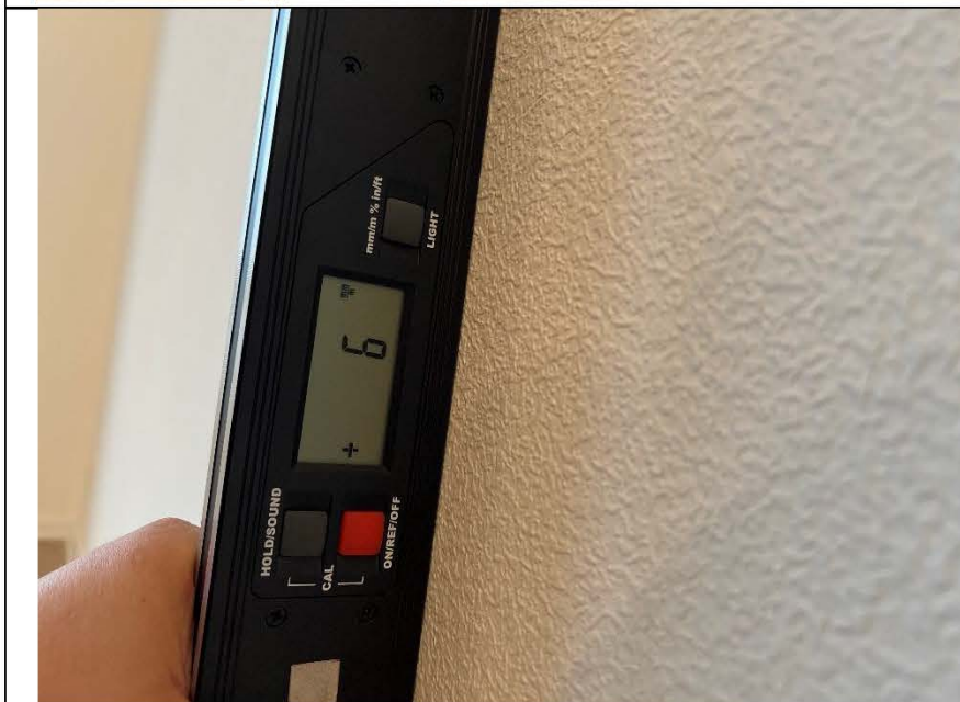
Фото №11. Измерение уровня стен в кухне.
