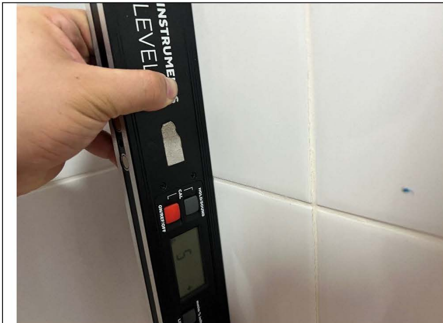
Фото №22. Измерение уровня стен в санузле.
