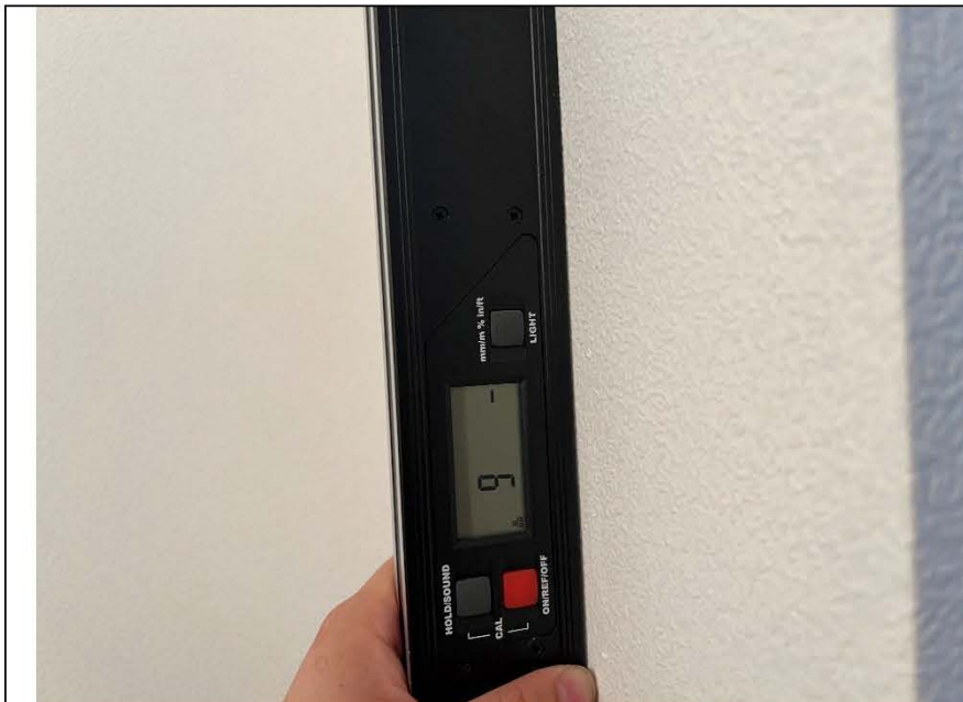
Фото №13. Измерение уровня стен в прихожей.
