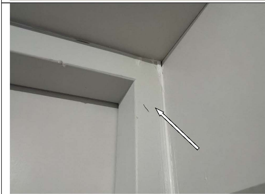
Фото №75. Царапины на коробке входного дверного блока.
