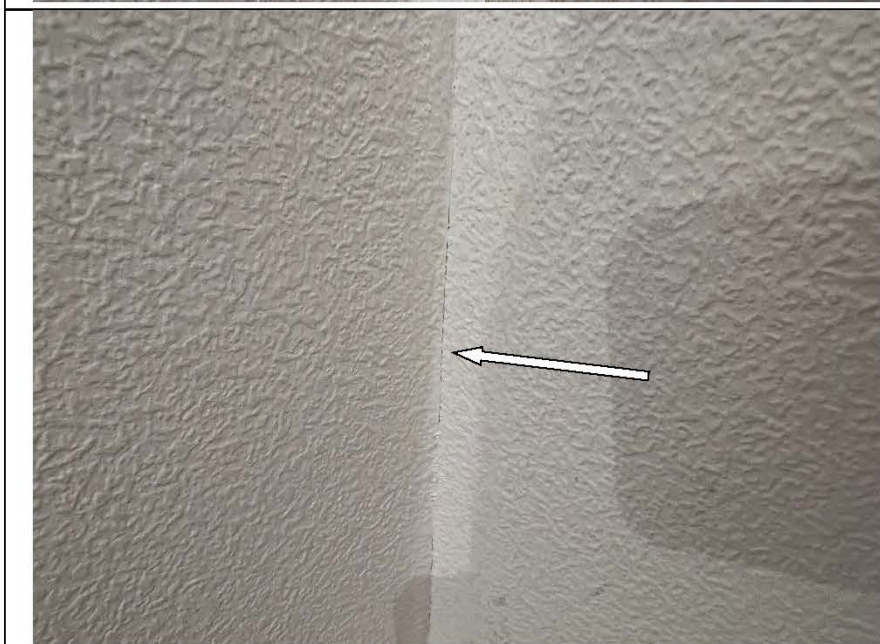
Фото №18. Читаемые обойные стыки в гардеробной.
