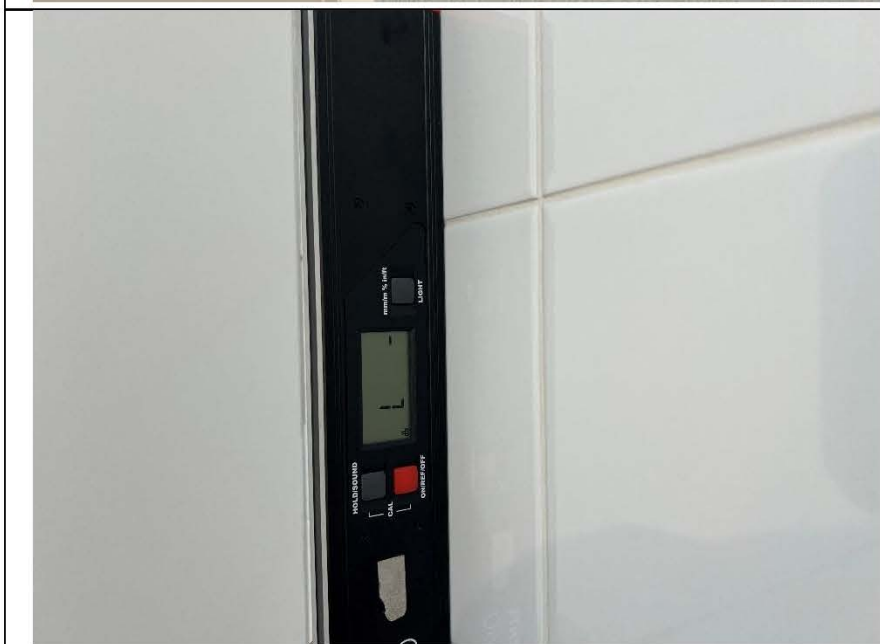
Фото №21. Измерение уровня стен в ванной комнате.
