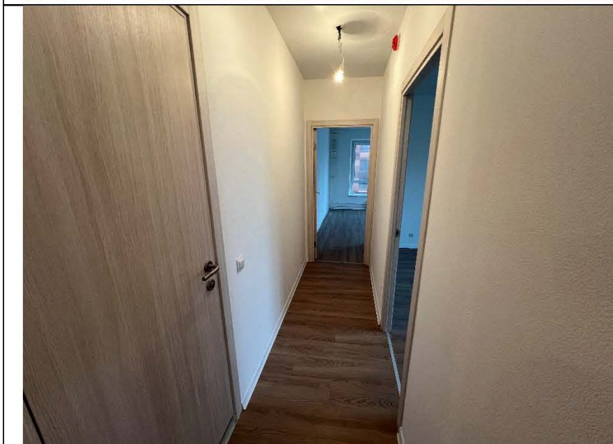
Фото №5. Общий вид коридора.
