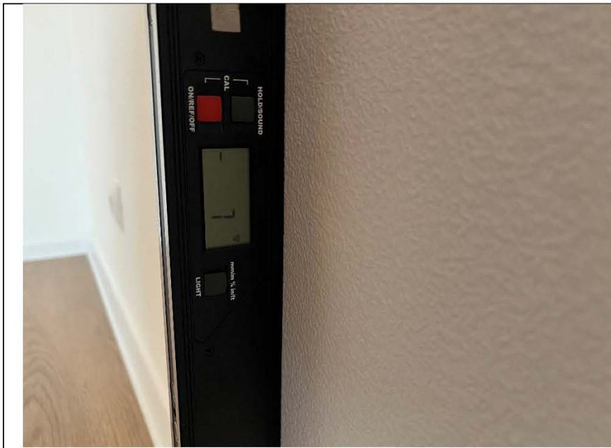
Фото №10. Измерение уровня стен в спальне.
