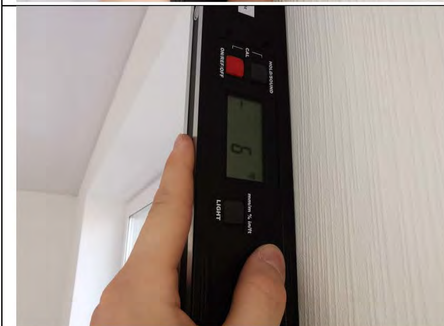
Фото №17. Измерение уровня стен в спальне.
