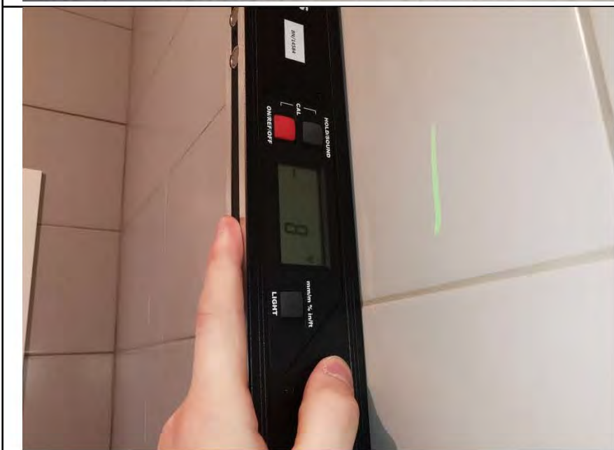
Фото №24. Измерение уровня стен в санузле.
