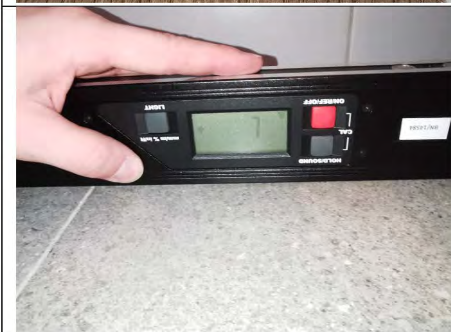
Фото №54. Измерение уровня пола в санузле.
