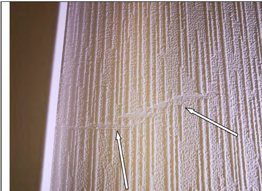
Фото №19. Потертости на обойном полотне в коридоре.
