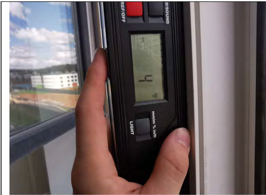
Фото №97. Отклонение ПВХ оконного блока в спальне по уровню вертикальности.
