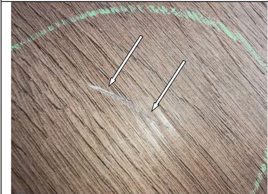
Фото №47. Царапины на поверхности напольного покрытия из ламината в спальне.
