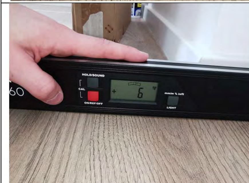
Фото №38. Измерение уровня пола в кухне.
