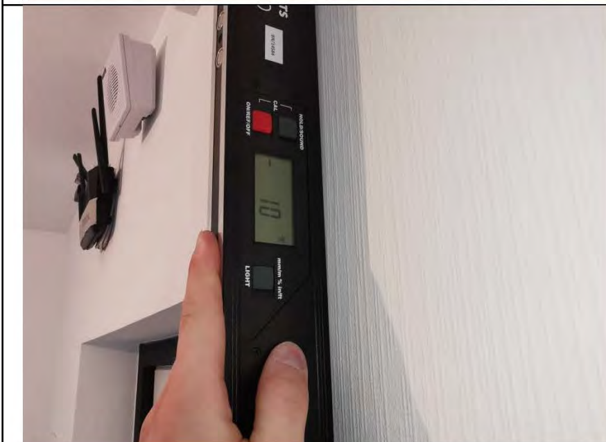
Фото №11. Измерение уровня стен в коридоре.
