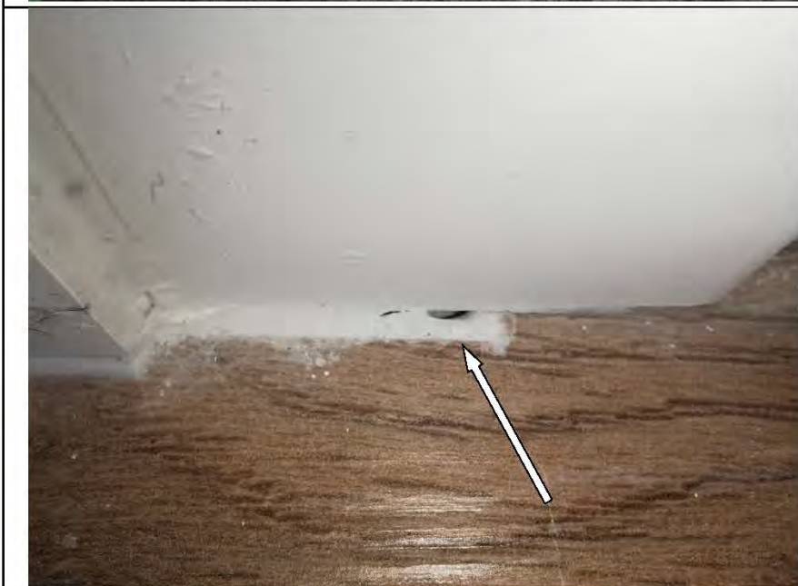
Фото №59. Коротко подрезан ламинат на стыке элементов в коридоре.
