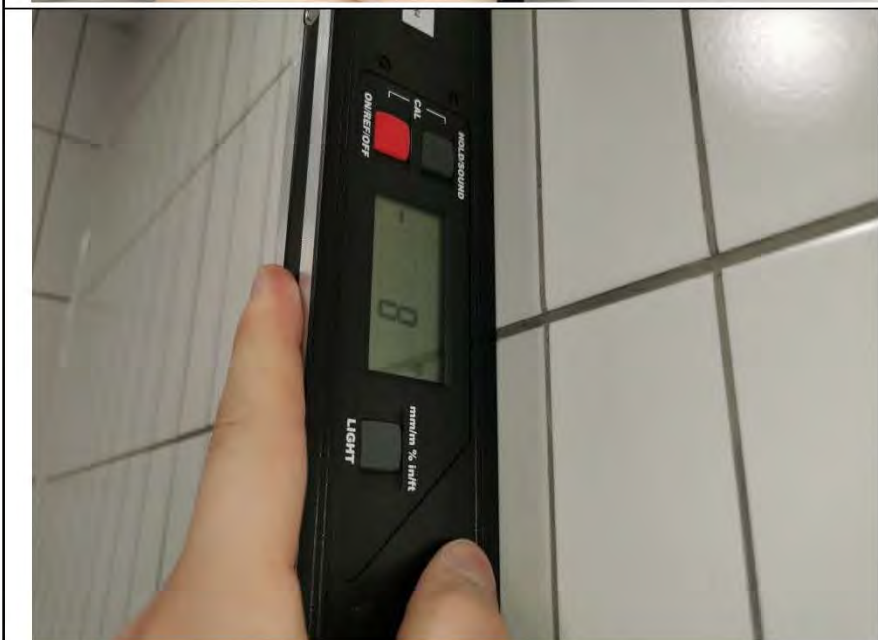
Фото №26. Измерение уровня стен в ванной комнате.
