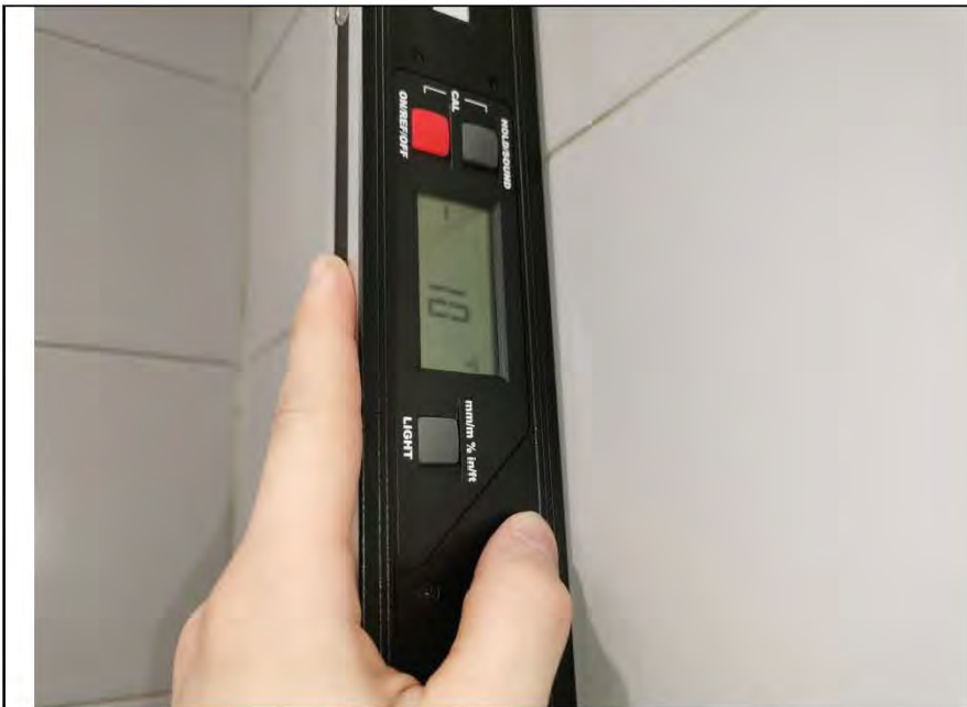
Фото №25. Измерение уровня стен в ванной комнате.
