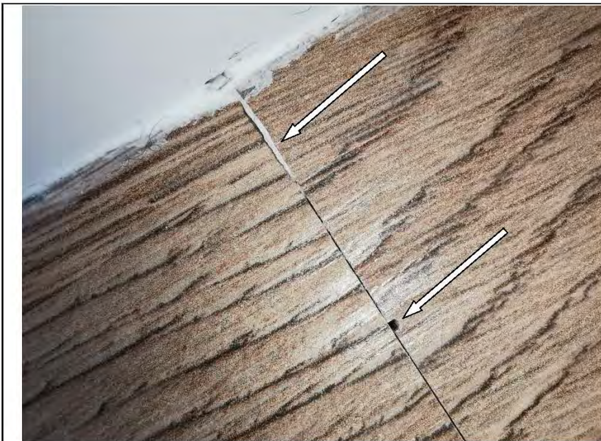
Фото №49. Зазоры между соседними досками ламината, а также скол на ламинате в спальне.
