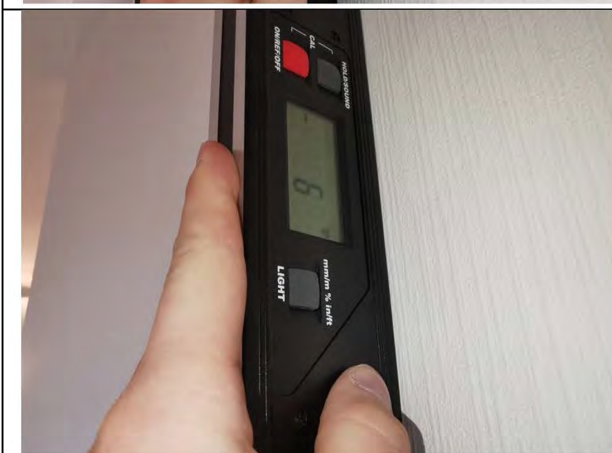
Фото №12. Измерение уровня стен в коридоре.
