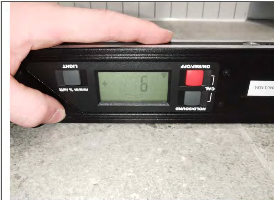
Фото №55. Измерение уровня пола в ванной комнате.
