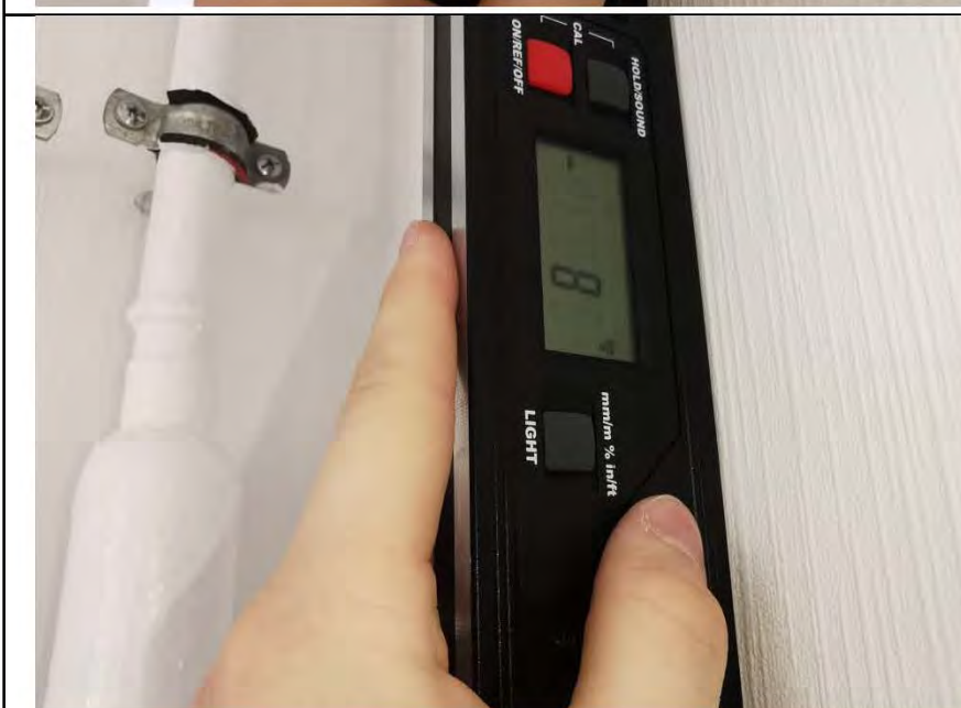
Фото №18. Измерение уровня стен в спальне.
