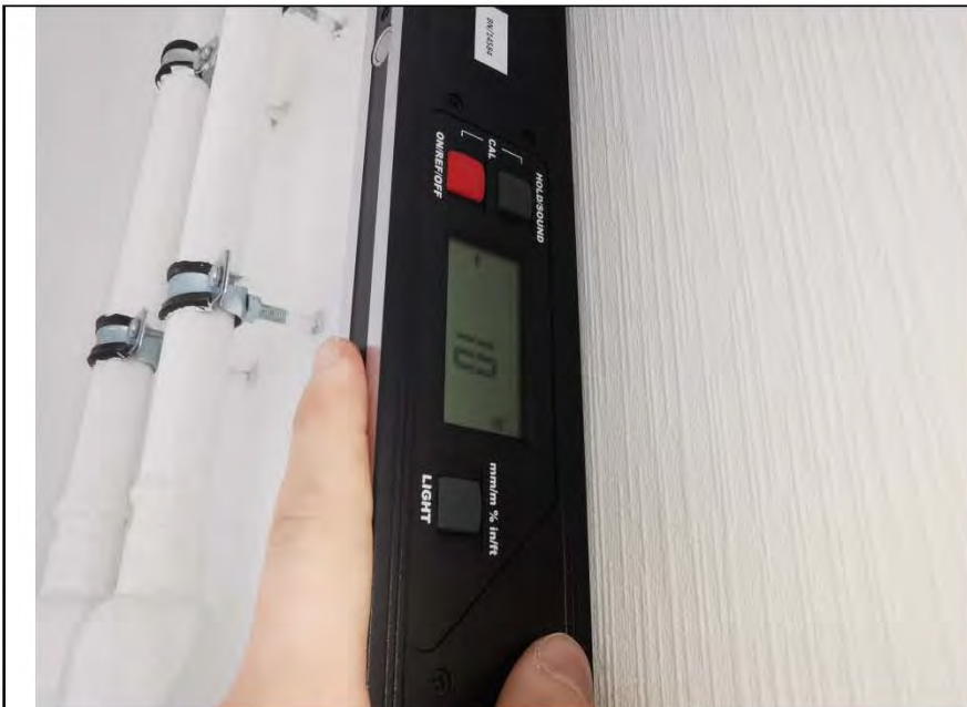
Фото №16. Измерение уровня стен в гостиной.
