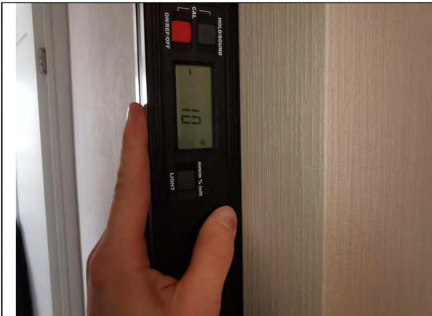
Фото №13. Измерение уровня стен в коридоре.
