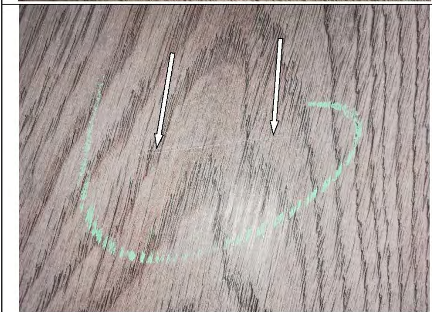
Фото №48. Царапины на поверхности напольного покрытия из ламината в спальне.
