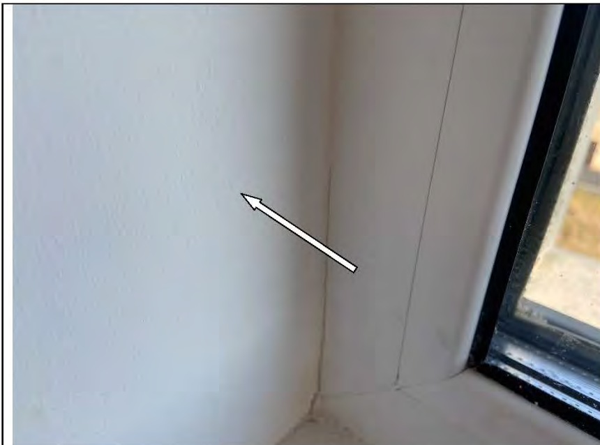
Фото №67. Неровности, выбоины, раковины на окрашенных откосах оконного блока ПВХ в спальне.
