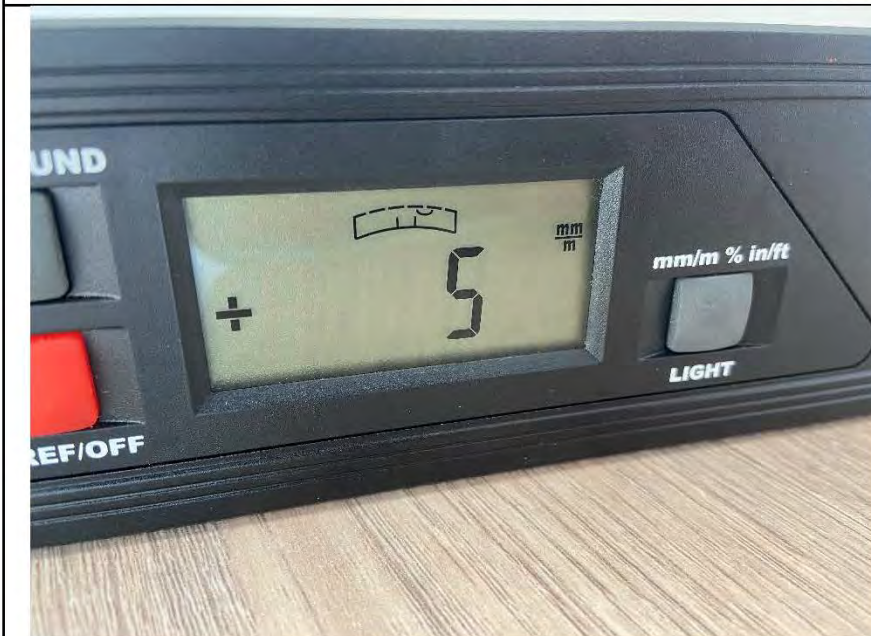
Фото №26. Отклонение поверхности напольного покрытия из ламината в кабинете.
