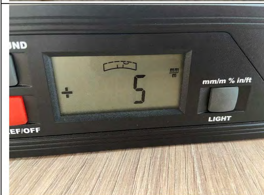
Фото №24. Отклонение поверхности напольного покрытия из ламината в коридоре.
