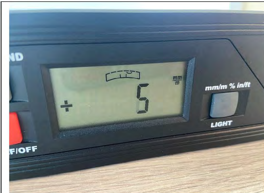
Фото №25. Отклонение поверхности напольного покрытия из ламината в кухне.
