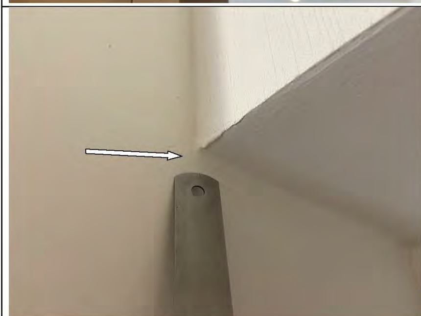
Фото №66. Неровности, выбоины, раковины на окрашенных откосах входного дверного блока в коридоре.
