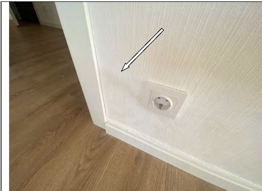
Фото №13. Следы залития на стенах, оклеенных обоями, в жилой комнате №1.
