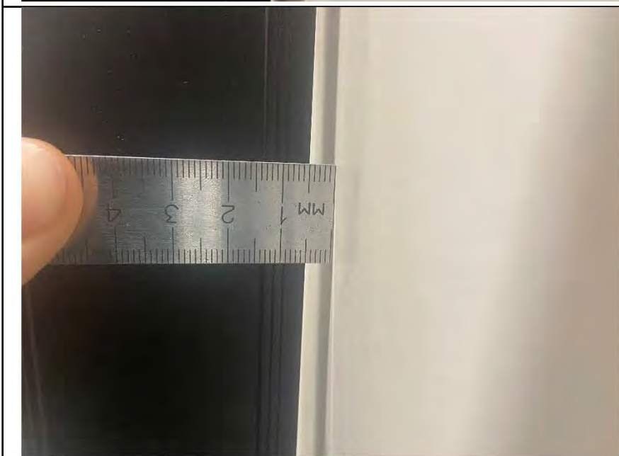
Фото №15. Измерение уровня стен в санузле.
