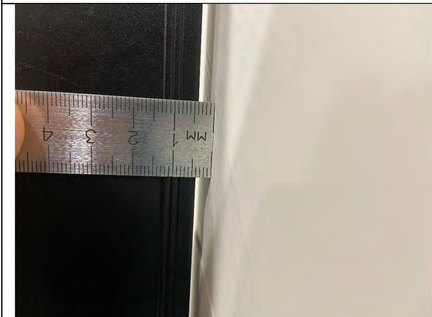
Фото №14. Измерение уровня стен в ванной комнате.
