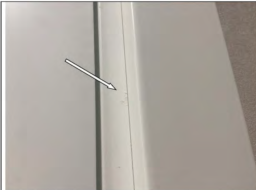
Фото №73. Загрязнения на коробке деревянного дверного блока в коридоре в квартире.
