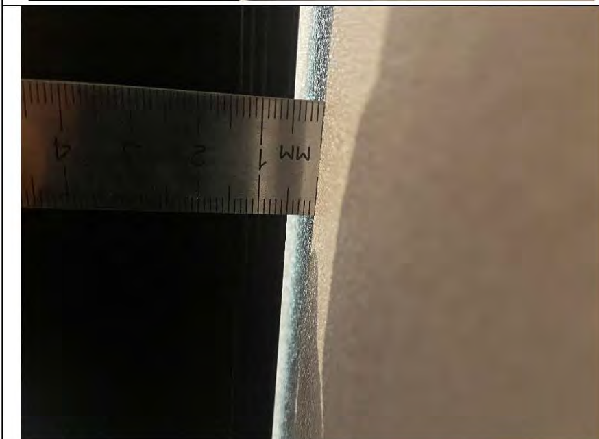
Фото №11. Измерение уровня стен в спальне.
