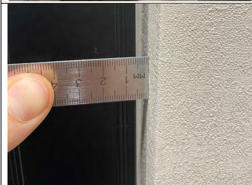
Фото №9. Измерение уровня стен в прихожей.
