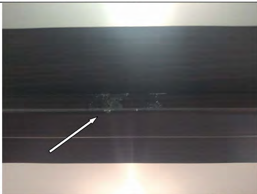
Фото №44. Коробка деревянного дверного блока в ванной комнате имеет дефекты (загрязнение строительными составами).
