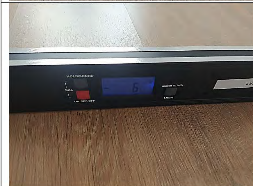
Фото №15. Измерения уровня напольного покрытия в гостиной.
