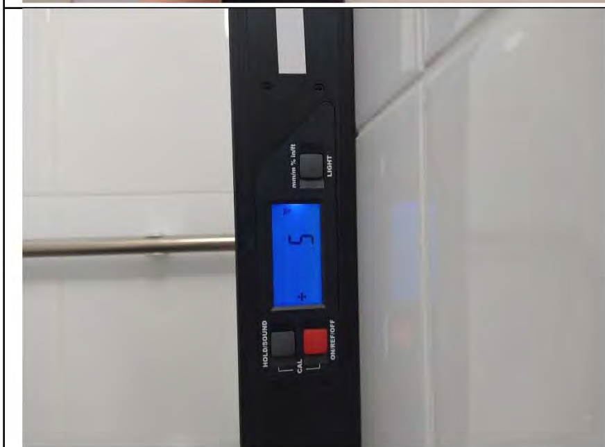
Фото №12. Измерения уровня стен в ванной комнате.
