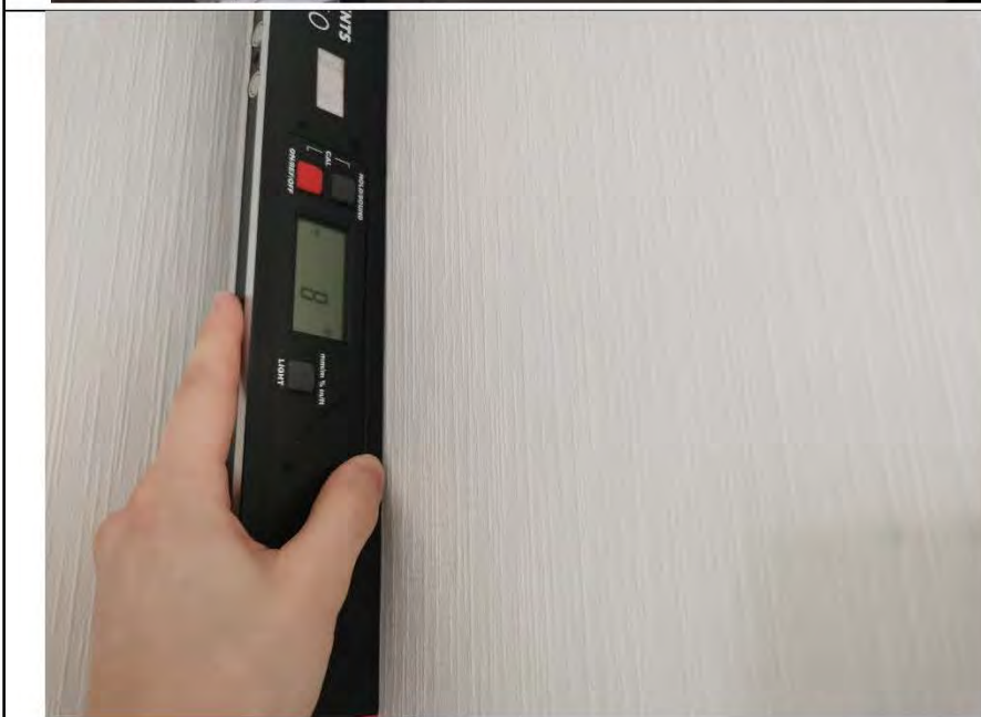
Фото №9. Измерение уровня стен в коридоре.
