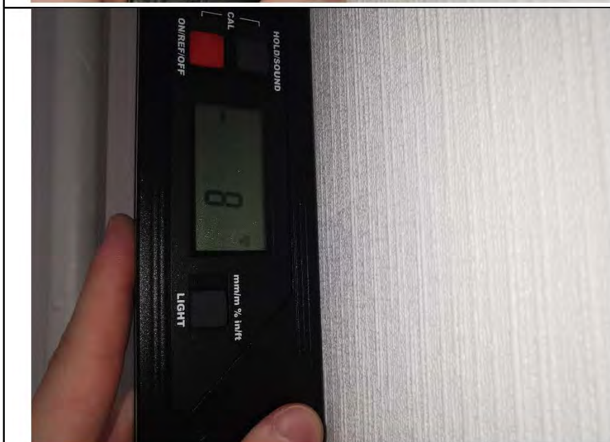
Фото №11. Измерение уровня стен на кухне.
