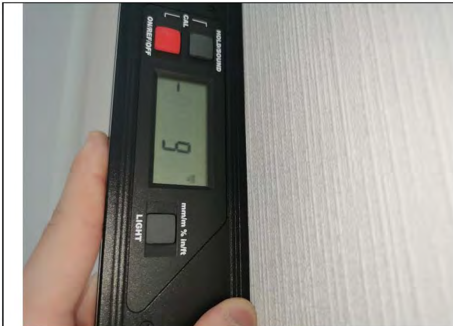
Фото №10. Измерение уровня стен в спальне.
