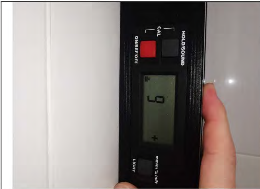
Фото №16. Измерение уровня стен в ванной комнате.
