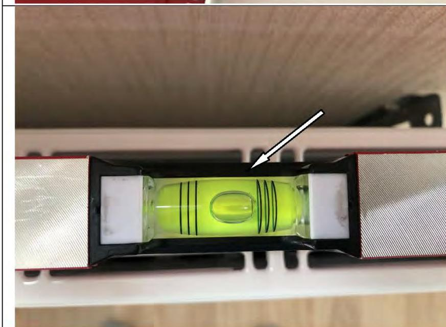
Фото №69. Неровно смонтирован отопительный прибор в спальне в квартире.
