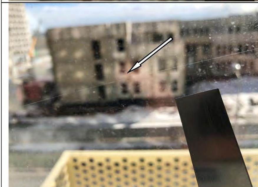
Фото №59. Царапина на стеклопакете оконного блока ПВХ в кухне в квартире.
