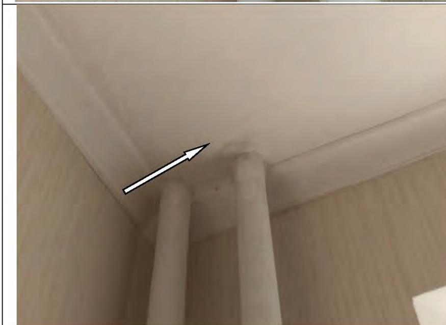
Фото №27. Неровности, подтеки на окрашенном потолке в кухне в квартире.
