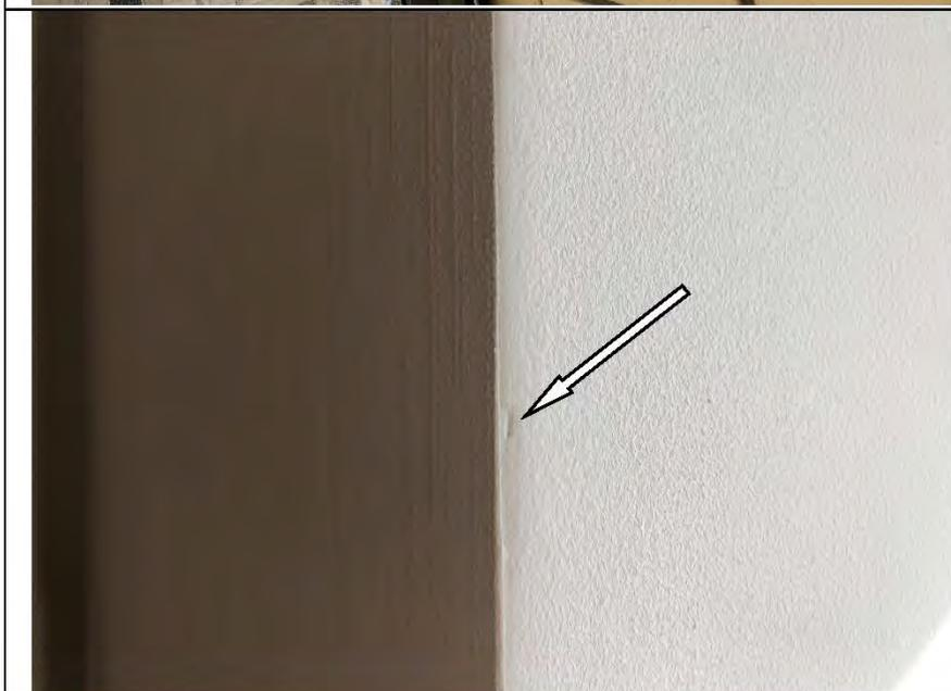
Фото №65. Неровности, сколы на окрашенных откосах оконного блока ПВХ в спальне в квартире.
