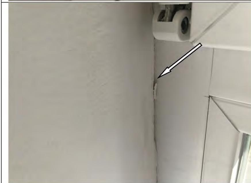
Фото №63. Инфильтрация оконного блока ПВХ в кухне в квартире.
