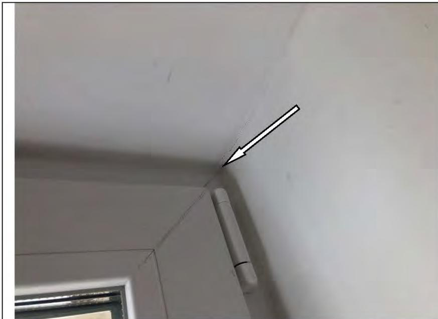
Фото №61. Инфильтрация оконного блока ПВХ в спальне в квартире.
