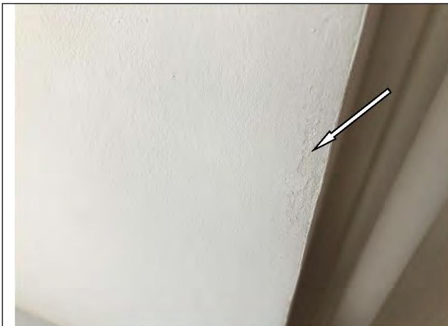
Фото №67. Неровности, сколы на окрашенных откосах оконного блока ПВХ в кухне в квартире.
