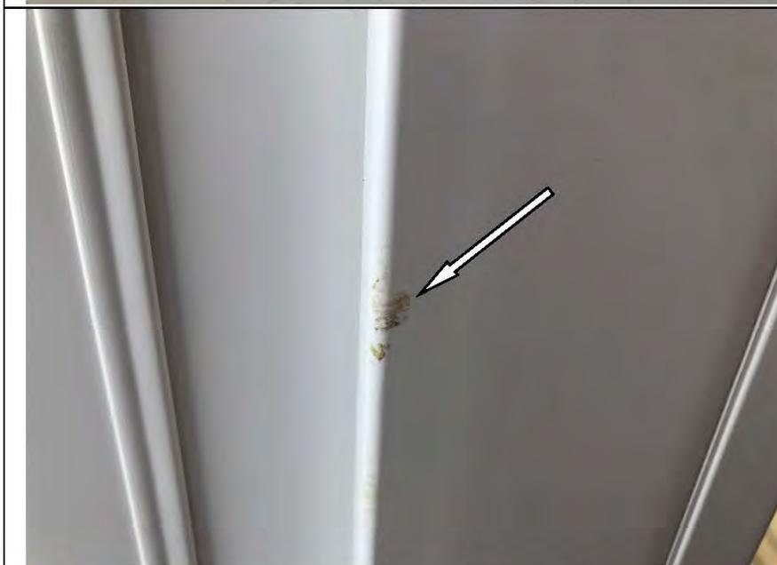
Фото №53. Загрязнения на профиле оконного блока ПВХ в спальне в квартире.
