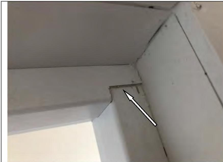
Фото №22. Дефект на коробке деревянного дверного блока в спальне в квартире.
