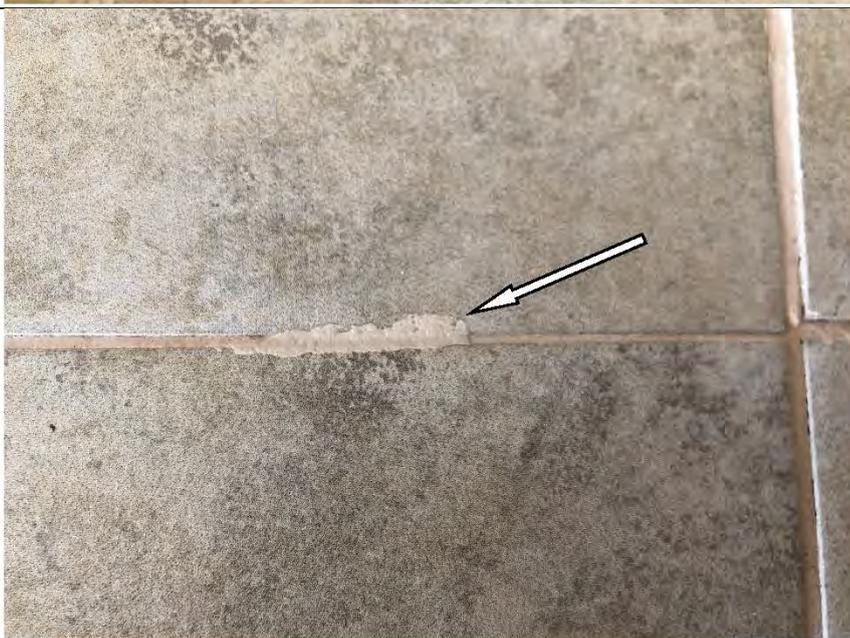
Фото №30. Загрязнения на напольной керамической плитке в кухне в квартире.
