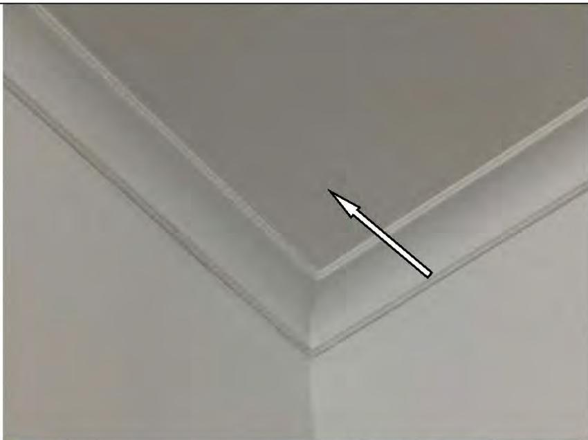
Фото №28. Неровности, подтеки на окрашенном потолке в ванной комнате в квартире.
