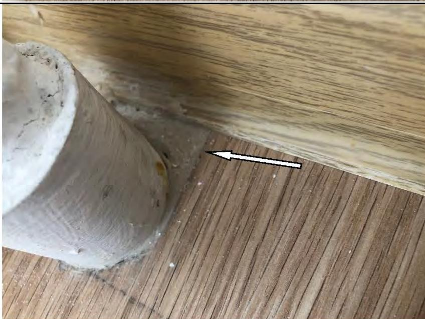
Фото №44. Дефект вставки труб отопления в напольное покрытие из ламината в кухне в квартире.
