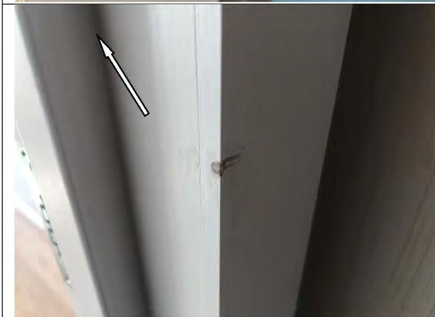
Фото №24. Дефект на коробке деревянного дверного блока в ванной комнате в квартире.
