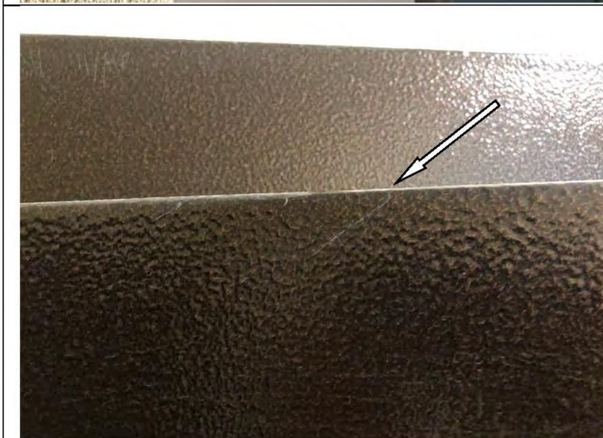
Фото №18. Дефект на полотне входной двери в коридоре в квартире.
