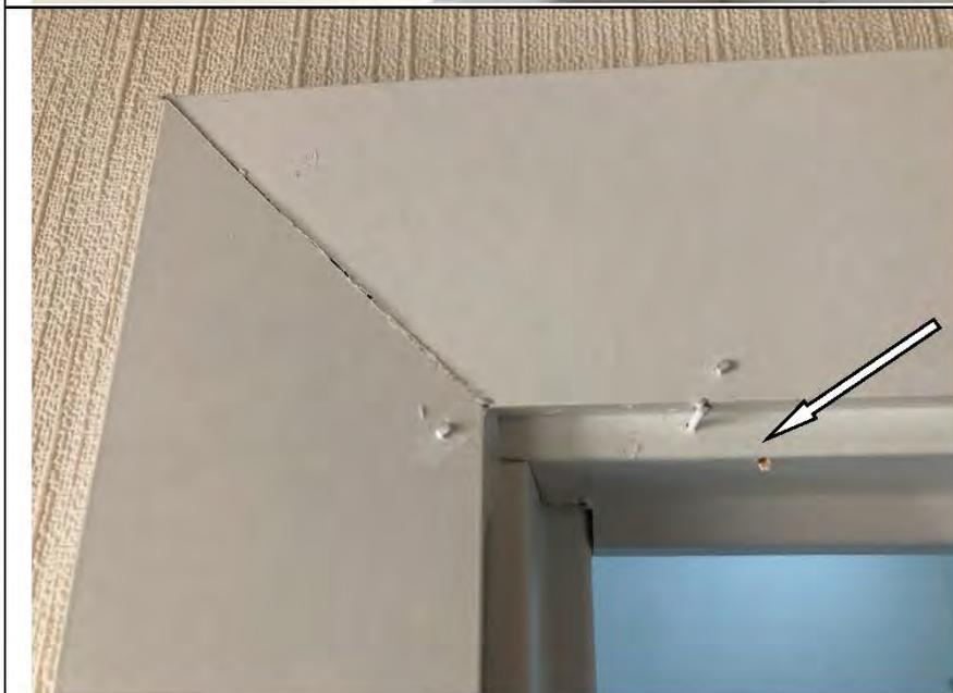
Фото №23. Дефект на коробке деревянного дверного блока в кухне в квартире.
