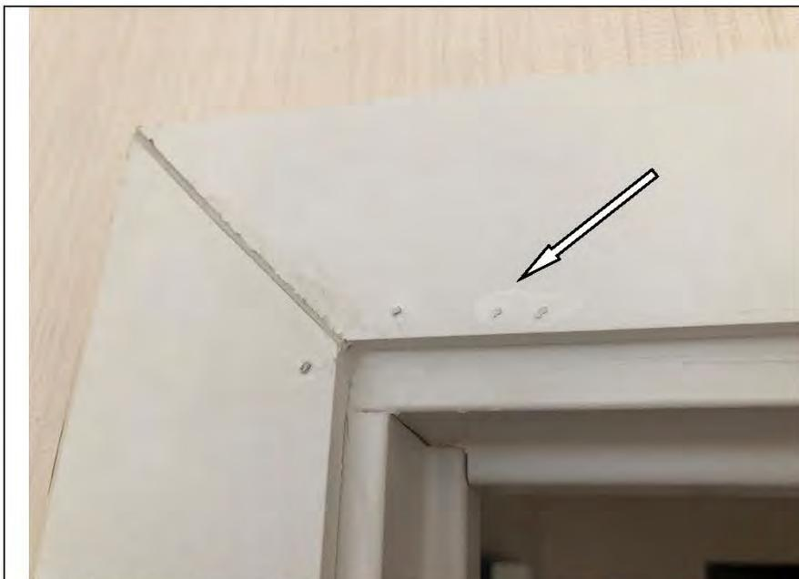
Фото №16. Загрязнения на наличнике деревянного дверного блока в кухне в квартире.
