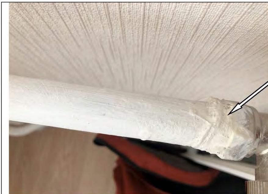
Фото №46. Неровности, сколы на окрашенных трубах отопления в кухне в квартире.
