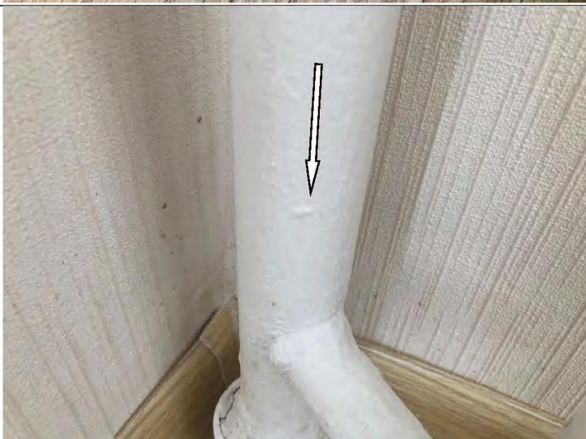
Фото №45. Неровности, сколы на окрашенных трубах отопления в спальне в квартире.
