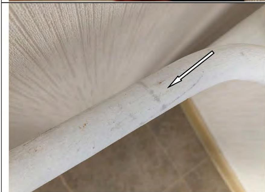
Фото №47. Неровности, сколы на окрашенных трубах отопления в кухне в квартире.
