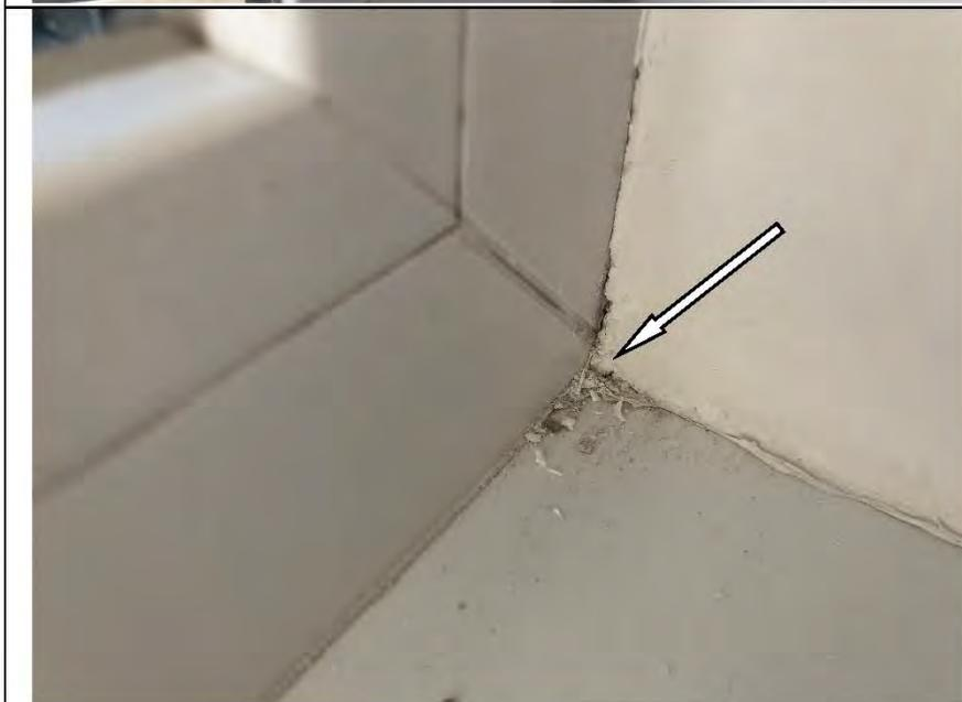
Фото №62. Инфильтрация оконного блока ПВХ в кухне в квартире.
