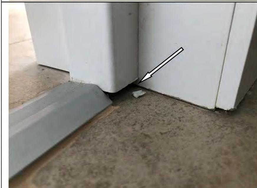
Фото №74. Наличник деревянного дверного блока не достает до напольного покрытия в ванной комнате в квартире.
