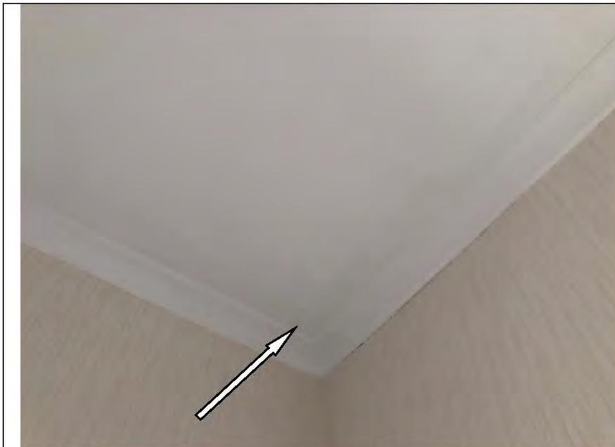
Фото №25. Неровности, подтеки на окрашенном потолке в коридоре в квартире.
