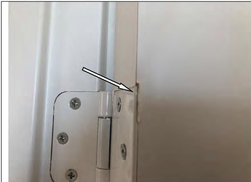
Фото №19. Скол на коробке деревянного дверного блока в спальне в квартире.
