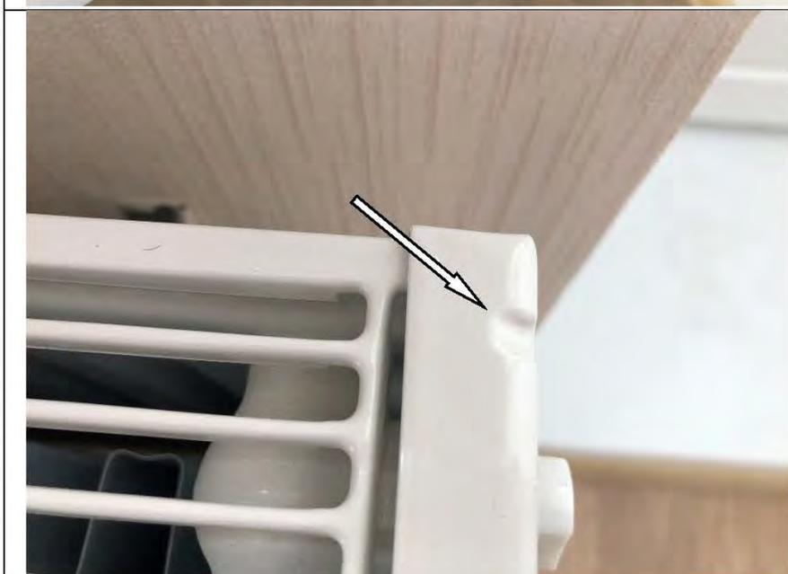
Фото №48. Дефект на кожухе отопительного прибора в спальне в квартире.
