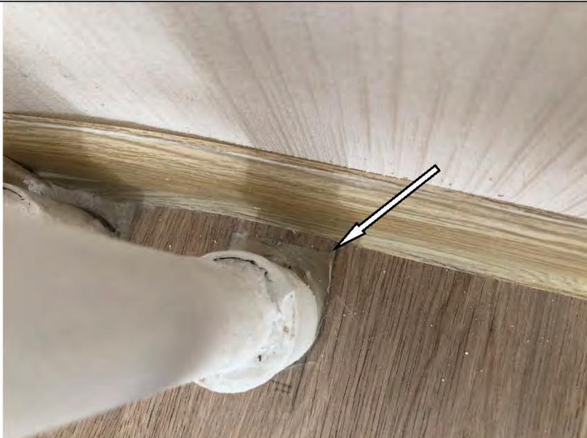
Фото №43. Дефект вставки труб отопления в напольное покрытие из ламината в спальне в квартире.
