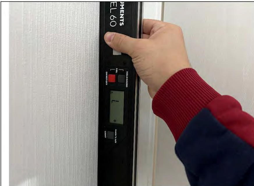
Фото №7. Измерение уровня стен в кухне.
