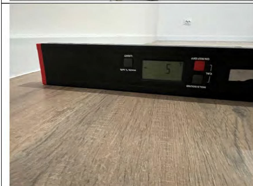
Фото №23. Измерение уровня напольного покрытия в спальне.
