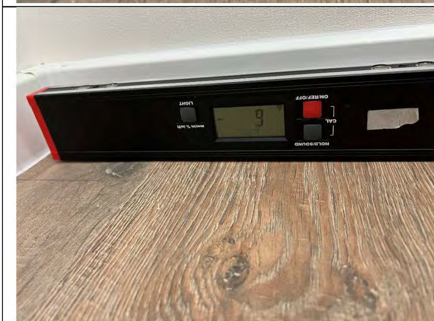
Фото №24. Измерение уровня напольного покрытия в гардеробной.
