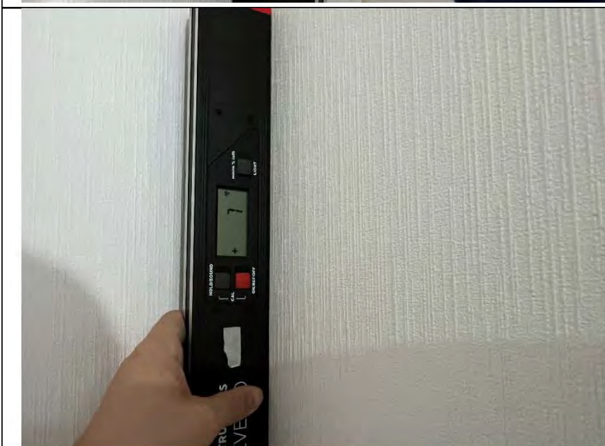
Фото №8. Измерение уровня стен в спальне.
