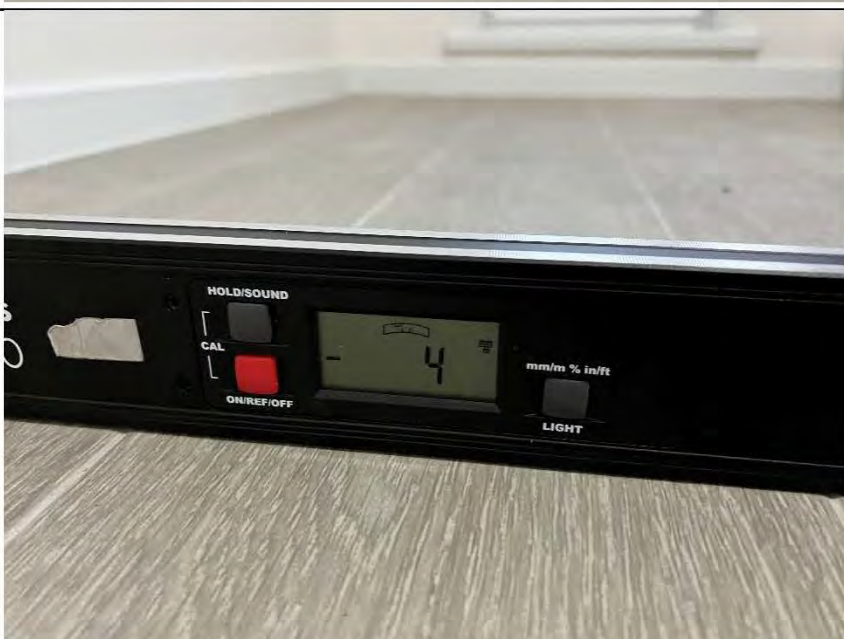
Фото №27. Измерение уровня напольного покрытия в кухне.
