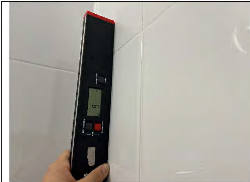
Фото №19. Измерение уровня стен в ванной комнате.
