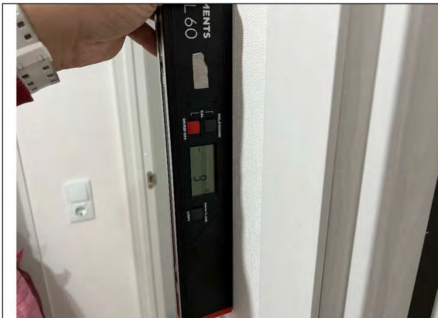
Фото №10. Измерение уровня стен в прихожей.
