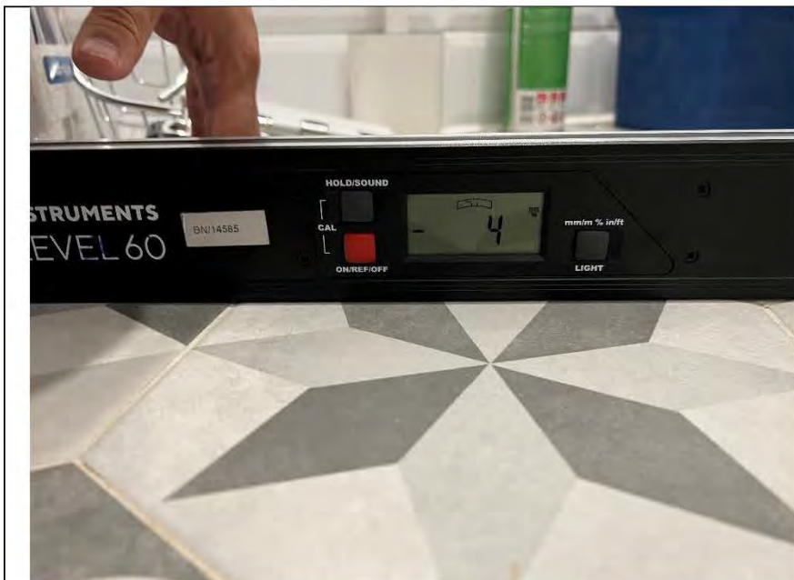
Фото №22. Измерение уровня напольного покрытия в санузле.
