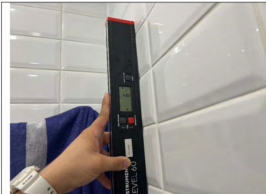
Фото №13. Измерение уровня стен в ванной комнате.
