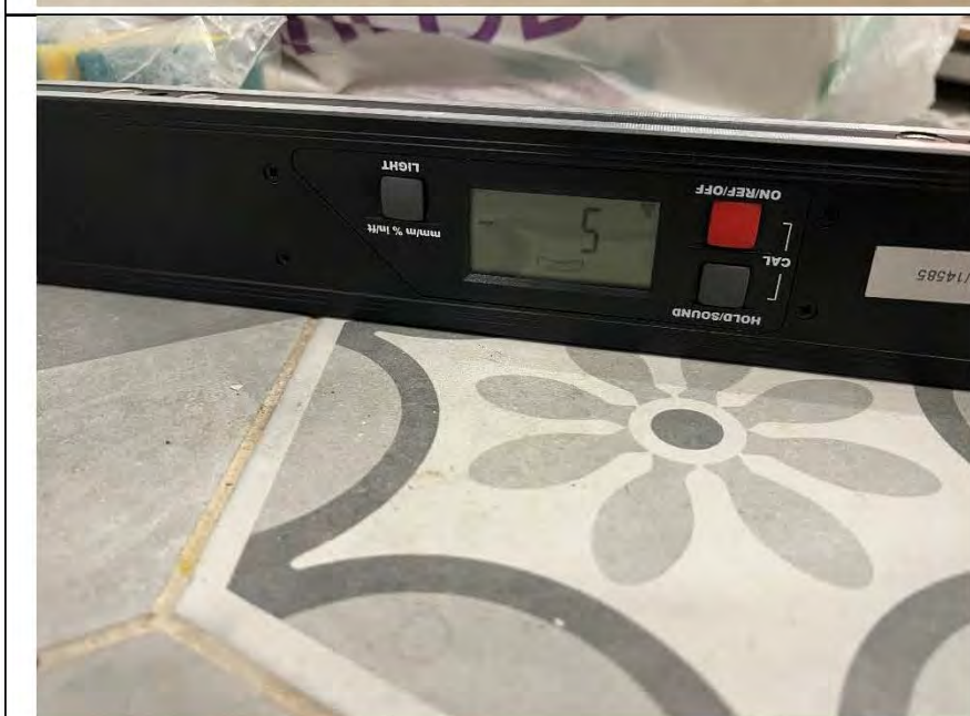
Фото №21. Измерение уровня напольного покрытия в ванной комнате.
