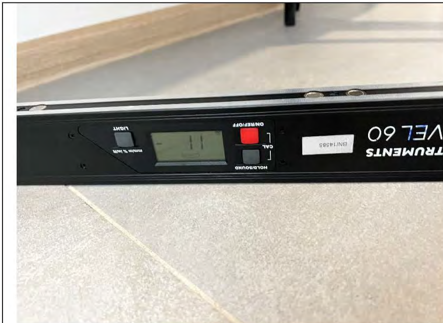
Фото №19. Измерение уровня напольного покрытия в кухне.
