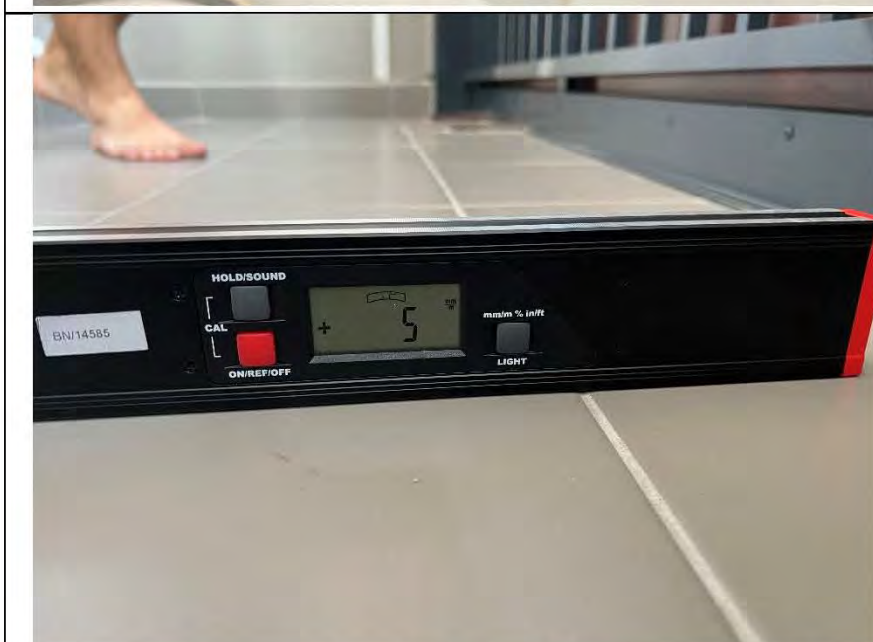
Фото №23. Измерение уровня напольного покрытия на лоджии.
