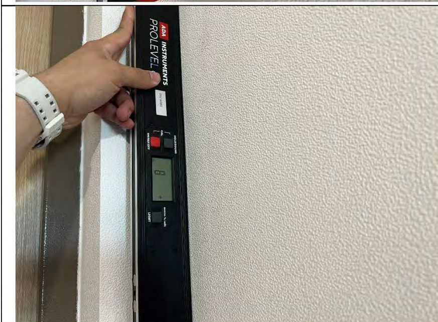
Фото №8. Измерение уровня стен в прихожей.
