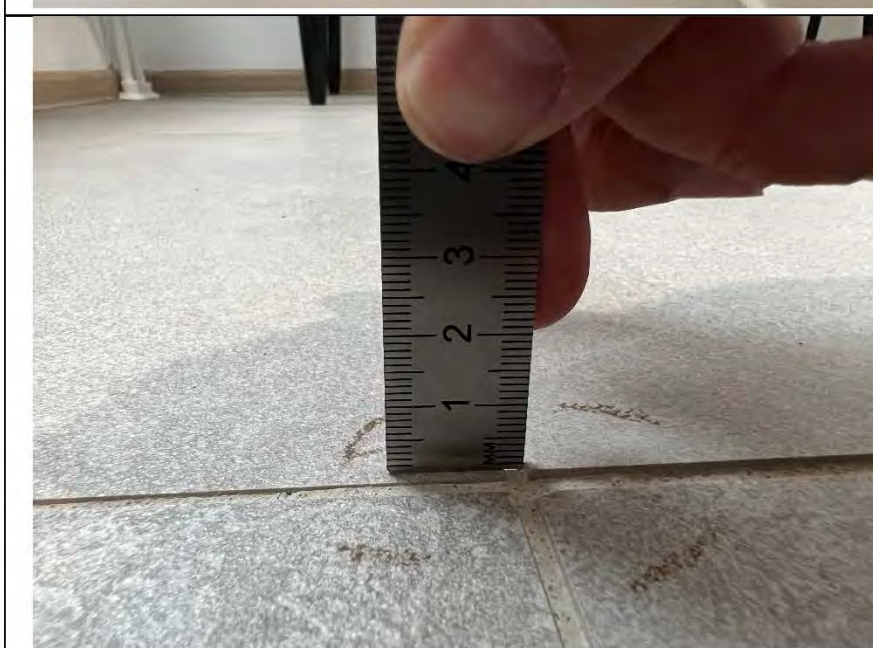
Фото №24. Уступы напольной керамической плитки в кухне равно 2 мм.
