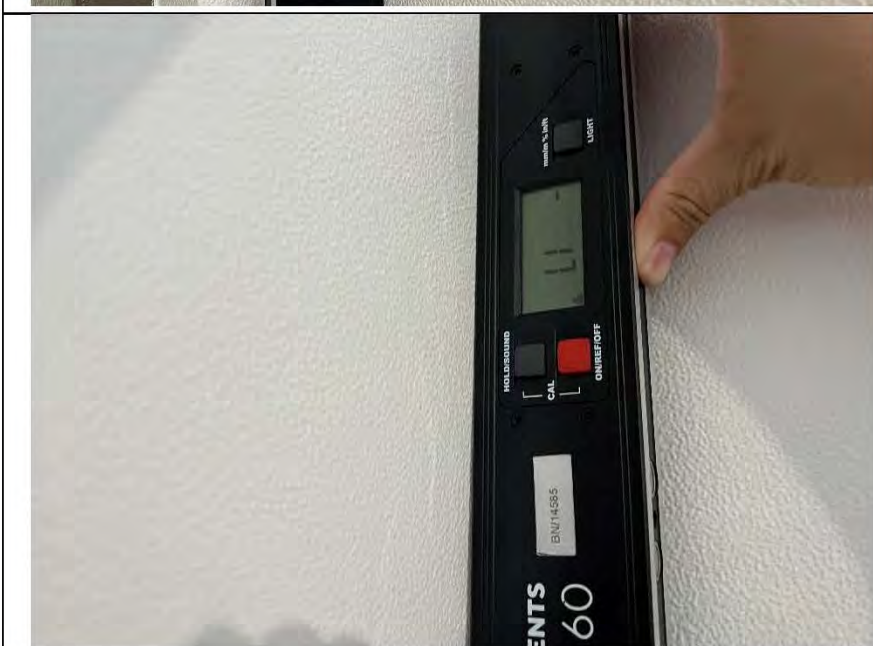
Фото №9. Измерение уровня стен в спальне.
