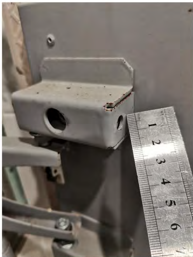
Фото 155-156. Санузел (3,4 кв.м.) 4.14 Следы коррозии на фурнитуре внутренней стороне люка
