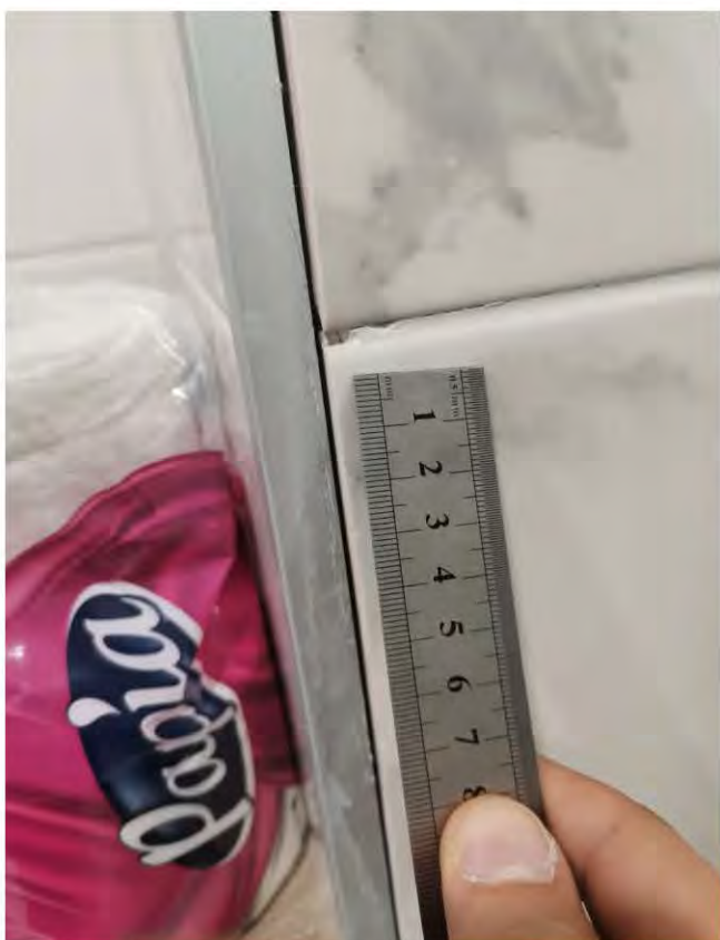
Фото 146-147. Санузел (3,4 кв.м.) 4.10 Отсутствует герметизация по периметру дверки люка
