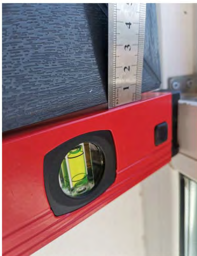
Фото 118-119. Комната (15,7 кв.м.) 3.16 Отклонение кромки оконной створки от плоскости 3,5 мм, 4 мм
