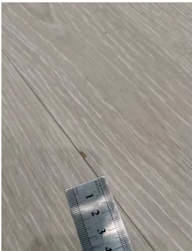
Фото 71-72. Кухня (20,1 кв.м.) 2.9 Наличие сколов на напольном покрытии из ламинированной доски
