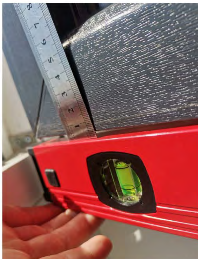
Фото 118-119. Комната (15,7 кв.м.) 3.16 Отклонение кромки оконной створки от плоскости 3,5 мм, 4 мм
