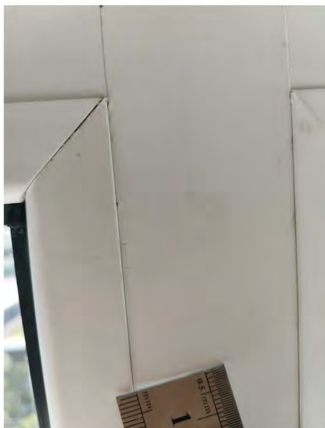
Фото 102-106. Комната (15,7 кв.м.) 3.12 Отслоение штукатурного слоя от основания на оконных откосах
