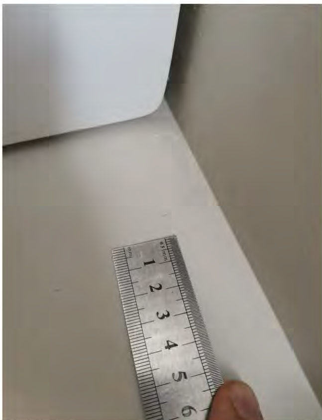
Фото 41-43. Коридор (3,2 кв.м.) 1.10 Некачественно выполнен стык между стеной и потолком
