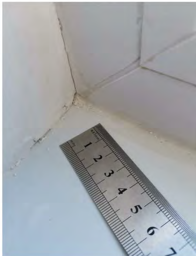
Фото 49. Кухня (20,1 кв.м.) 2.2 Некачественное выполнение оконных откосов: имеется раковина
