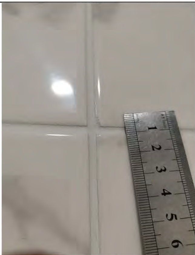
Фото 141. Санузел (3,4 кв.м.) 4.8 Скол на настенной плитке
