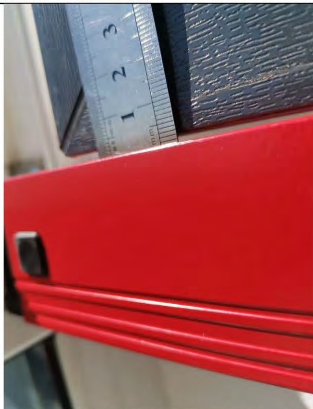
Фото 69-70. Кухня (20,1 кв.м.) 2.8 Отклонение кромки оконной створки от плоскости 5 мм, 2 мм
