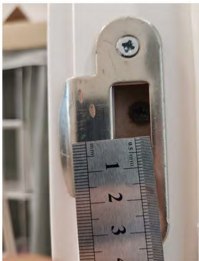
Фото 83-84. Комната (15,7 кв.м.) 3.2 Потертости, сколы, следы коррозии на фурнитуре
