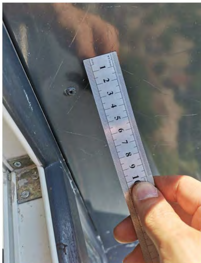
Фото 57-62. Кухня (20,1 кв.м.) 2.5 Наличие царапин, сколов, коррозии на отливах и откосах снаружи
