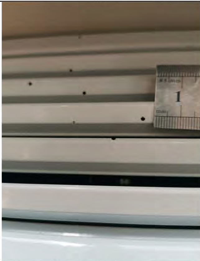
Фото 100. Комната (15,7 кв.м.) 3.10 Окарины на панели радиатора
