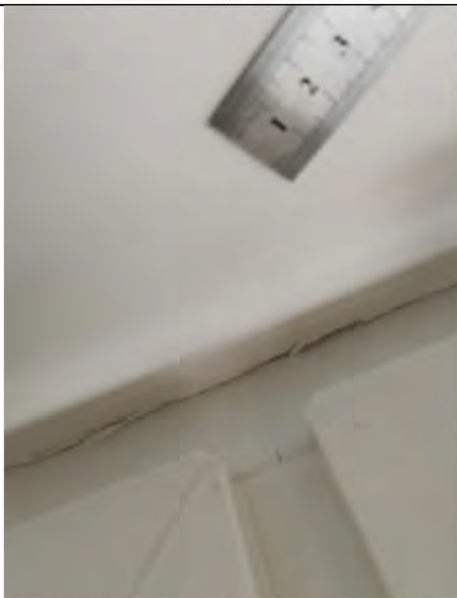
Фото 102-106. Комната (15,7 кв.м.) 3.12 Отслоение штукатурного слоя от основания на оконных откосах
