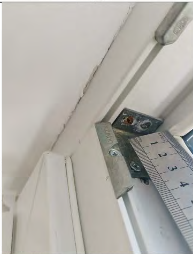
Фото 125-127. Комната (15,7 кв.м.) 3.18 Царапина, следы коррозии на фурнитуре
