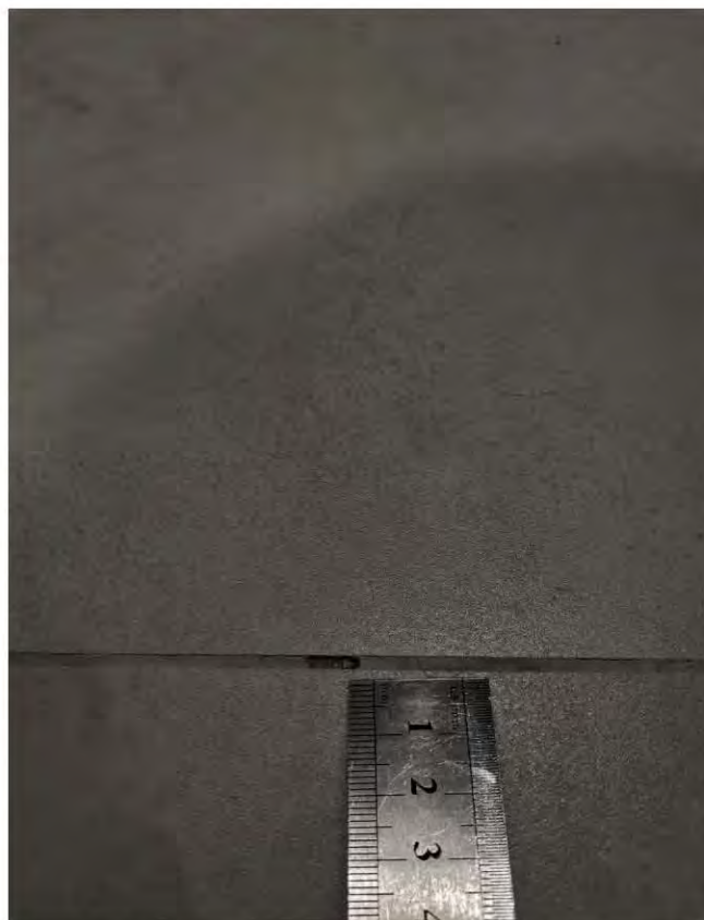
Фото 37-38. Коридор (3,2 кв.м.) 1.8 Некачественная затирка швов на напольной плитке
