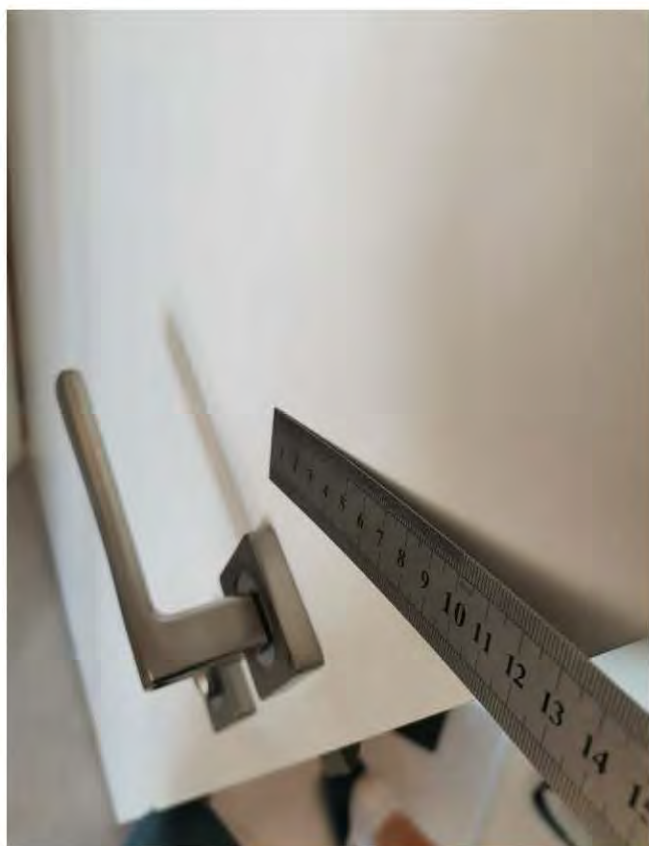
Фото 125-127. Комната (15,7 кв.м.) 3.18 Царапина, следы коррозии на фурнитуре
