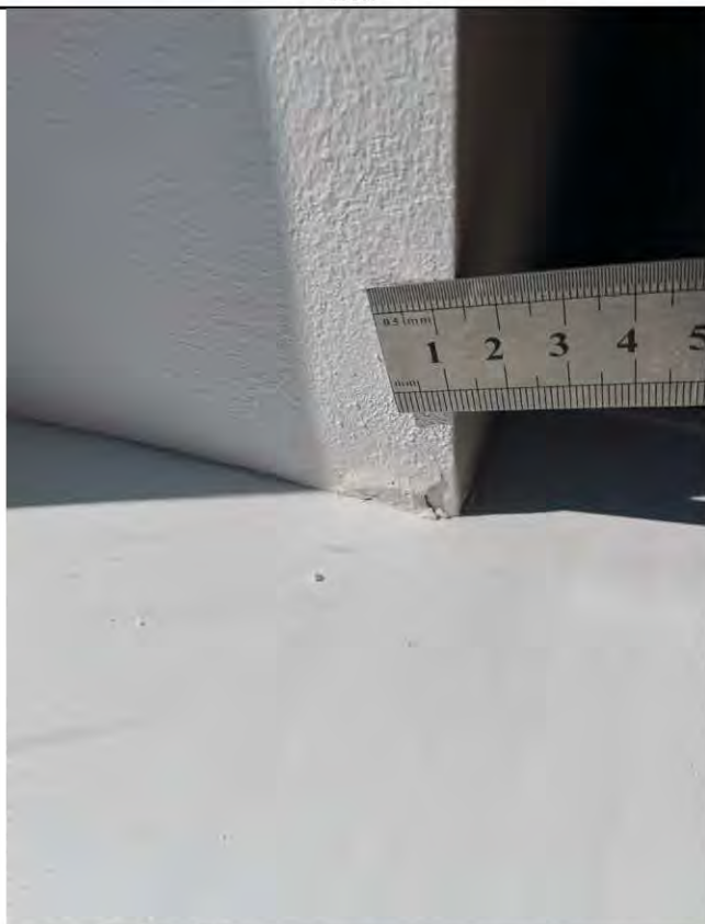
Фото 50-52. Кухня (20,1 кв.м.) 2.3 Отслоение штукатурного слоя от основания на оконных откосах
