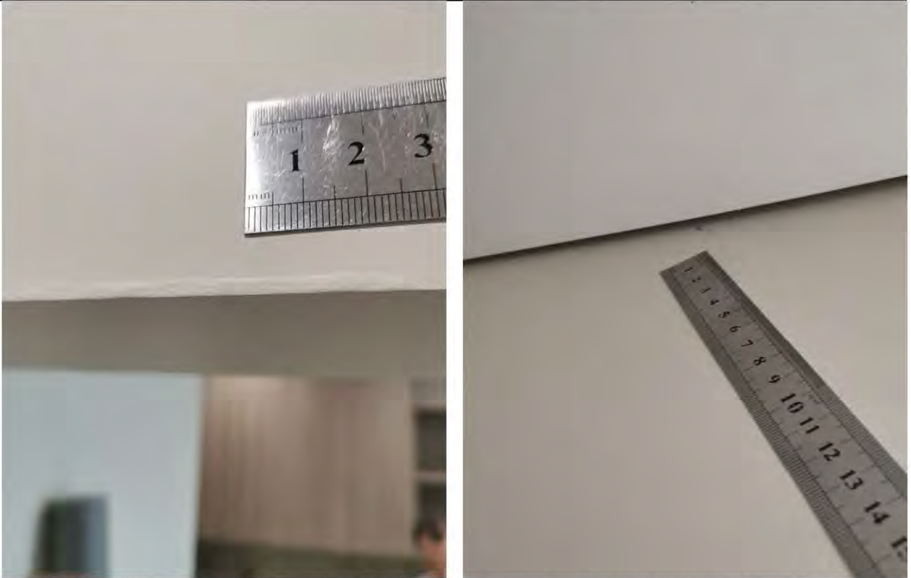
Фото 28-33. Коридор (3,2 кв.м.) 1.5 Локальные участки окрашенных стен имеют: следы от кисти или валика, сколы, царапины, подтек
