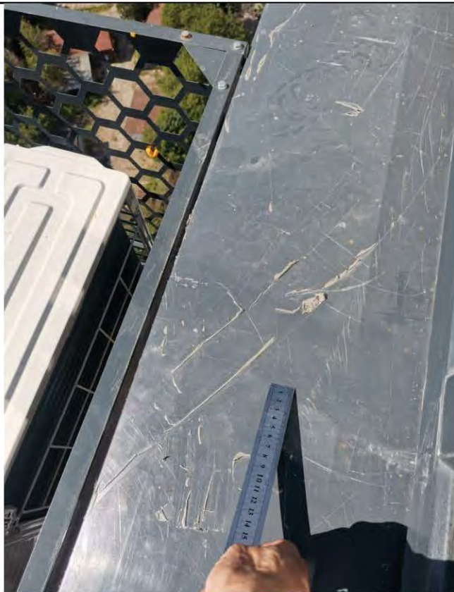
Фото 120-124. Комната (15,7 кв.м.) 3.17 Наличие царапин, коррозии на отливах и откосах снаружи
