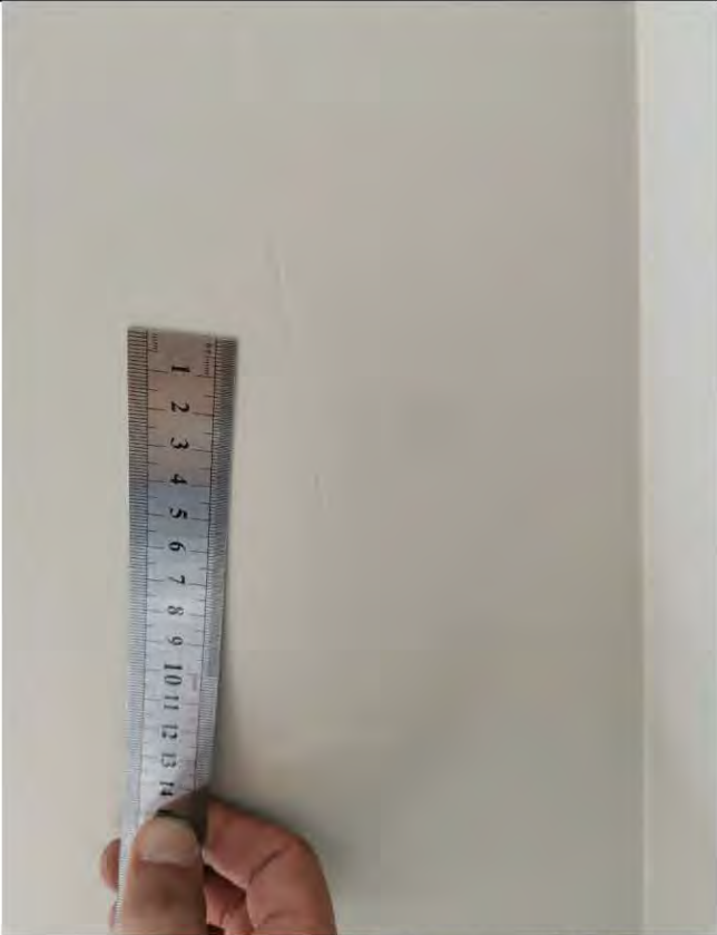
Фото 91-92. Комната (15,7 кв.м.) 3.5 Некачественная подготовка стен
