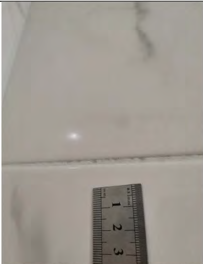
Фото 142-145. Санузел (3,4 кв.м.) 4.9 Некачественная затирка швов на настенной плитке
