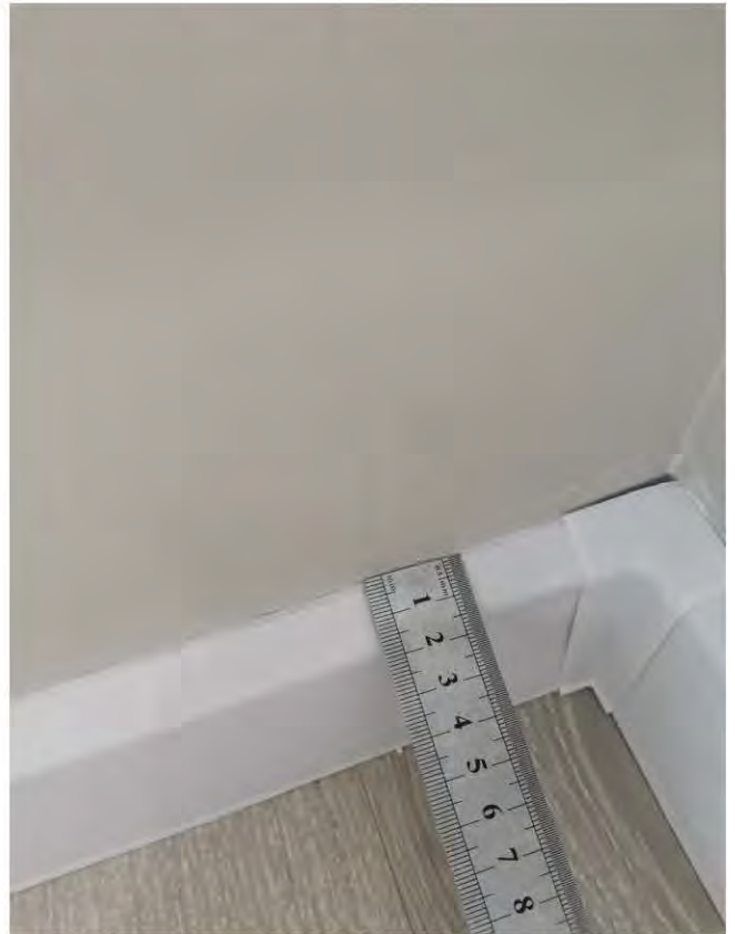
Фото 93-94. Комната (15,7 кв.м.) 3.6 Зазор 1 мм между стеной и напольным плинтусом
