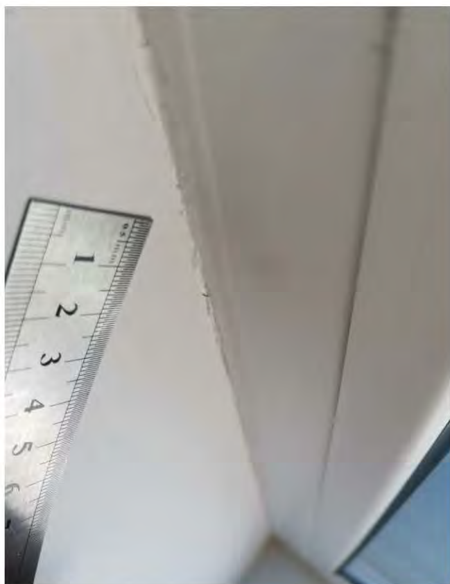
Фото 49. Кухня (20,1 кв.м.) 2.2 Некачественное выполнение оконных откосов: имеется раковина
