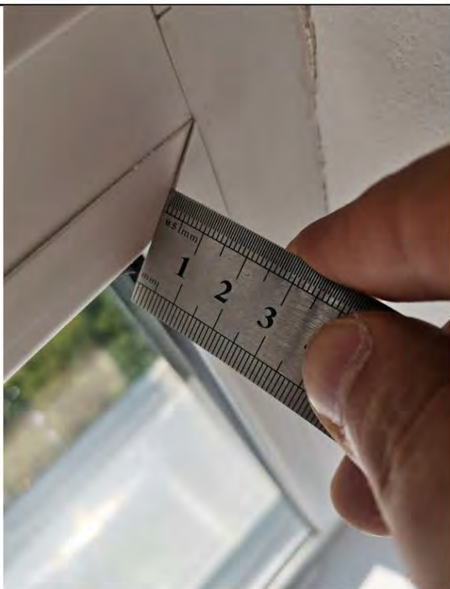
Фото 107-114. Комната (15,7 кв.м.) 3.13 Наличие царапин, потертостей, не соответствия цвета на поверхности оконного блока
