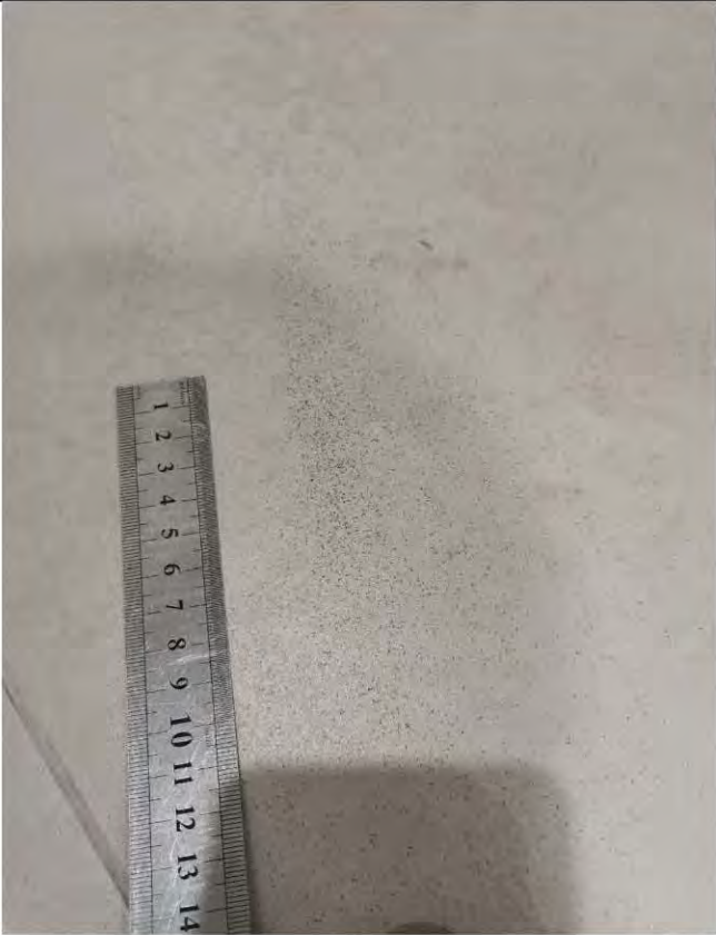
Фото 39-40. Коридор (3,2 кв.м.) 1.9 Наличие окалины на напольном покрытии из керамической плитки
