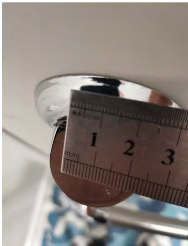
Фото 20-23. Коридор (3,2 кв.м.) 1.2 Царапины на дверной фурнитуре
