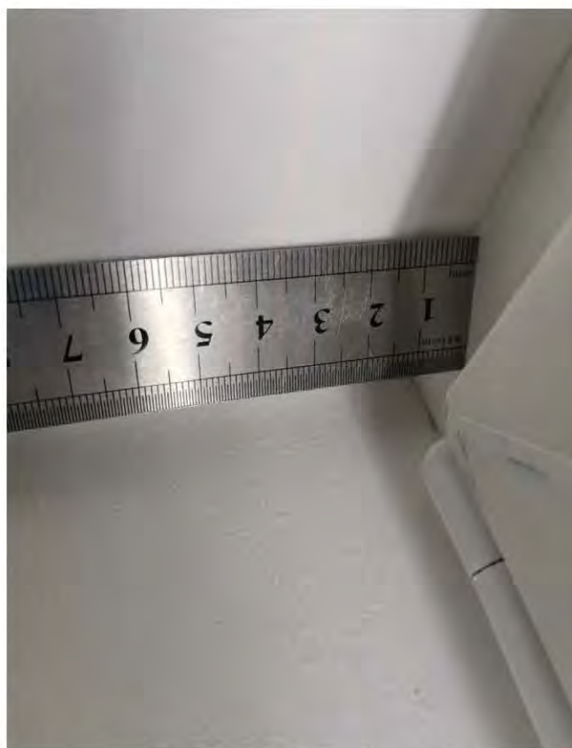
Фото 74-75. Кухня (20,1 кв.м.) 2.11 Отклонение оконного блока от вертикали 5 мм
