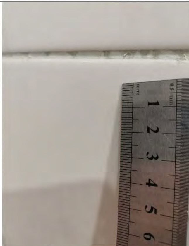
Фото 142-145. Санузел (3,4 кв.м.) 4.9 Некачественная затирка швов на настенной плитке
