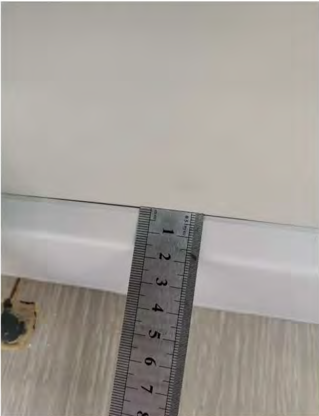
Фото 93-94. Комната (15,7 кв.м.) 3.6 Зазор 1 мм между стеной и напольным плинтусом
