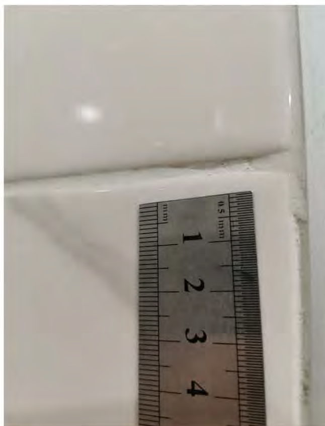
Фото 141. Санузел (3,4 кв.м.) 4.8 Скол на настенной плитке
