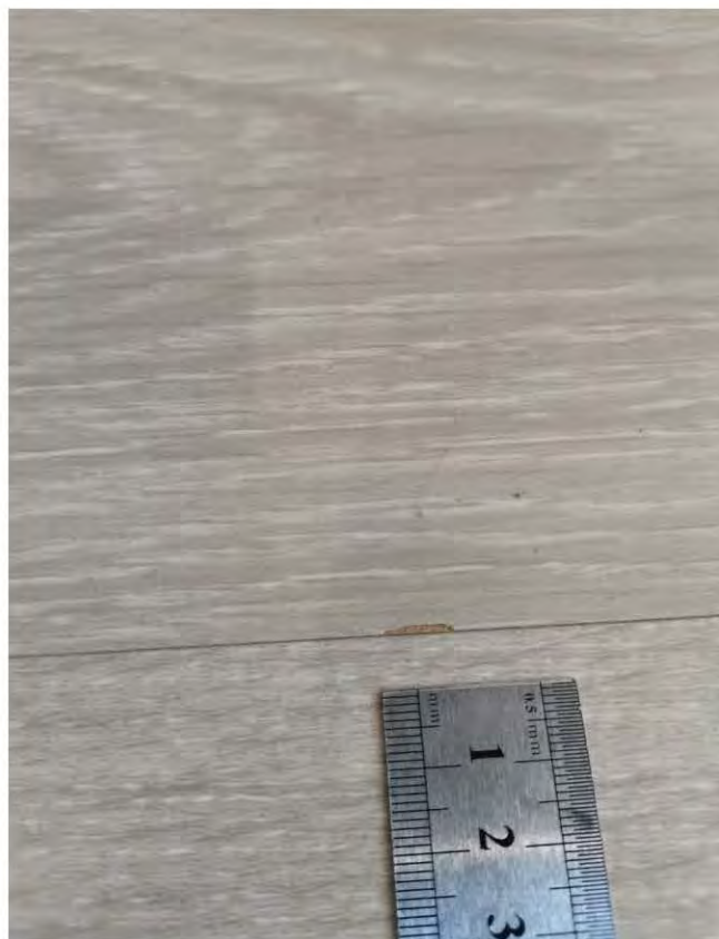
Фото 71-72. Кухня (20,1 кв.м.) 2.9 Наличие сколов на напольном покрытии из ламинированной доски
