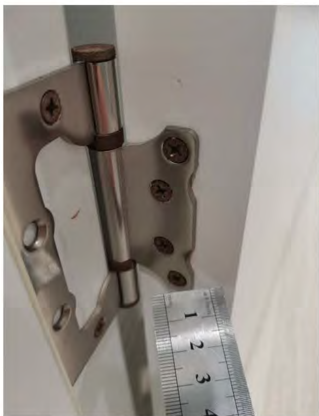
Фото 83-84. Комната (15,7 кв.м.) 3.2 Потертости, сколы, следы коррозии на фурнитуре
