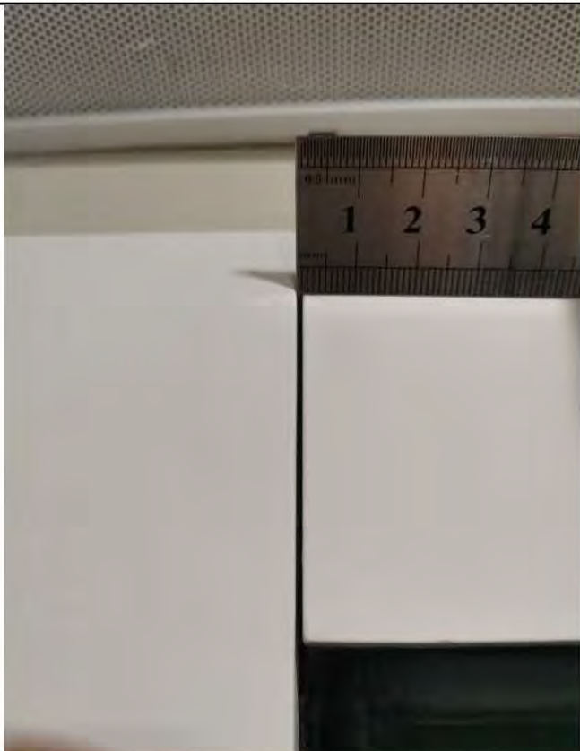
Фото 24-25. Коридор (3,2 кв.м.) 1.3 На дверном блоке имеется зазор 1 мм между смежными элементами
