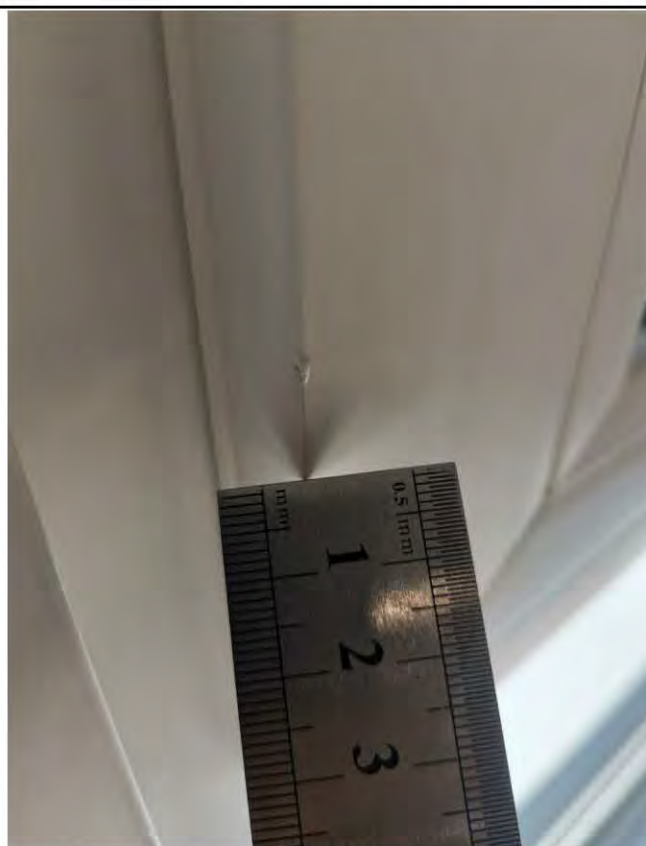
Фото 107-114. Комната (15,7 кв.м.) 3.13 Наличие царапин, потертостей, не соответствия цвета на поверхности оконного блока
