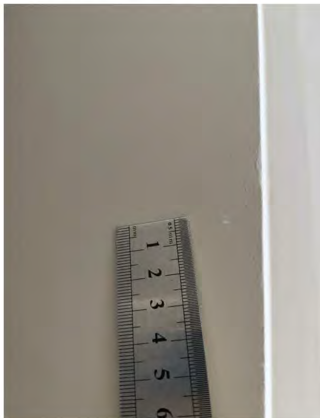
Фото 41-43. Коридор (3,2 кв.м.) 1.10 Некачественно выполнен стык между стеной и потолком
