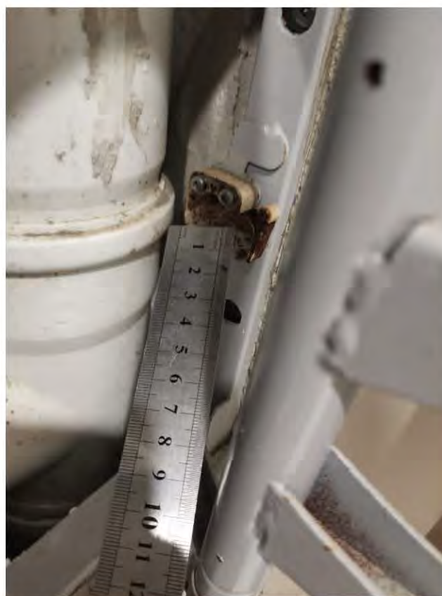
Фото 155-156. Санузел (3,4 кв.м.) 4.14 Следы коррозии на фурнитуре внутренней стороне люка
