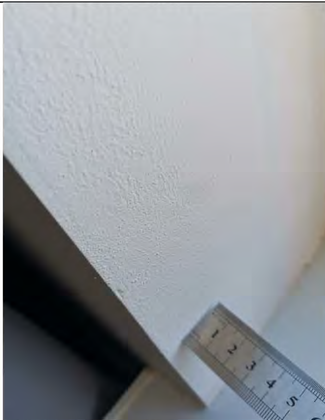
Фото 49. Кухня (20,1 кв.м.) 2.2 Некачественное выполнение оконных откосов: имеется раковина
