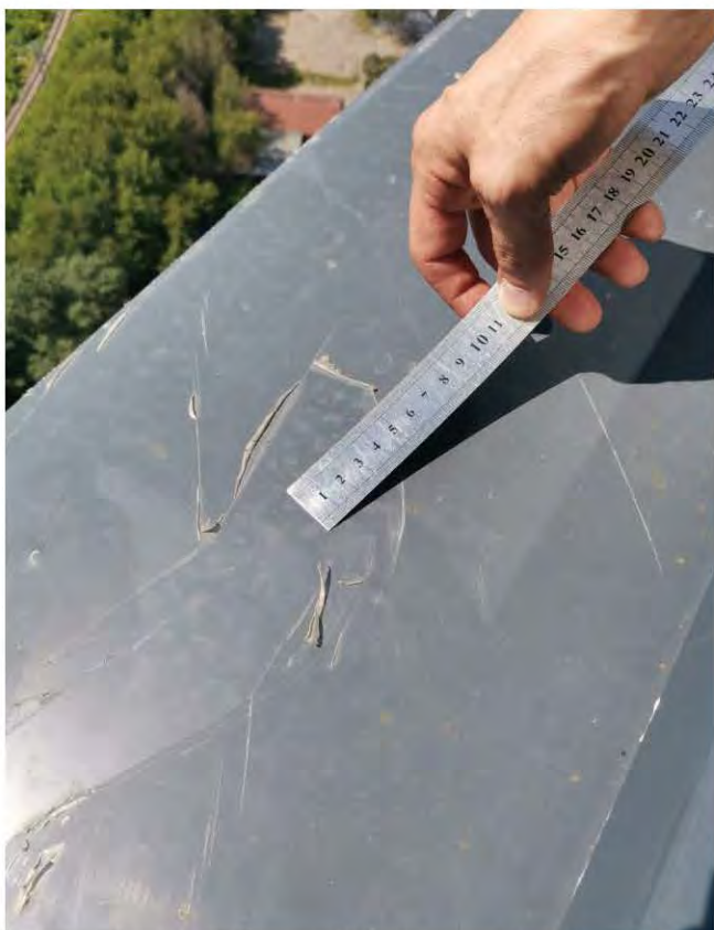
Фото 57-62. Кухня (20,1 кв.м.) 2.5 Наличие царапин, сколов, коррозии на отливах и откосах снаружи
