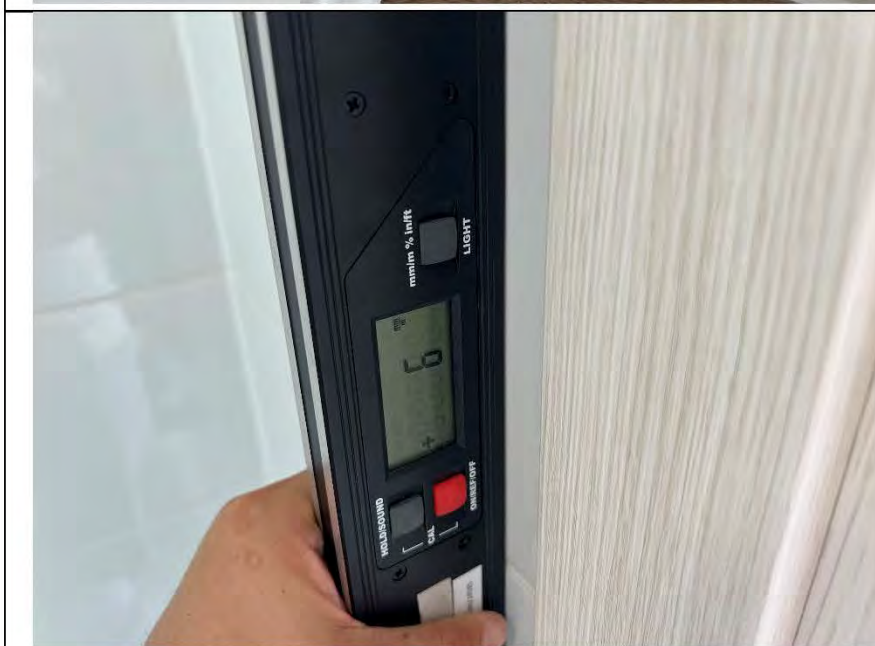
Фото №20. Измерение уровня стен в санузле.
