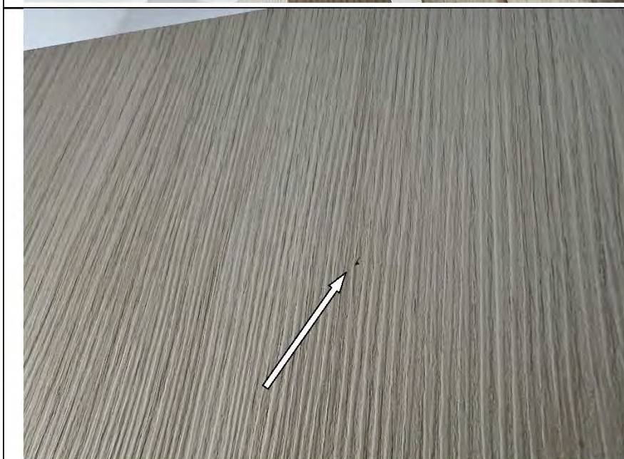
Фото №89. Скол на лицевой поверхности полотна дверного блока в санузле.
