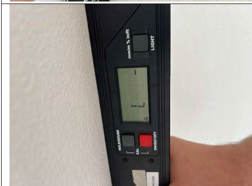
Фото №12. Измерение уровня стен в коридоре.
