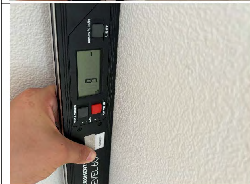
Фото №11. Измерение уровня стен в кухне.
