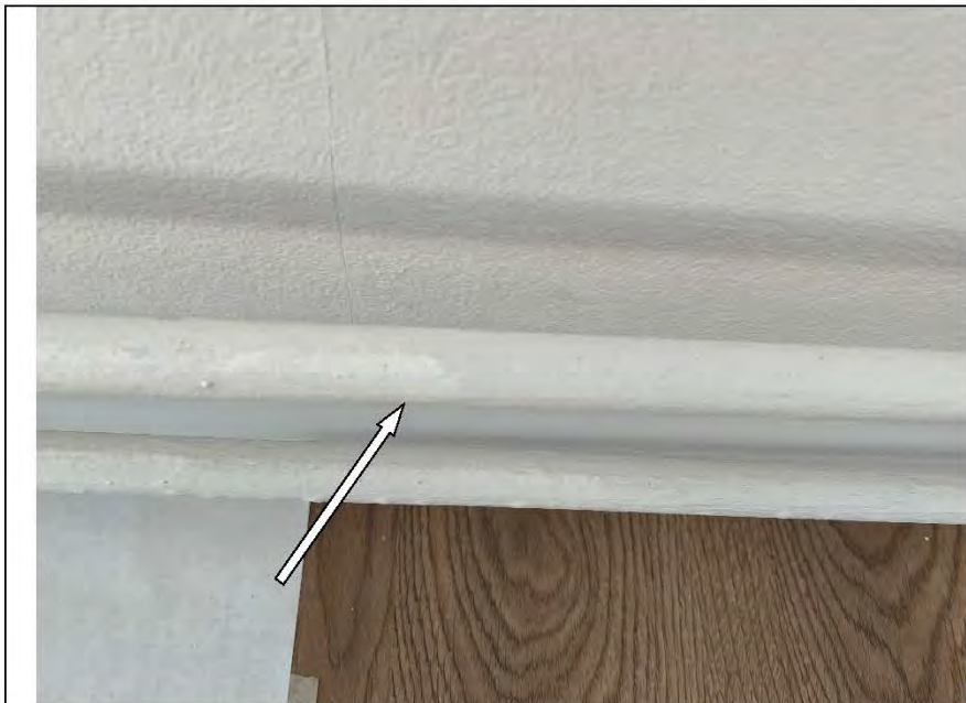
Фото №97. Подтеки краски на трубах отопления в кухне.
