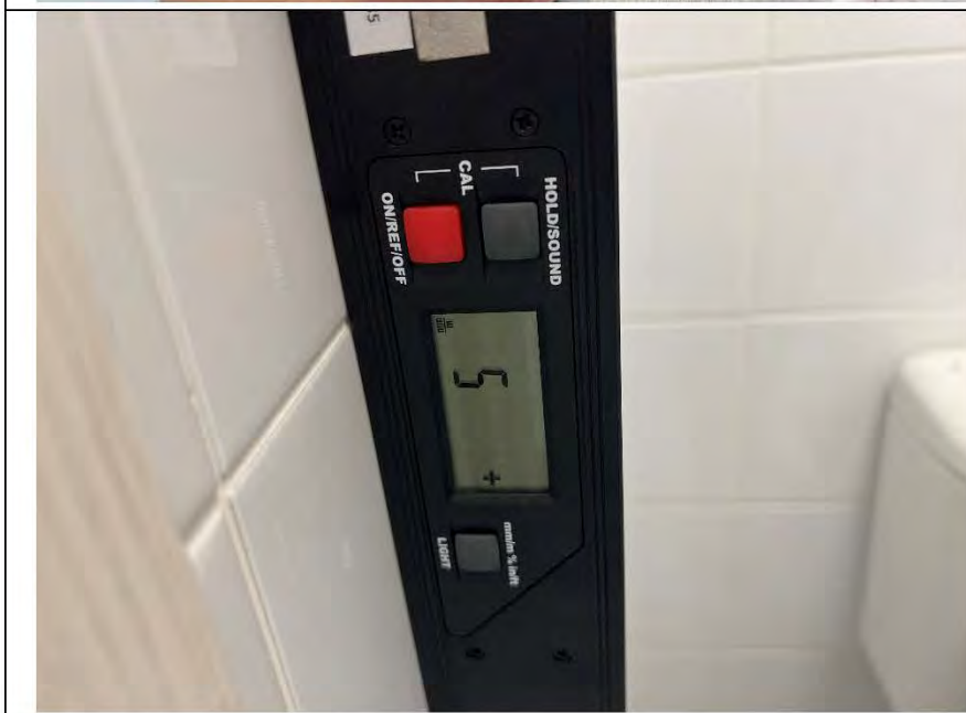
Фото №21. Измерение уровня стен в ванной комнате.
