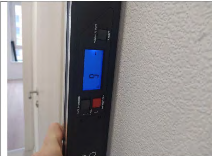
Фото №7. Измерение уровня стен в прихожей.
