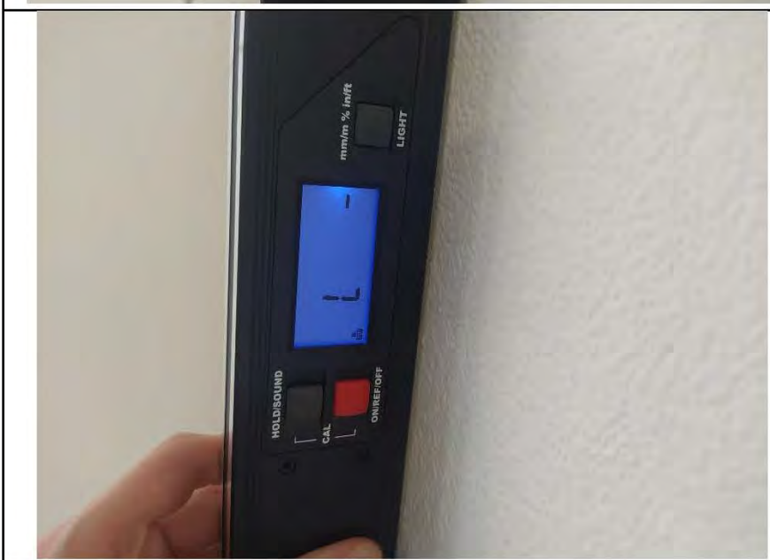
Фото №6. Измерение уровня стен в кухне.
