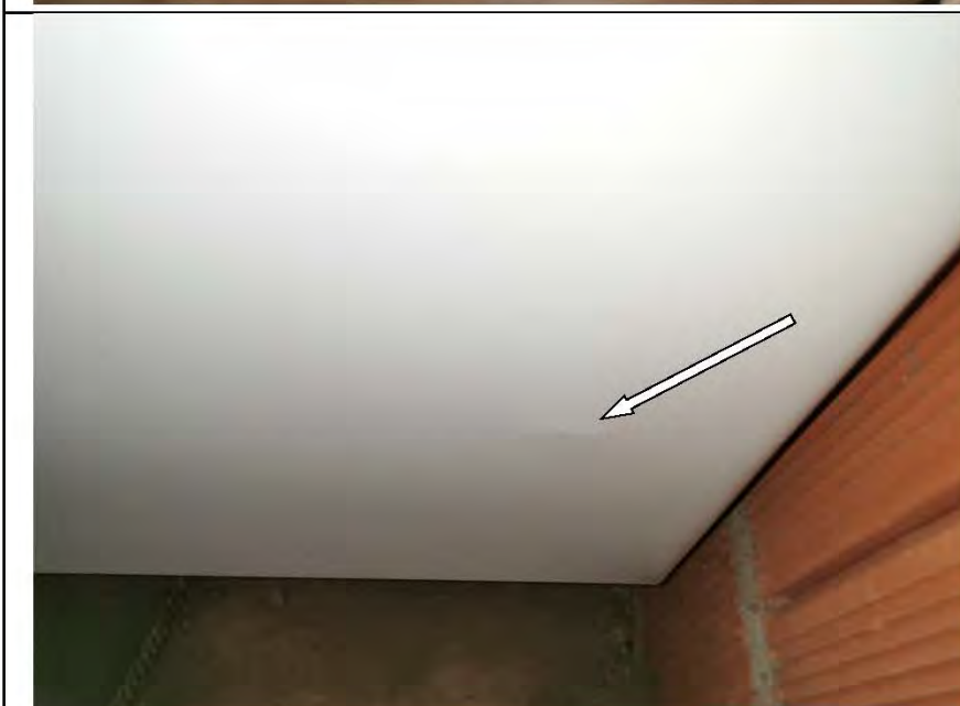
Фото №27. Вмятины на кожухе отопительного прибора.
