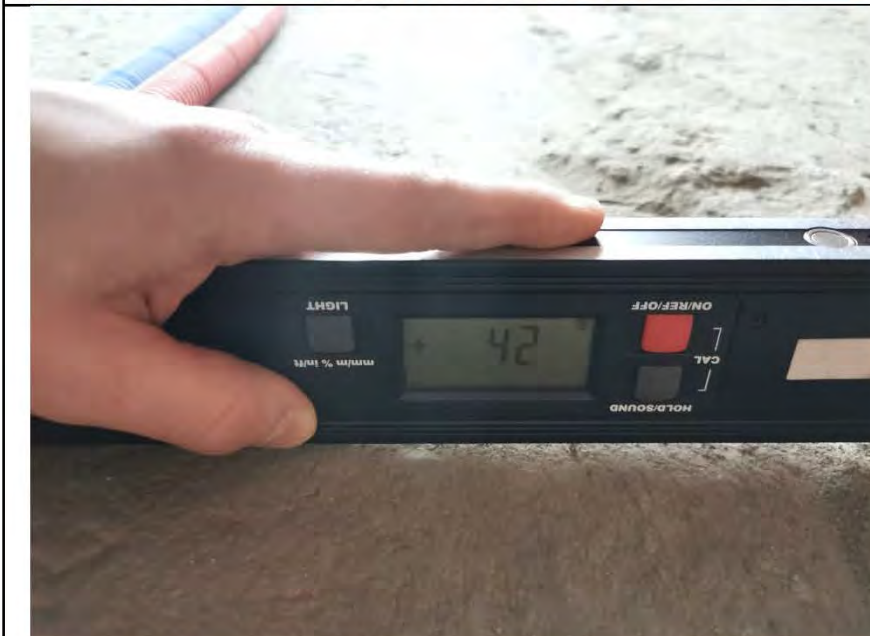
Фото №11. Измерение уровня пола в помещении.
