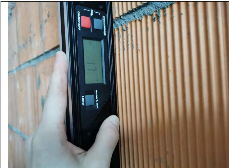
Фото №4. Измерение уровня стен в помещении.
