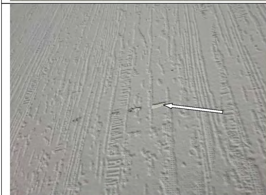
Фото №14. Скол обоевого полотна в коридоре.
