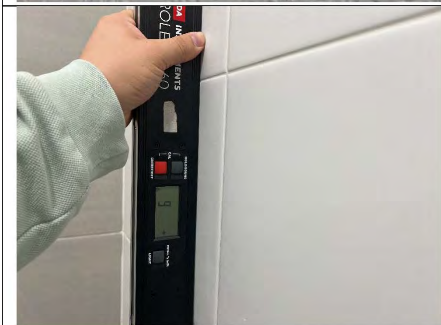
Фото №15. Измерение уровня стен в санузле.
