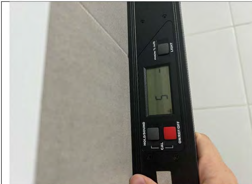
Фото №16. Измерение уровня стен в ванной комнате.
