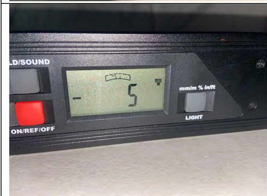
Фото №17. Отклонения поверхности напольного покрытия из керамической плитки в ванной комнате.
