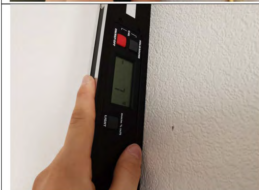
Фото №11. Измерение уровня стен в спальне.
