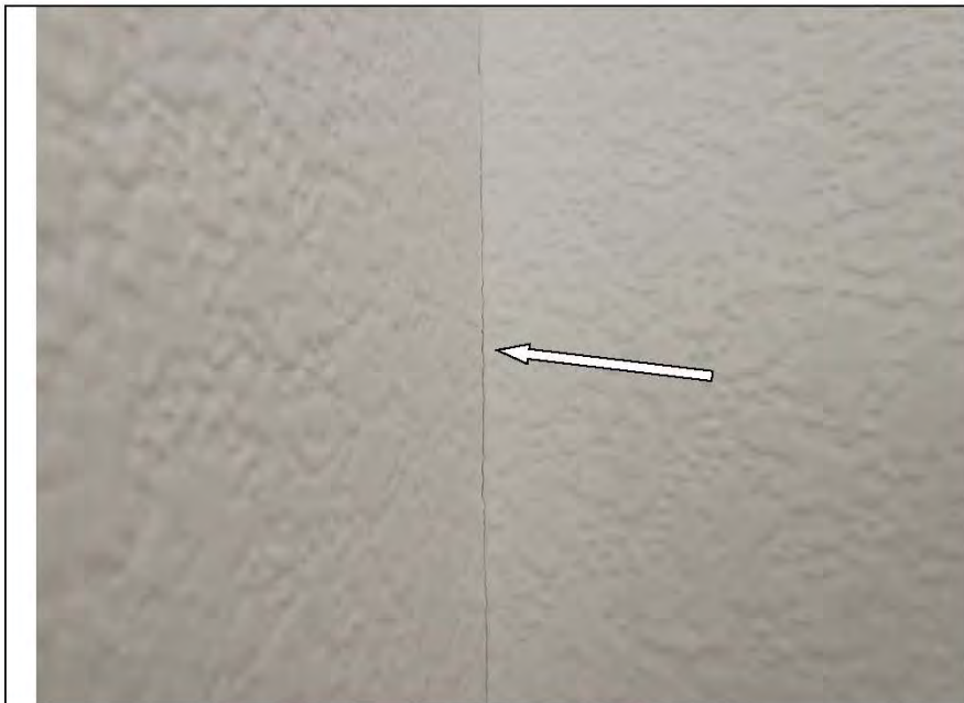
Фото №19. Читаемые обойные стыки в кухне.
