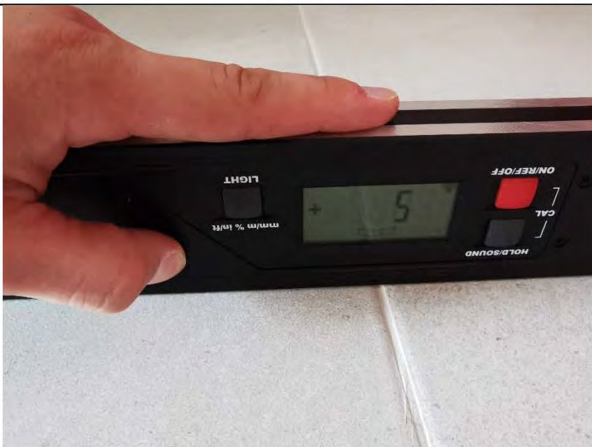
Фото №33. Измерение уровня напольного покрытия в кухне.
