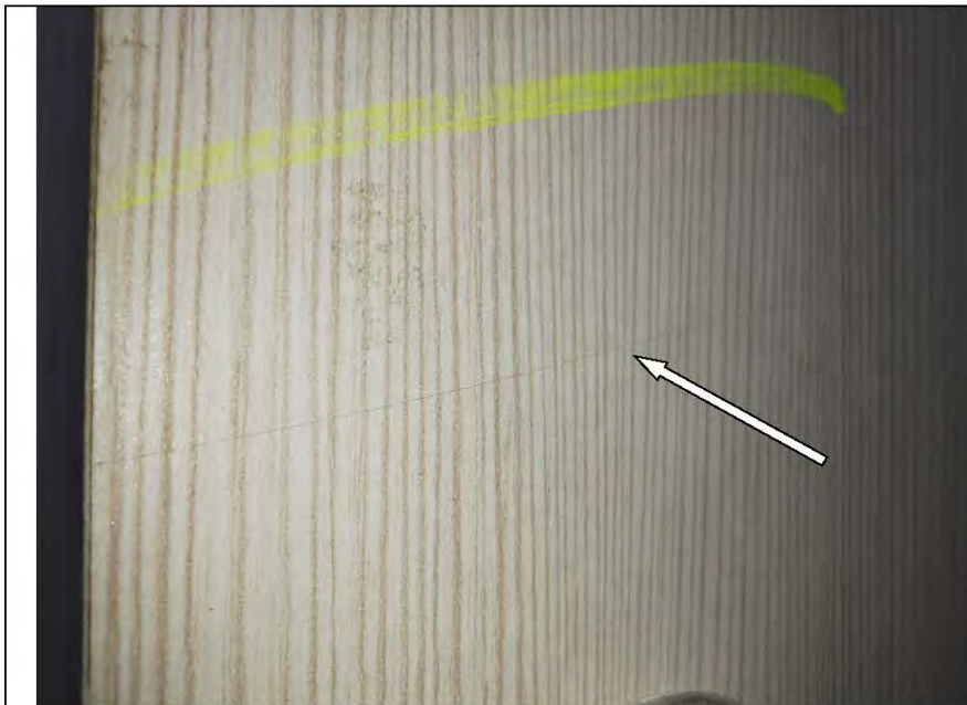
Фото №73. Царапина на полотне деревянного дверного блока в гостиной.
