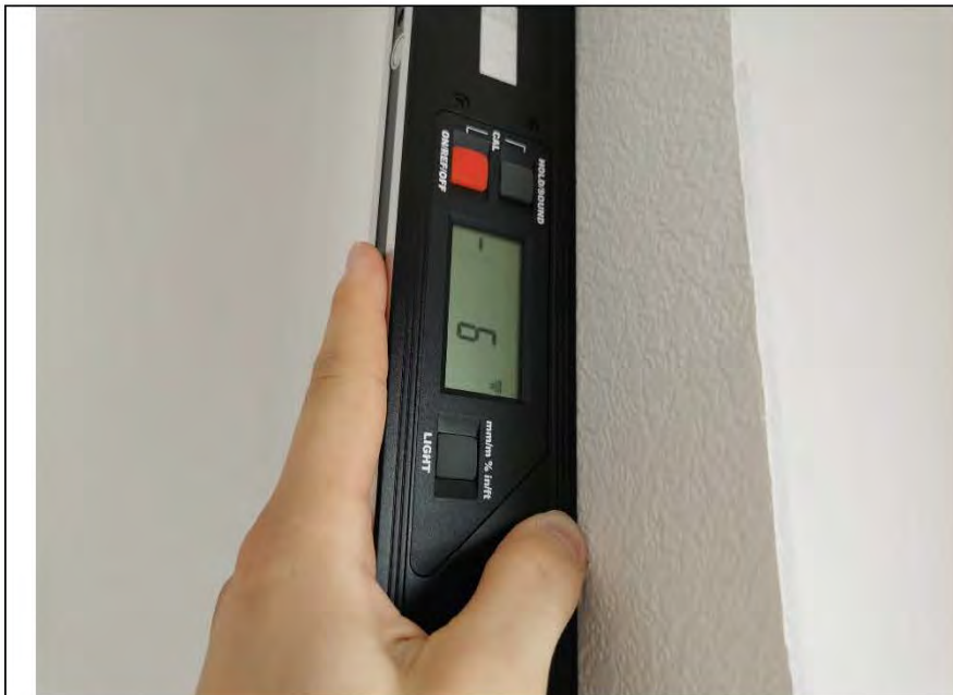
Фото №13. Измерение уровня стен в кухне.
