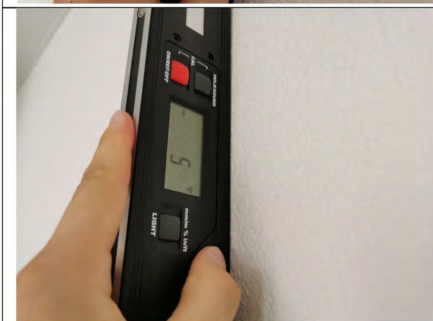
Фото №12. Измерение уровня стен в гостиной.
