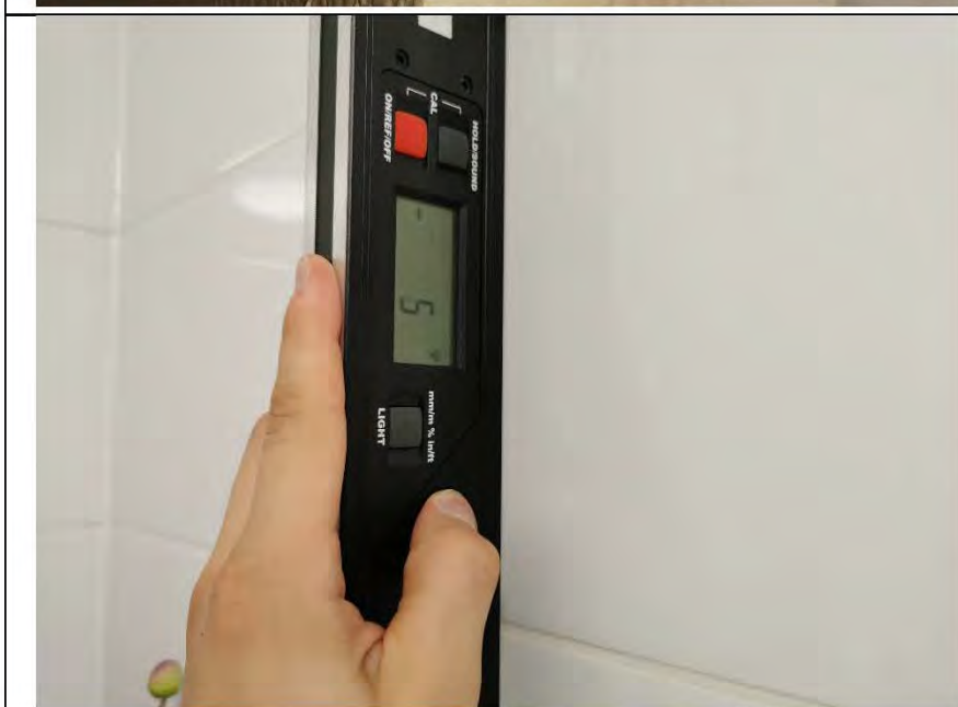
Фото №21. Измерение уровня стен в ванной комнате.
