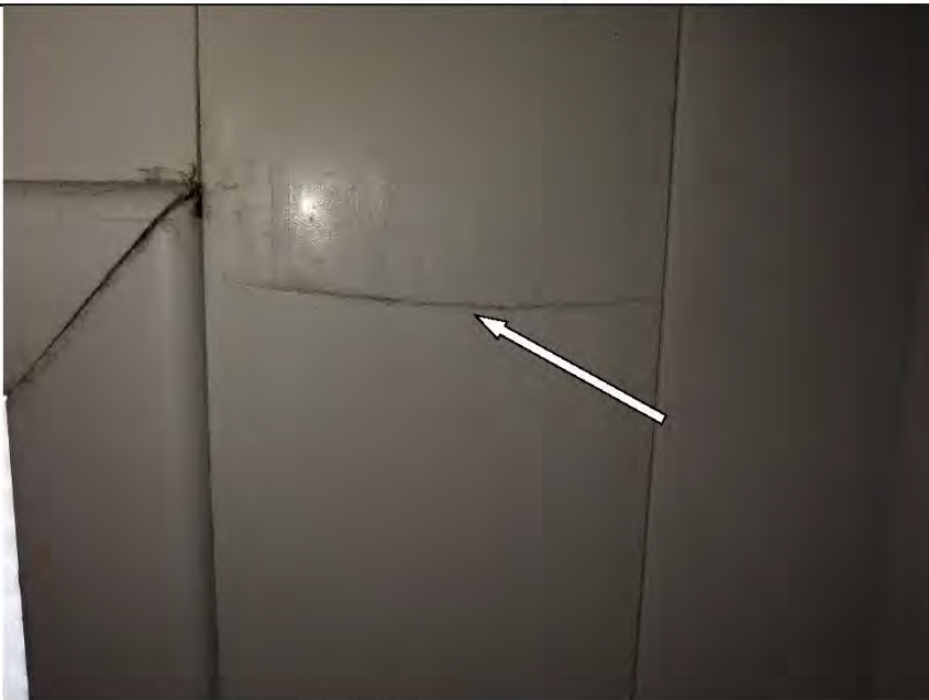
Фото №54. Царапины на лицевой поверхности профиля ПВХ оконного блока в гостиной.
