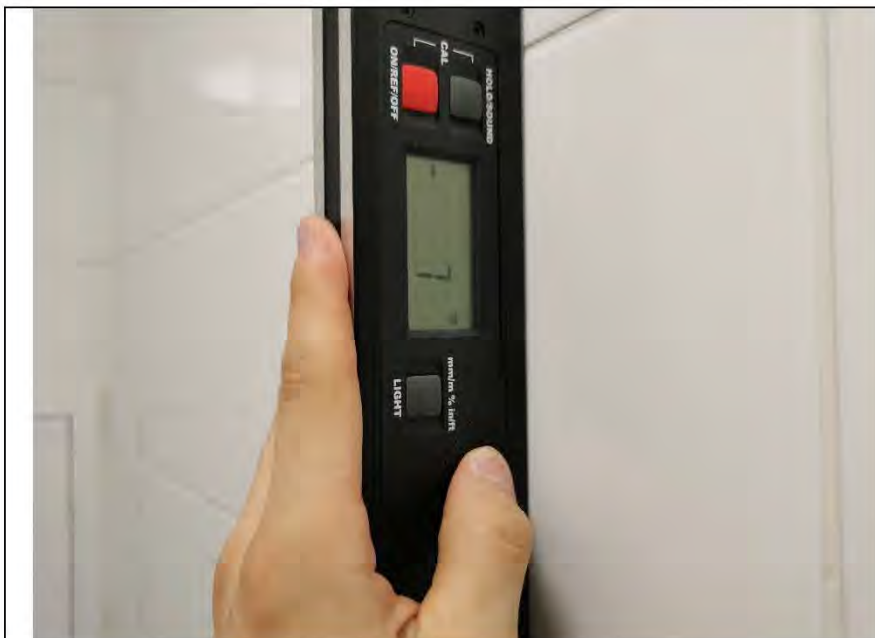
Фото №22. Измерение уровня стен в санузле.
