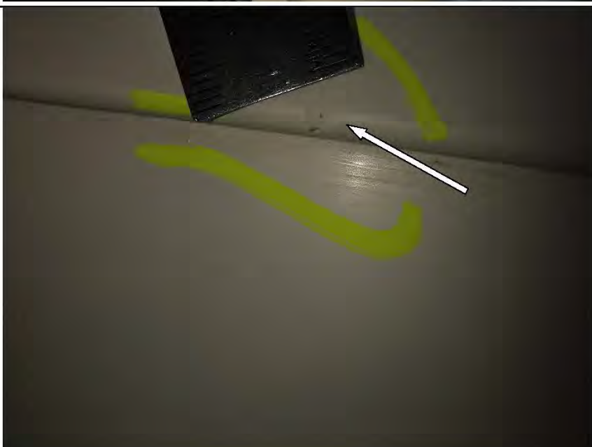
Фото №57. Сколы на профиле ПВХ оконного блока в спальне.
