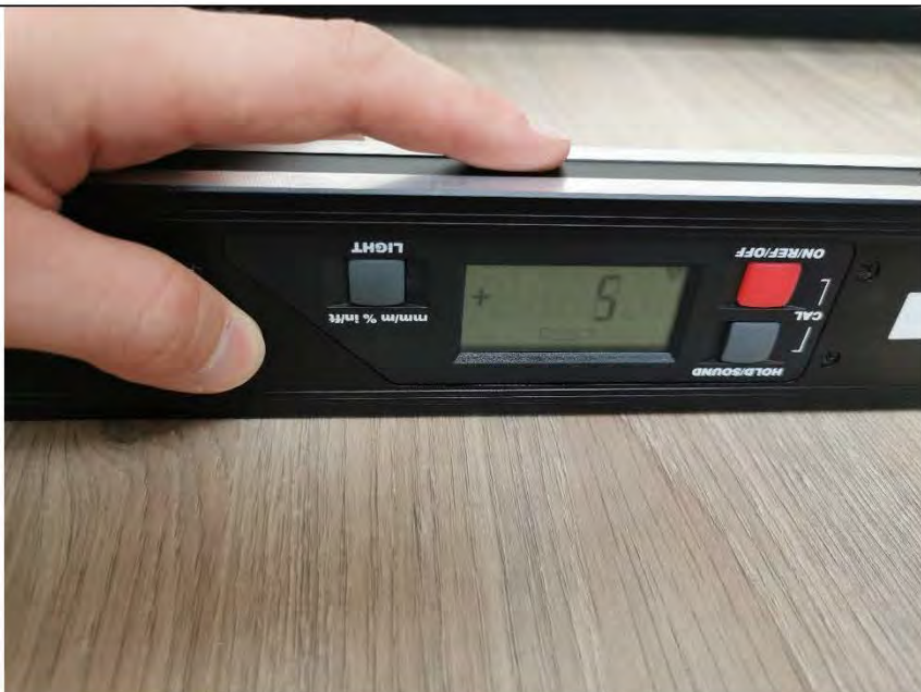
Фото №28. Измерение уровня напольного покрытия в гостиной.
