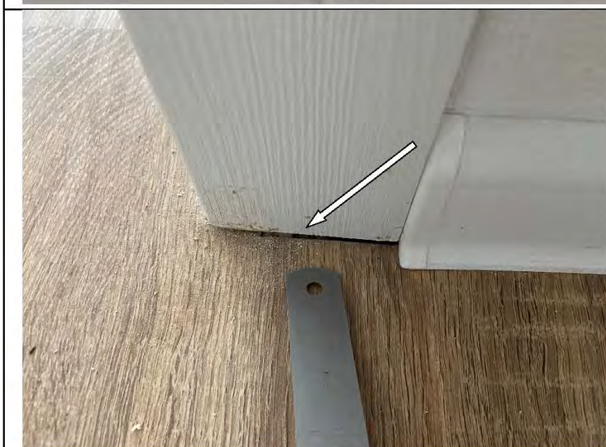
Фото №15. Коротко подрезан ламинат на стыке элементов в коридоре.
