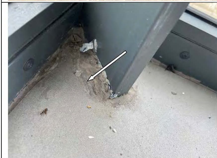
Фото №21. Загрязнения на напольном покрытии из керамической плитки на лоджии.
