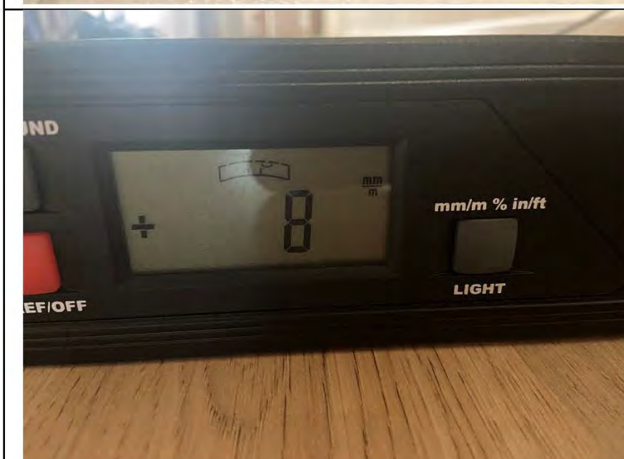
Фото №26. Отклонение поверхности напольного покрытия в коридоре.
