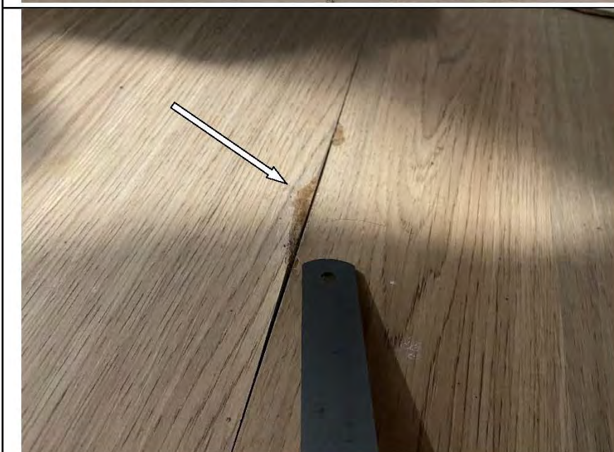
Фото №23. Скол и поднятые кромки досок ламината в коридоре.
