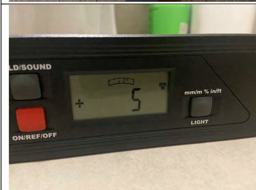
Фото №24. Отклонение поверхности напольного покрытия в санузле.
