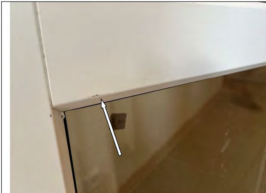
Фото №31. Царапина на профиле ПВХ дверного блока в кухне.
