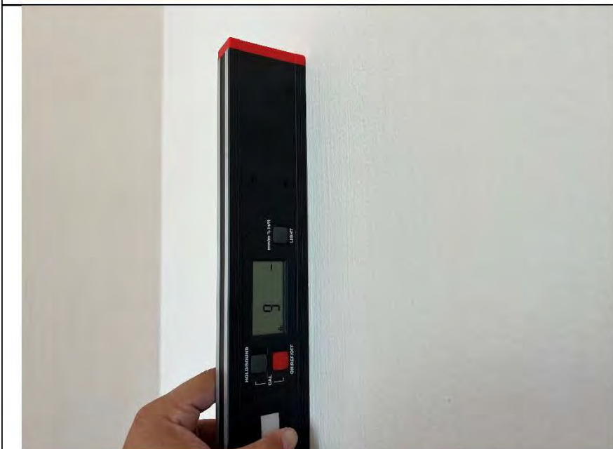
Фото №8. Измерение уровня стен в спальне.
