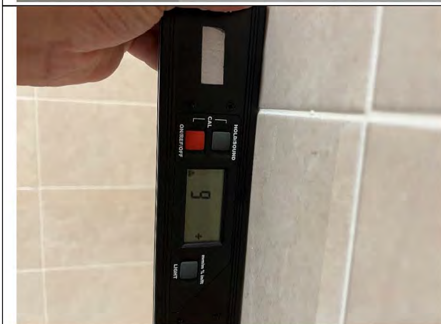
Фото №15. Измерение уровня стен в ванной комнате.
