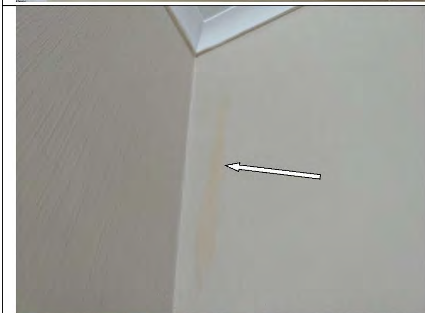
Фото №14. Загрязнение обойного полотна в спальне.
