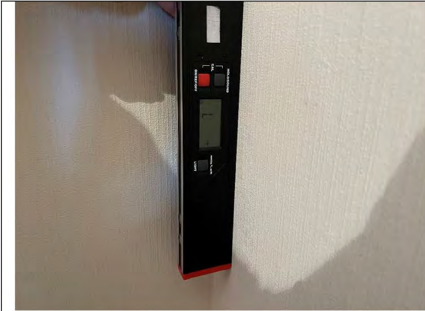
Фото №7. Измерение уровня стен в коридоре.
