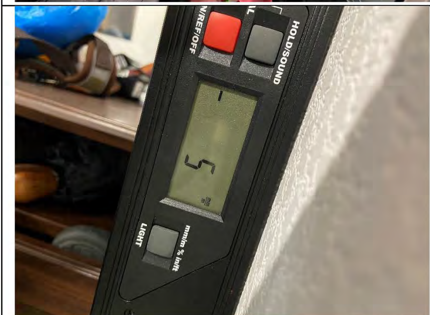
Фото №6. Отклонение поверхности стен от вертикали в коридоре.
