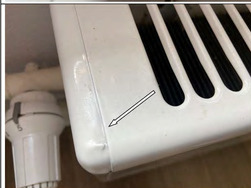
Фото №84. Загиб на металлическом кожухе отопительного прибора в детской.
