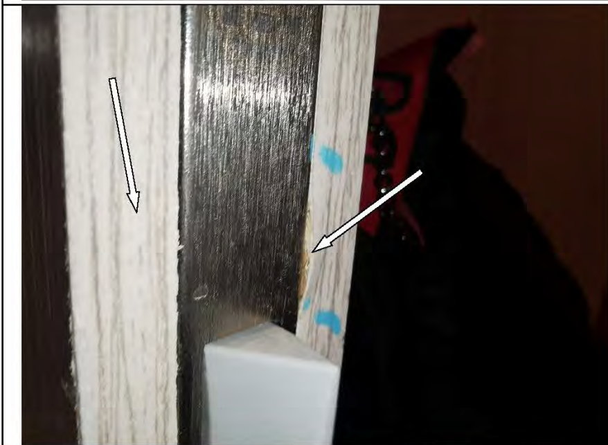
Фото №71. Повреждение ламинации полотна деревянного дверного блока в санузле.
