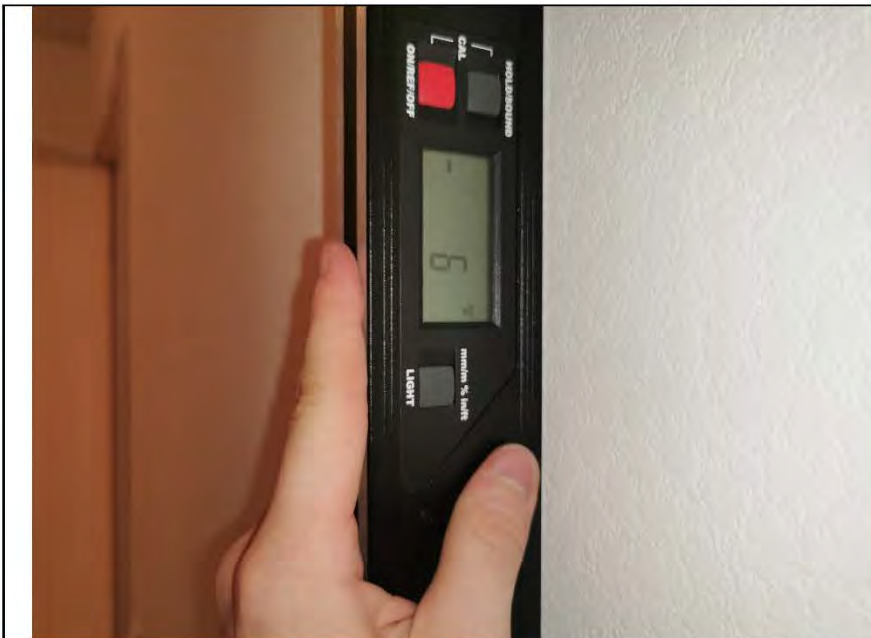
Фото №13. Измерение уровня стен в гостиной.
