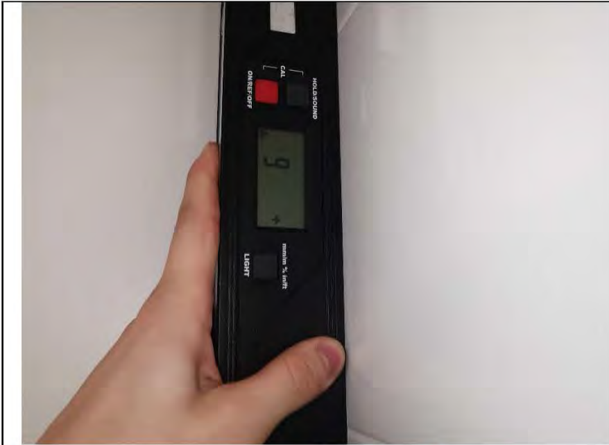
Фото №25. Измерение уровня стен в ванной комнате.
