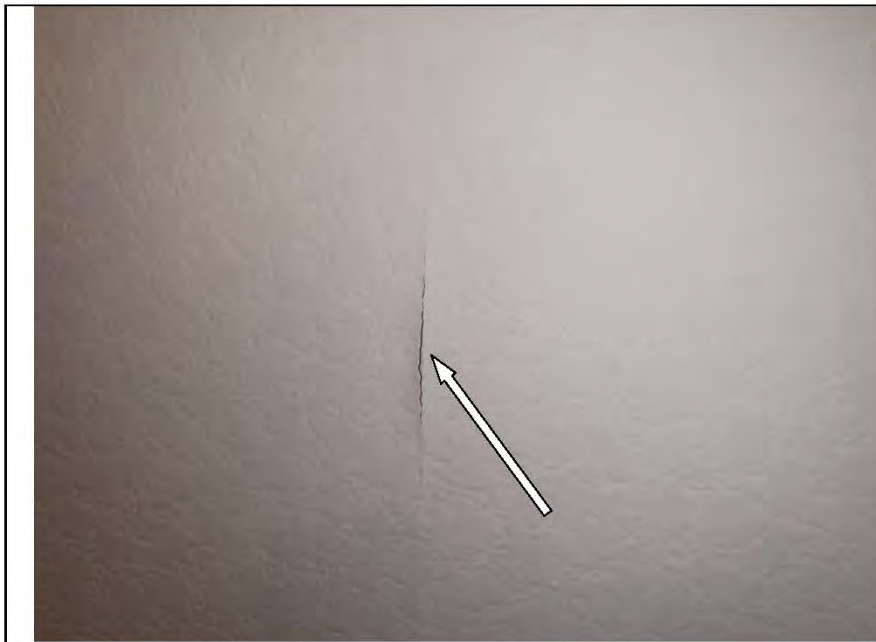
Фото №22. Читаемые обойные стыки в холле.
