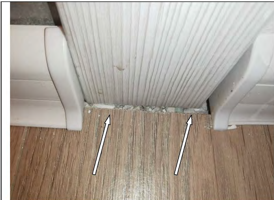
Фото №40. Коротко подрезан ламинат на стыке элементов в холле.
