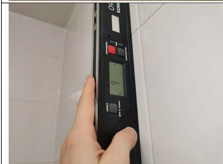
Фото №24. Измерение уровня стен в санузле.
