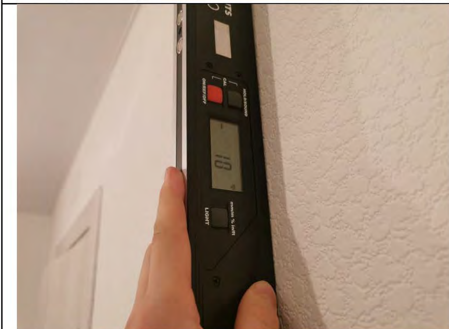
Фото №11. Измерение уровня стен в прихожей.
