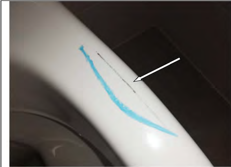
Фото №91. Загрязнение унитаза в ванной комнате.
