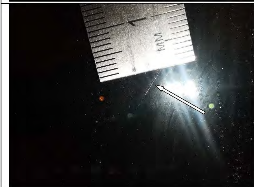
Фото №66. Царапины на стеклопакете оконного блока ПВХ в спальне.
