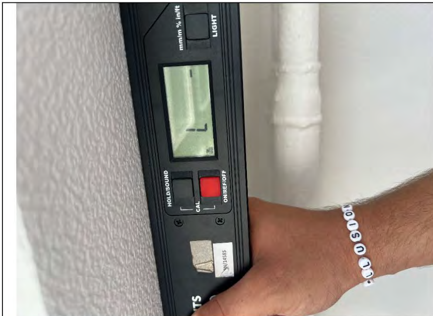
Фото №7. Измерение уровня стен в кухне.
