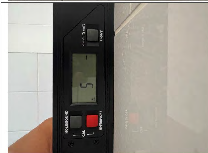
Фото №12. Измерение уровня стен в ванной комнате.
