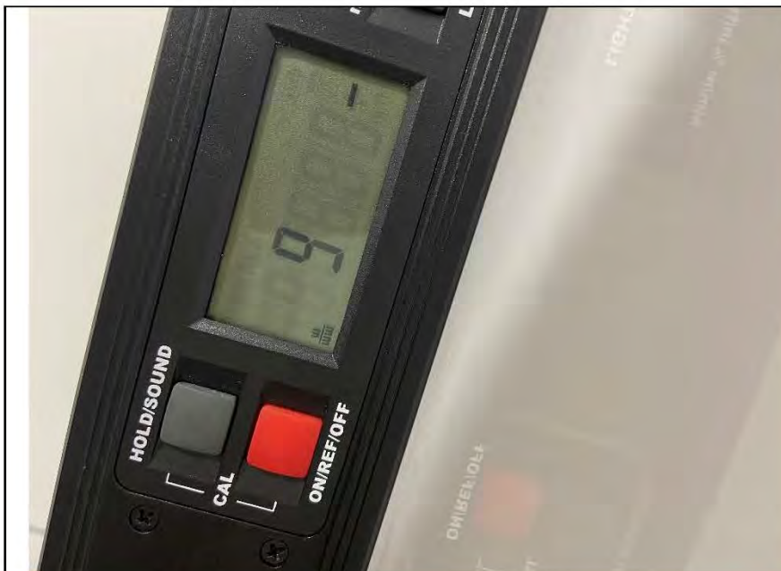
Фото №13. Отклонение поверхности стен от вертикали в ванной комнате.
