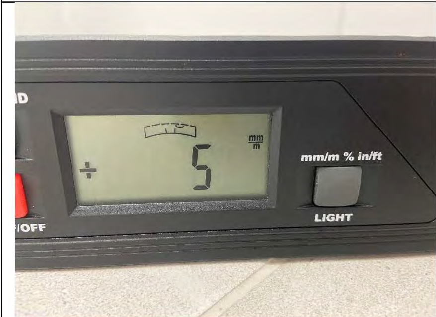
Фото №21. Отклонения поверхности напольного покрытия из керамической плитки в санузле.
