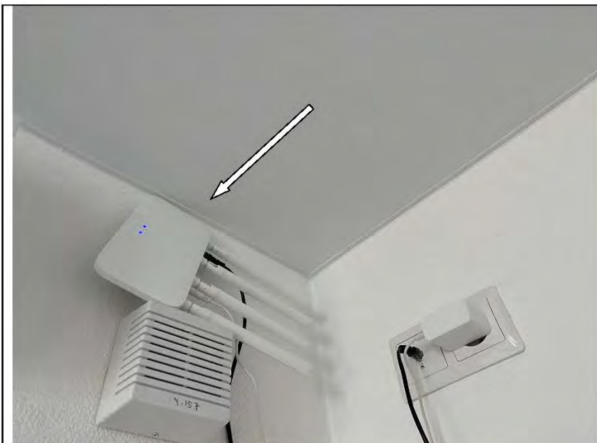
Фото №85. Дефект на поверхности натяжного потолка в коридоре.
