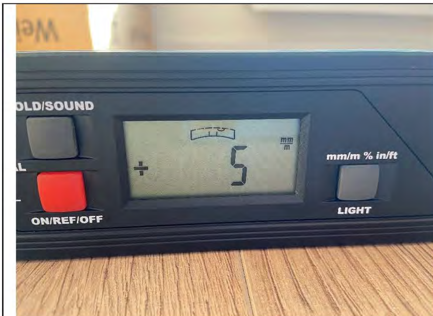
Фото №25. Отклонения поверхности напольного покрытия из ламината в кабинете.
