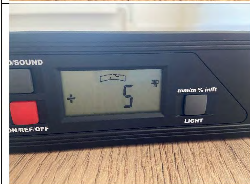
Фото №24. Отклонения поверхности напольного покрытия из ламината в спальне.
