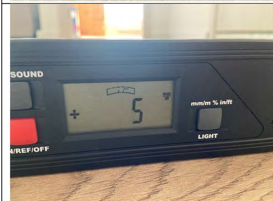
Фото №23. Отклонения поверхности напольного покрытия из ламината в коридоре.
