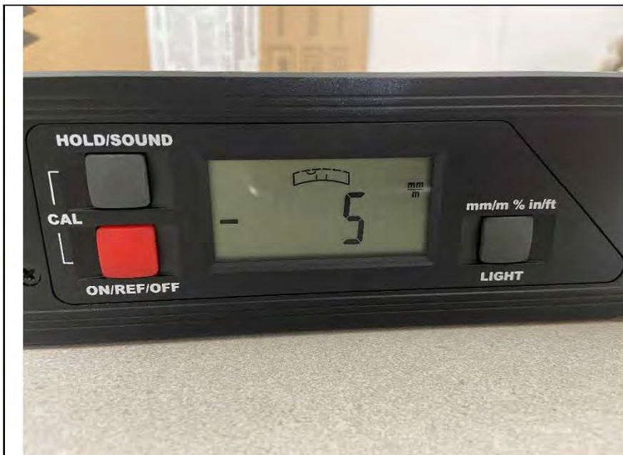
Фото №22. Отклонения поверхности напольного покрытия из керамической плитки в ванной комнате.
