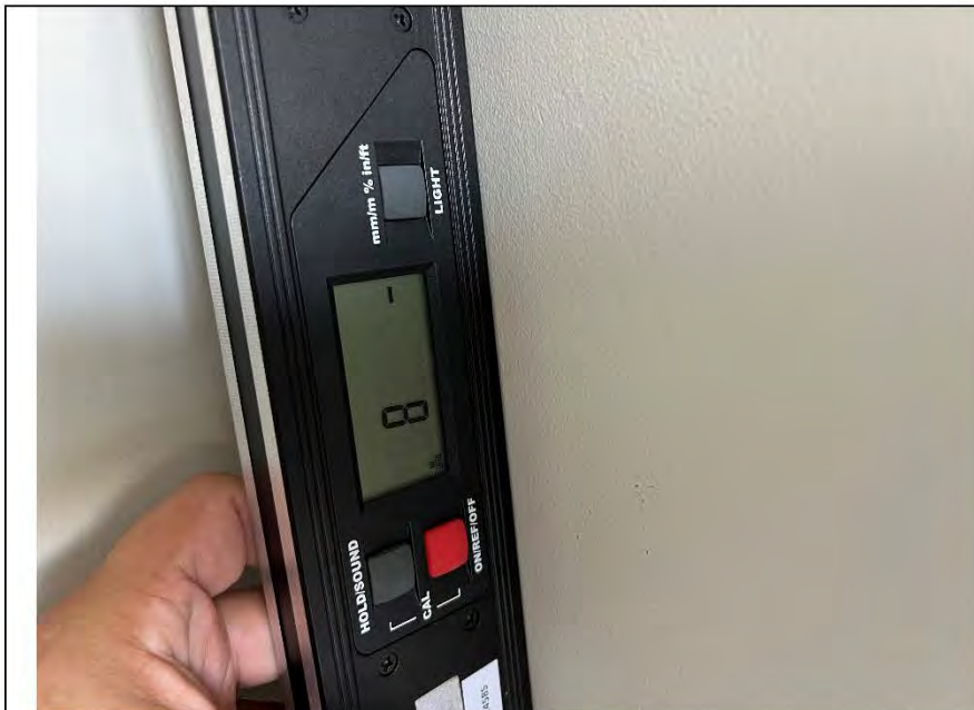
Фото №13. Измерение уровня стен в кухне.
