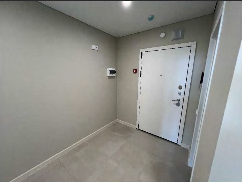
Фото №6. Общий вид коридора.
