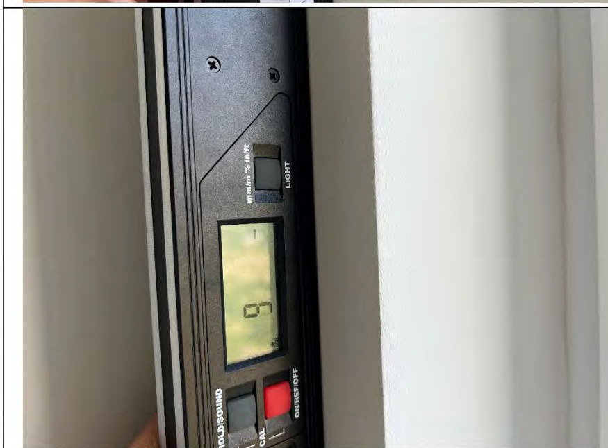
Фото №14. Измерение уровня стен в спальне.
