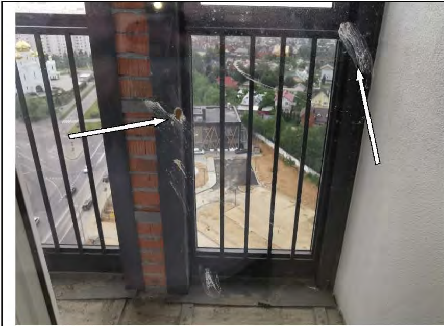
Фото №28. Загрязнения на стеклопакете балконного блока ПВХ.
