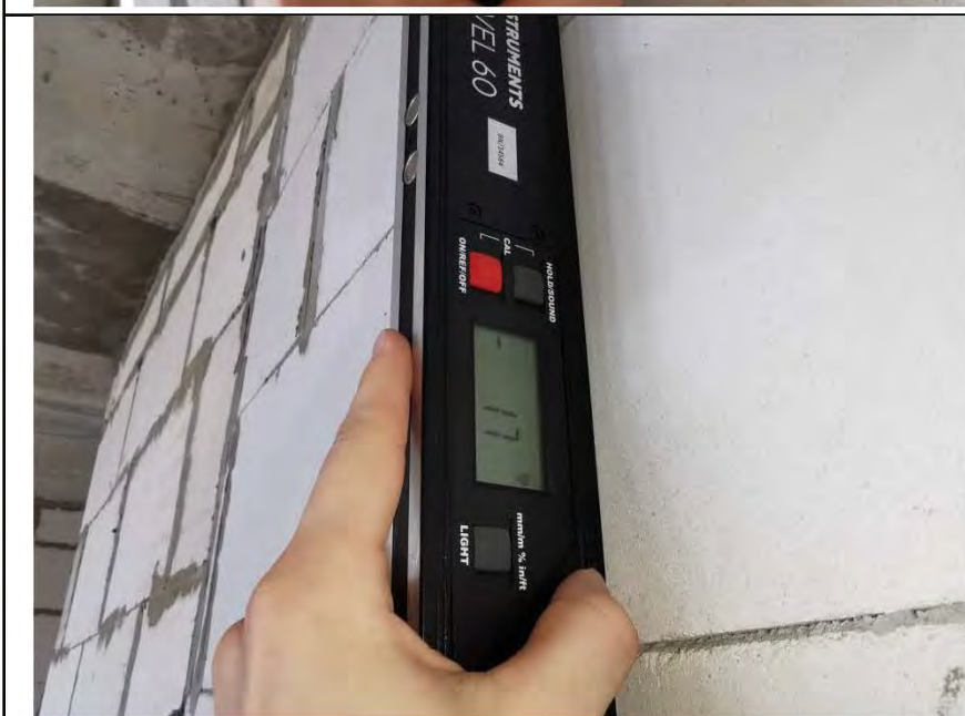
Фото №6. Измерение уровня стен в помещении.
