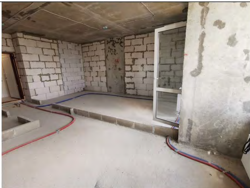
Фото №2. Общий вид помещения.
