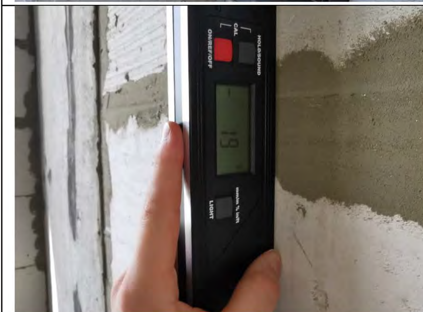
Фото №5. Измерение уровня стен в помещении.
