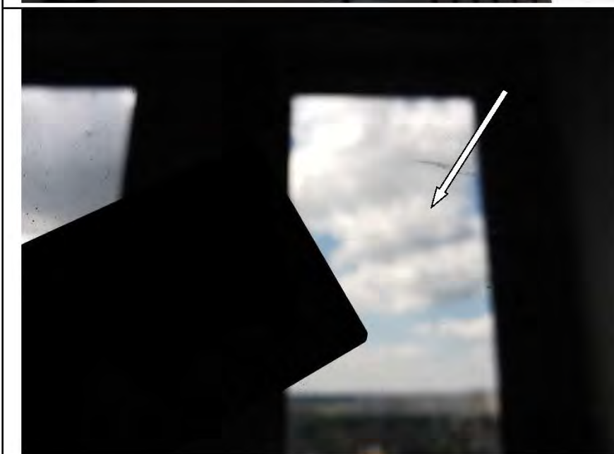
Фото №30. Царапины на стеклопакете балконного блока ПВХ.
