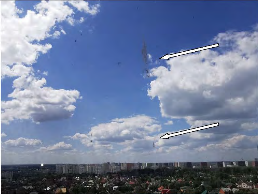
Фото №37. Загрязнение стеклопакета металлического оконного блока на лоджии.
