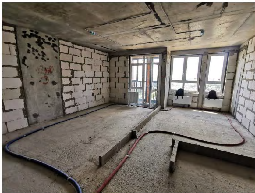
Фото №1. Общий вид помещения.
