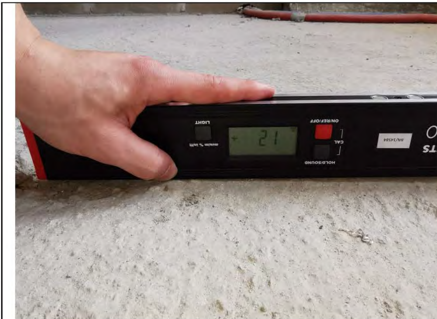
Фото №10. Измерение уровня пола в помещении.
