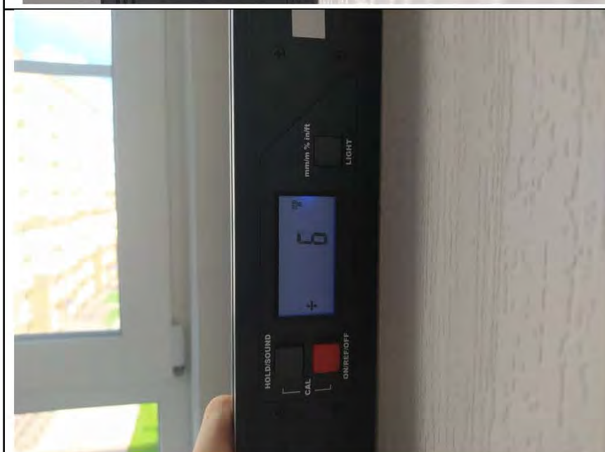
Фото №11. Измерение уровня стен на лоджии.
