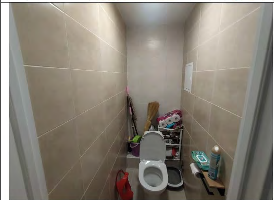
Фото №6. Общий вид санузла.
