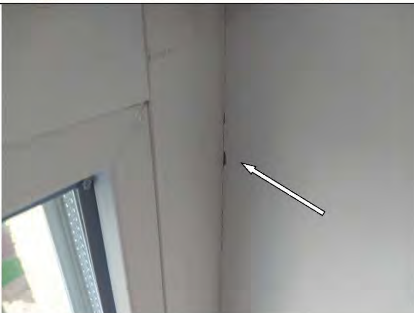
Фото №20. Оконный блок на лоджии имеет щели, через которые происходит инфильтрация воздуха внутрь помещения.
