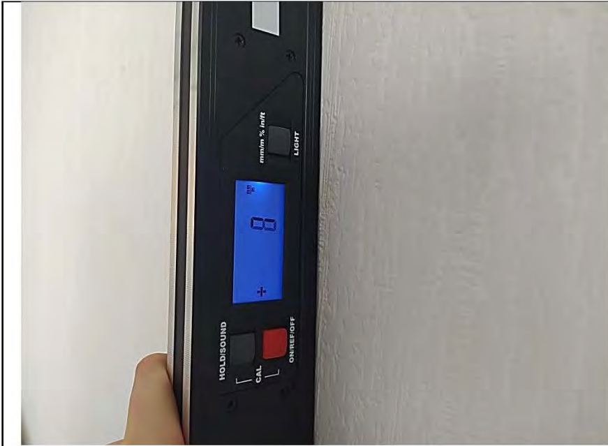
Фото №7. Измерение уровня стен в спальне.
