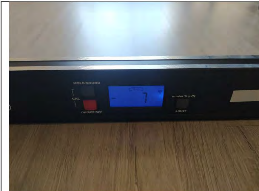
Фото №16. Измерение уровня напольного покрытия в кухне.
