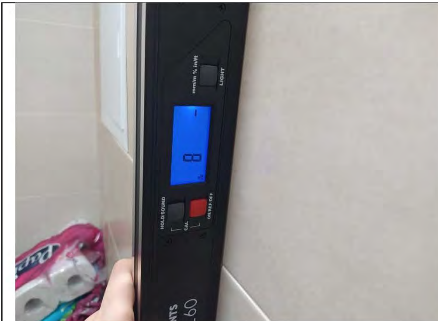
Фото №13. Измерение уровня стен в санузле.
