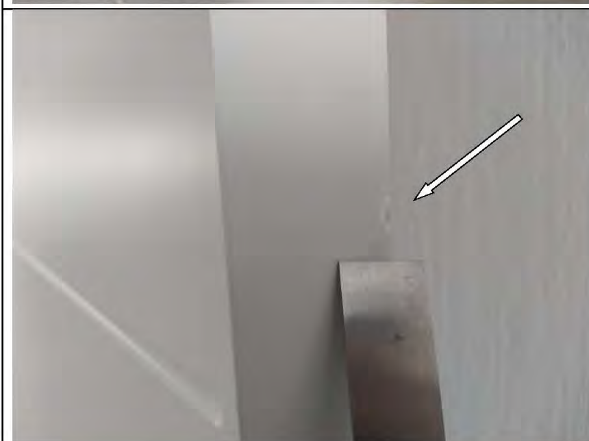
Фото №47. Дефекты (скол) на лицевой поверхности полотна деревянного дверного блока в гостиной
