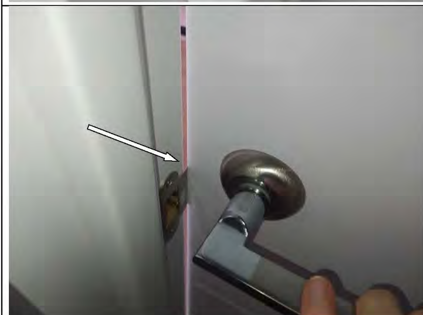
Фото №36. Конструкция дверного блока не обеспечивает безотказное открывание и закрывание двери в кухне.
