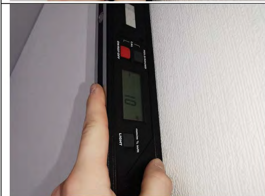
Фото №9. Измерение уровня стен в спальне.
