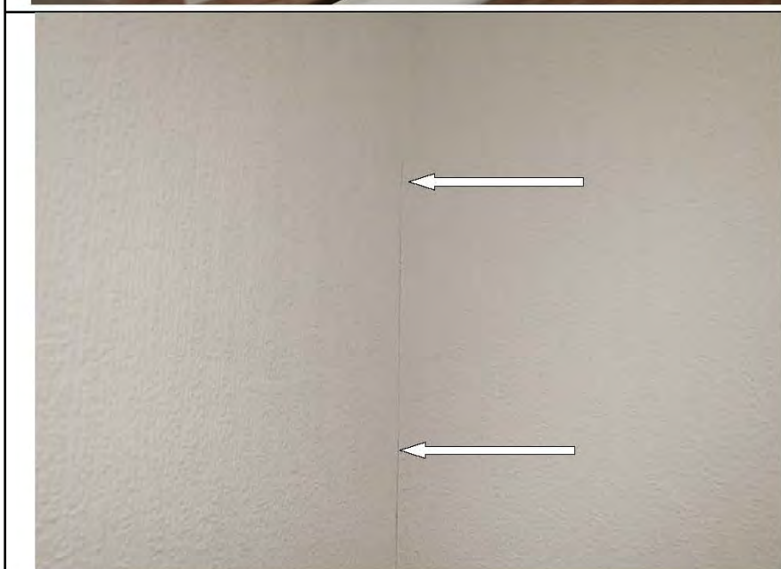
Фото №12. Читаемые обоевые стыки в коридоре.
