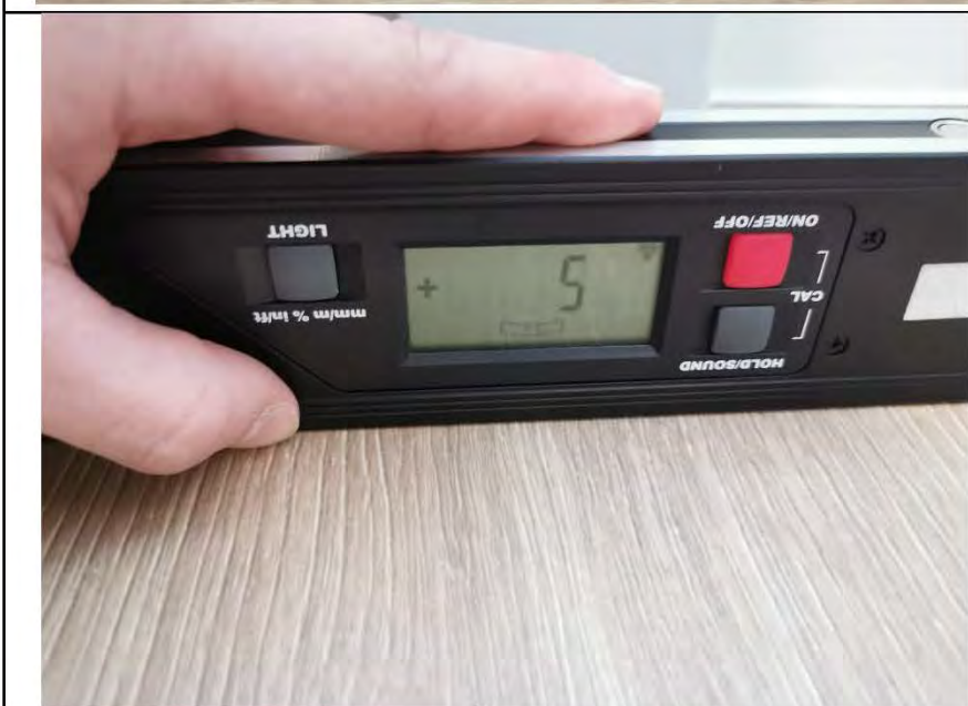
Фото №23. Измерение уровня пола в кухне.
