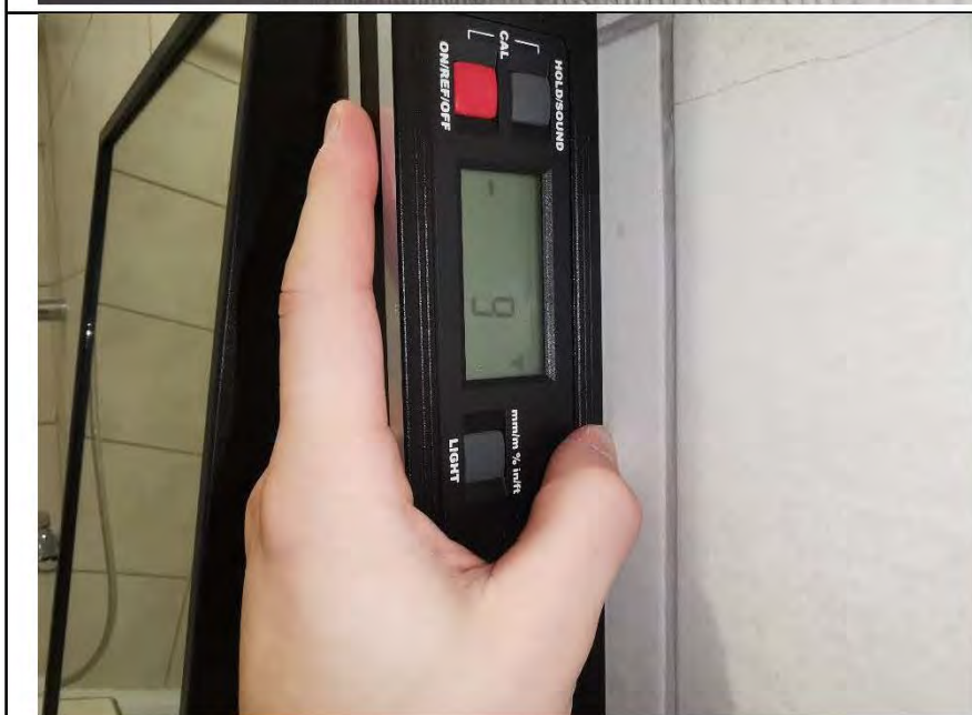
Фото №18. Измерение уровня стен в ванной комнате.
