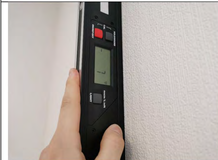
Фото №8. Измерение уровня стен в кухне.
