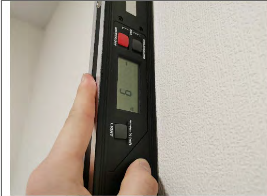
Фото №7. Измерение уровня стен в коридоре.
