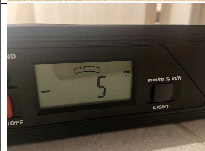
Фото №27. Отклонение поверхности напольного покрытия из керамической плитки в ванной комнате.
