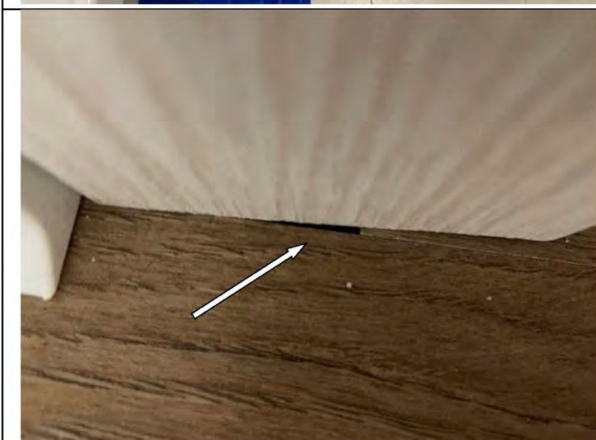
Фото №21. Коротко подрезан ламинат на стыке элементов в коридоре.
