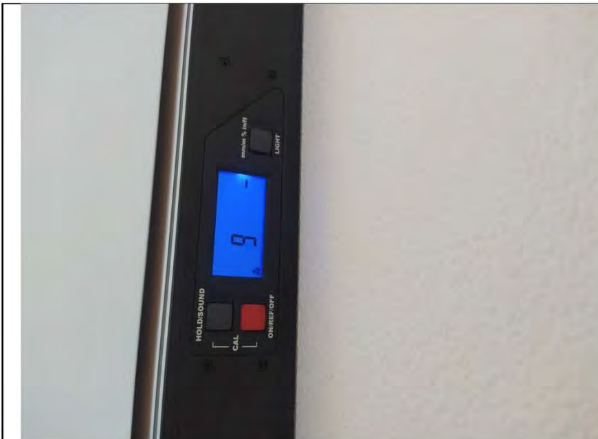
Фото №4. Измерения уровня стен в кухне-гостиной.
