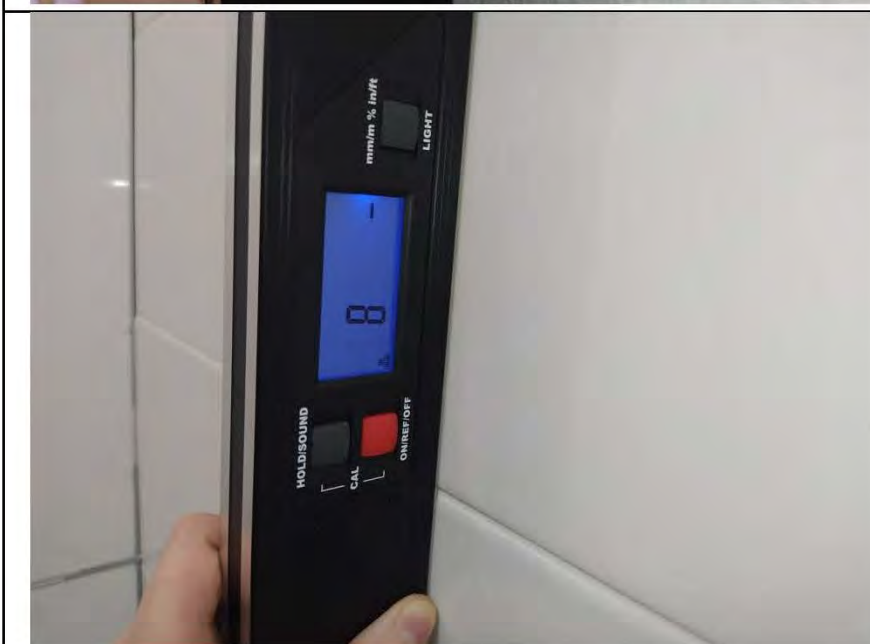
Фото №6. Измерения уровня стен в ванной комнате.
