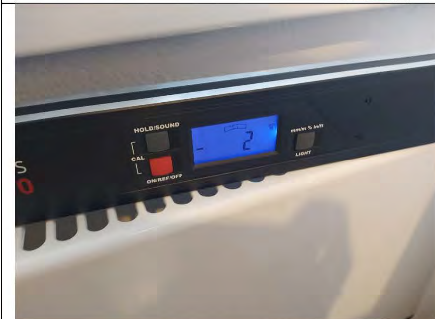
Фото №20. Отопительный прибор смонтирован неровно в кухне гостиной.
