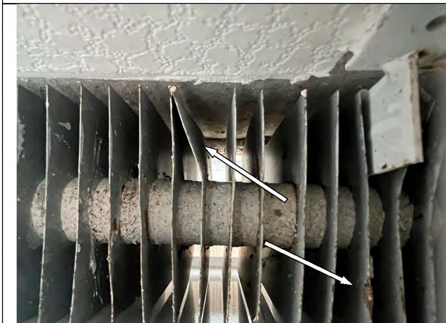
Фото №116. Замытие сот радиатора и следы образования коррозии в радиаторе в спальне.
