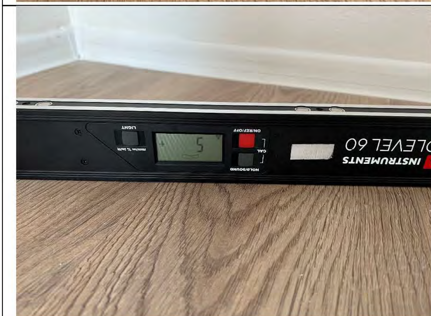
Фото №38. Измерение уровня напольного покрытия в спальне.
