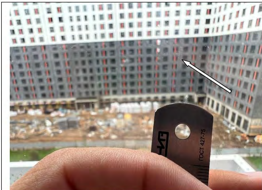
Фото №58. Царапина на стеклопакете оконного блока ПВХ в кухне.
