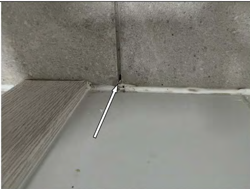
Фото №44. Не полное заполнение шовного пространства напольной керамической плитки в ванной комнате.
