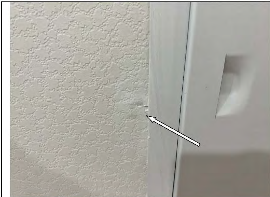
Фото №28. Замятие обоевого полотна в коридоре.
