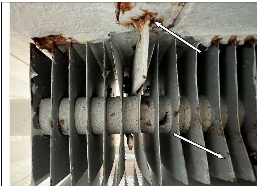
Фото №115. Замытие сот радиатора и следы образования коррозии в радиаторе в детской.
