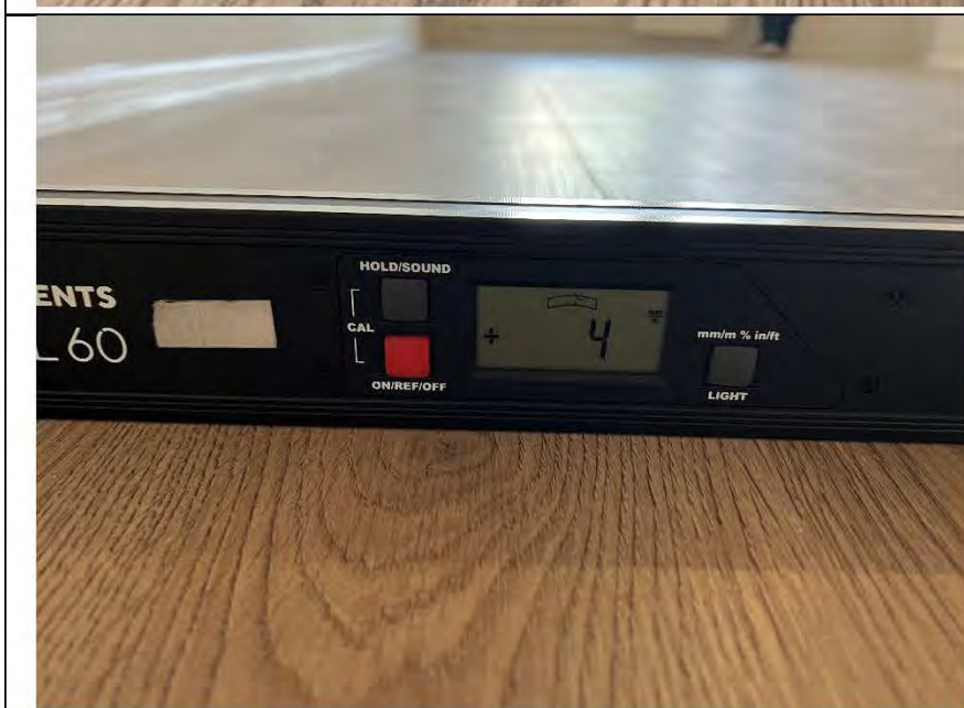
Фото №39. Измерение уровня напольного покрытия в гостиной.
