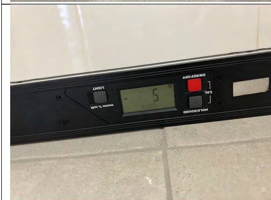
Фото №42. Измерение уровня напольного покрытия в санузле.
