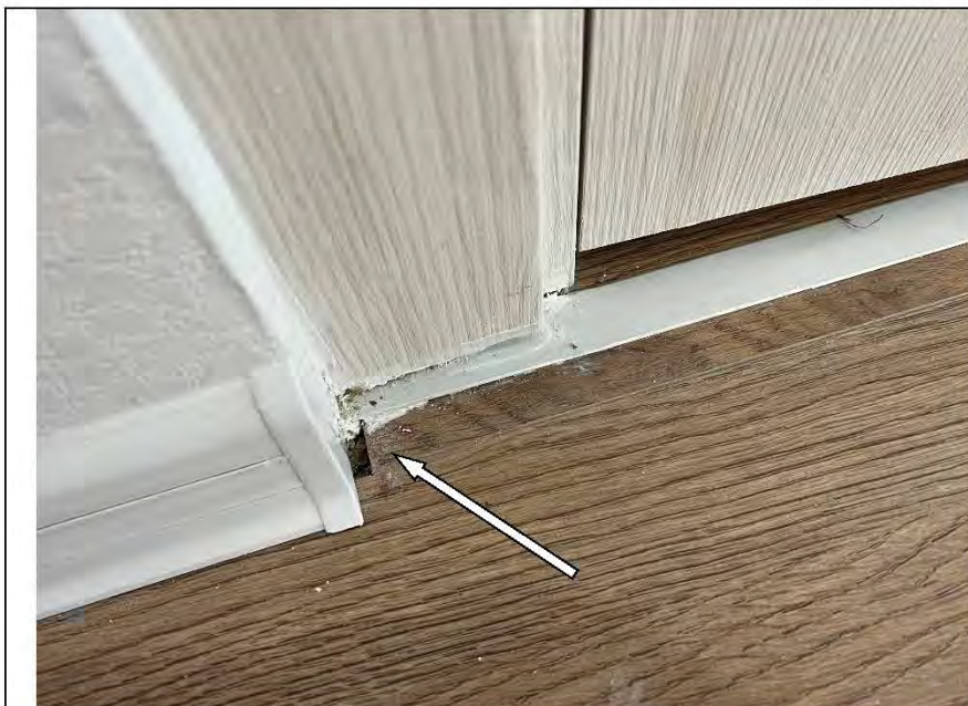
Фото №46. Коротко подрезан ламинат в коридоре.
