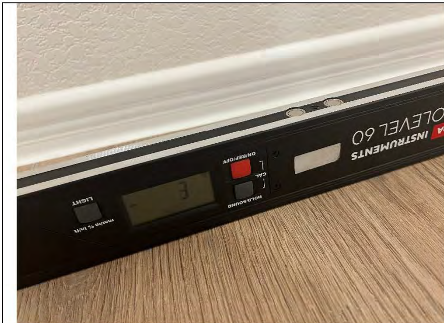
Фото №37. Измерение уровня напольного покрытия в гардеробной.
