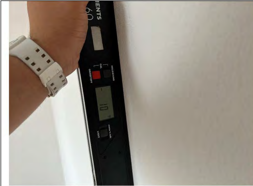
Фото №13. Измерение уровня стен в спальне.
