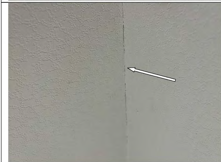
Фото №18. Читаемые обойные стыки в гардеробной.
