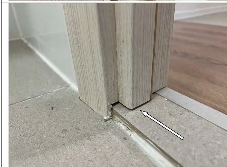
Фото №99. Короткая подрезка короба и наличников дверного блока в санузле.
