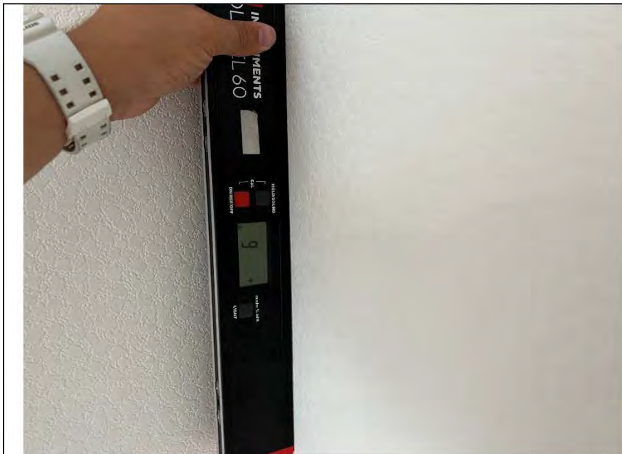
Фото №10. Измерение уровня стен в кухне.
