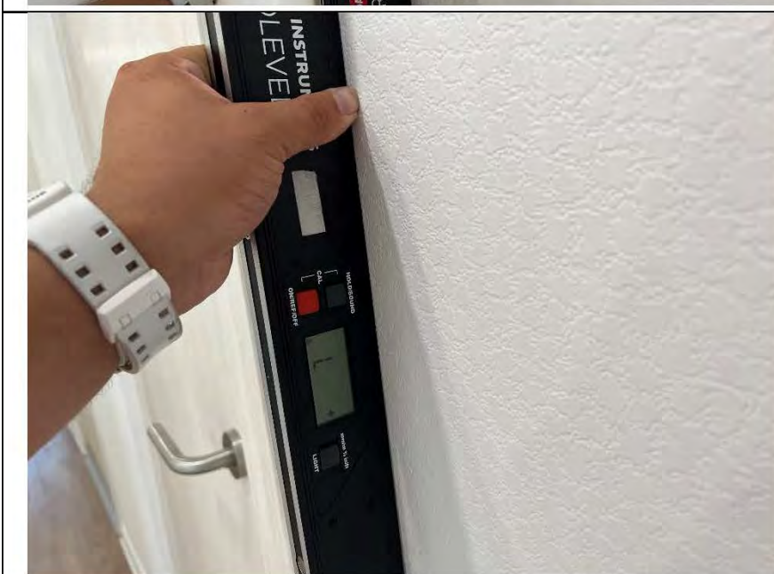
Фото №15. Измерение уровня стен в коридоре.
