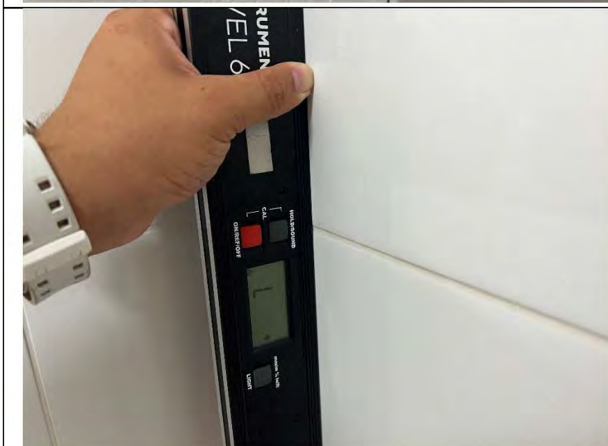
Фото №29. Измерение уровня стен в санузле.
