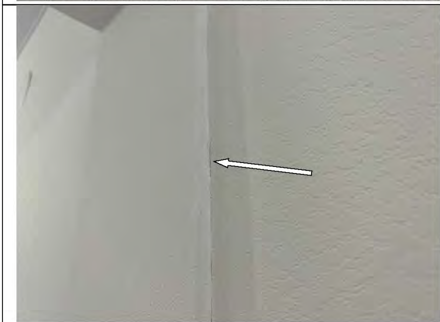
Фото №21. Читаемые обойные стыки в коридоре.
