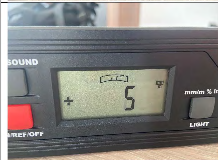
Фото №30. Отклонения поверхности напольного покрытия из ламината в кухне.
