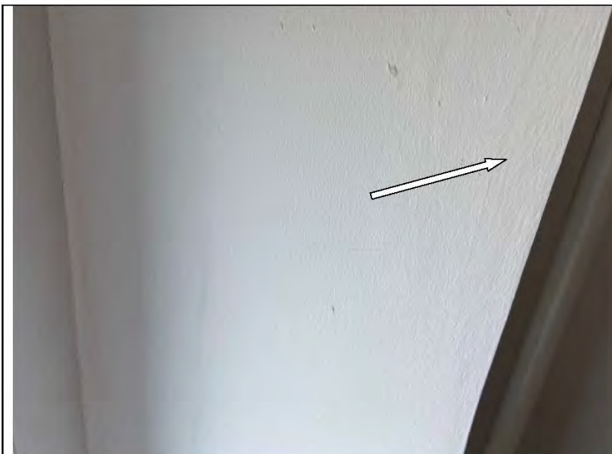
Фото №76. Неровности, выбоины, раковины на окрашенных откосах оконного блока ПВХ в кухне.
