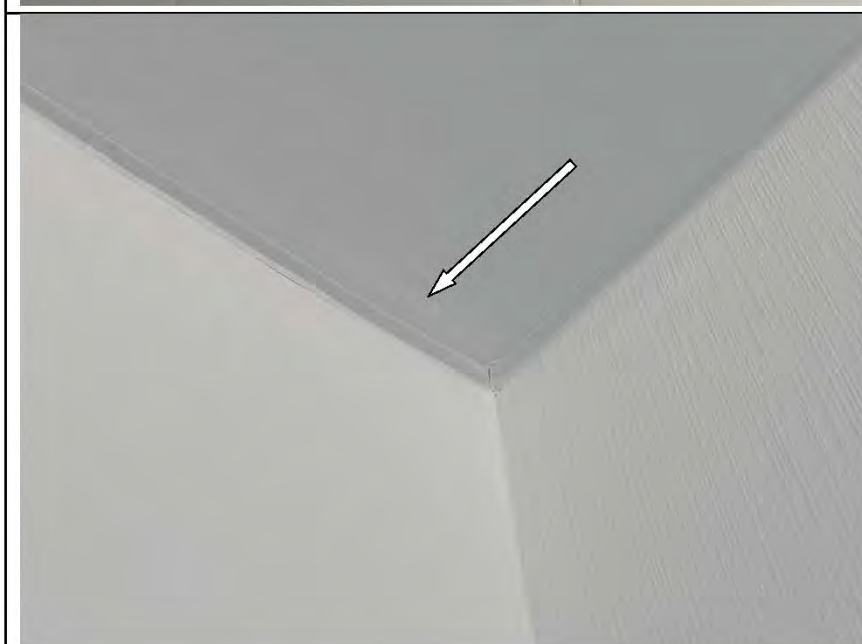
Фото №110. Дефект на поверхности натяжного потолка в детской.
