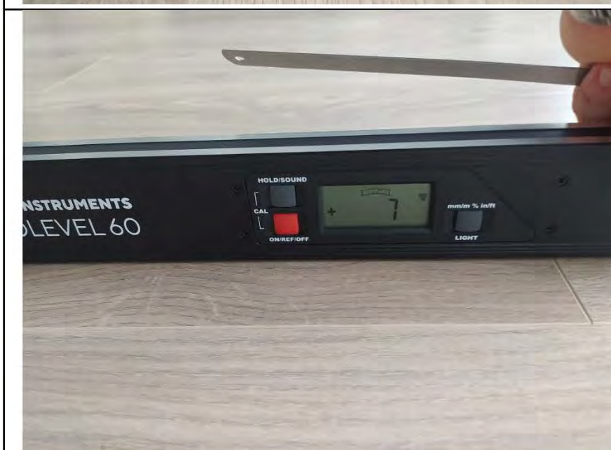
Фото №21. Измерение уровня напольного покрытия в кухне.
