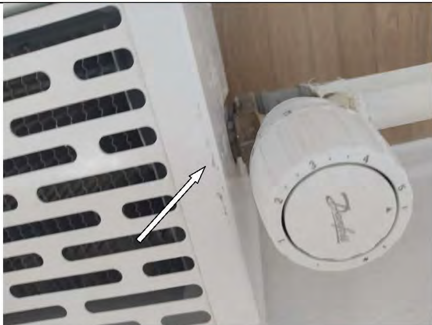
Фото №65. Отопительный прибор имеет дефект покраски защитного кожуха в спальне (скол)
