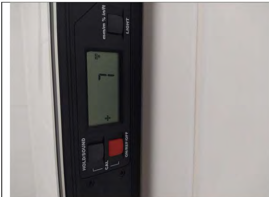
Фото №19. Измерение уровня стен в санузле (керамическая плитка).
