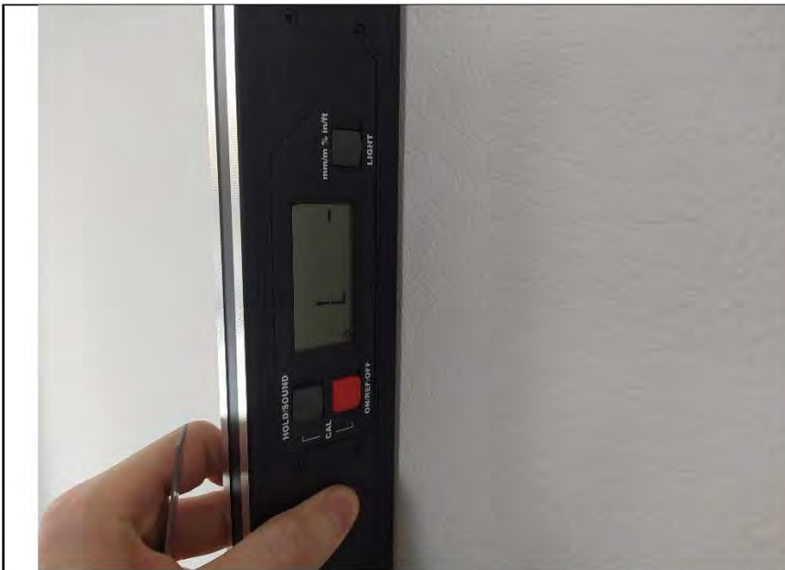
Фото №16. Измерение уровня стен в гостиной.
