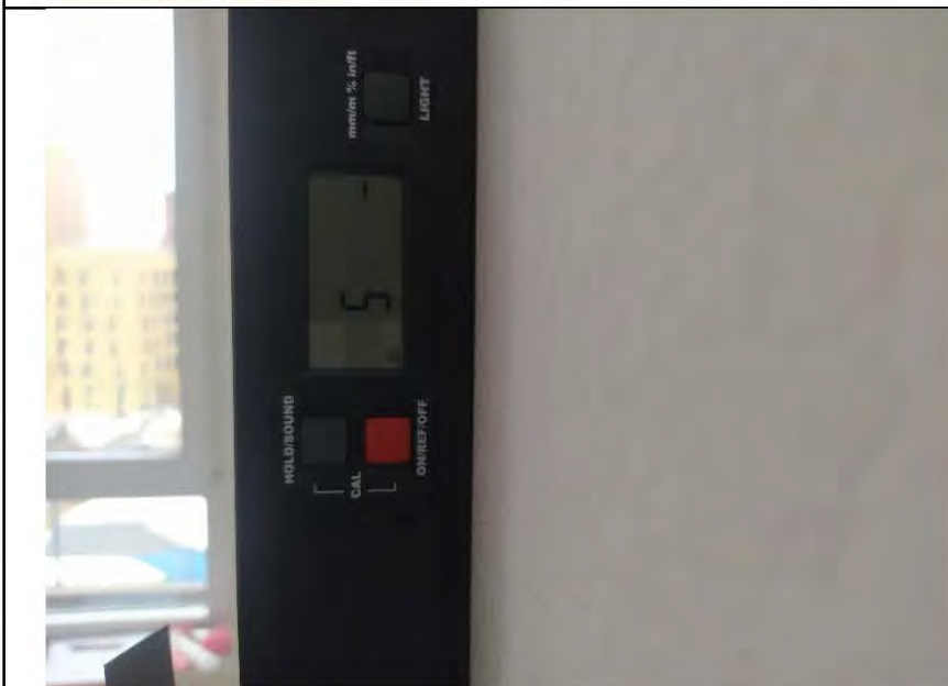
Фото №14. Измерение уровня стен в кухне.
