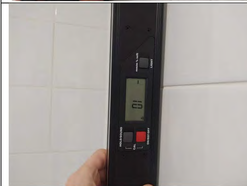
Фото №18. Измерение уровня стен в ванной комнате (керамическая плитка).
