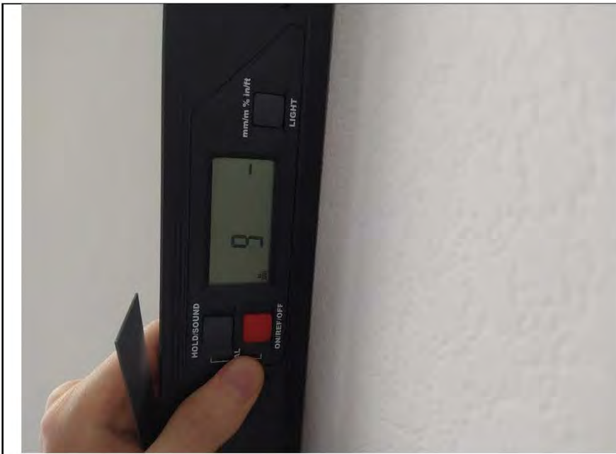
Фото №13. Измерение уровня стен в спальне.
