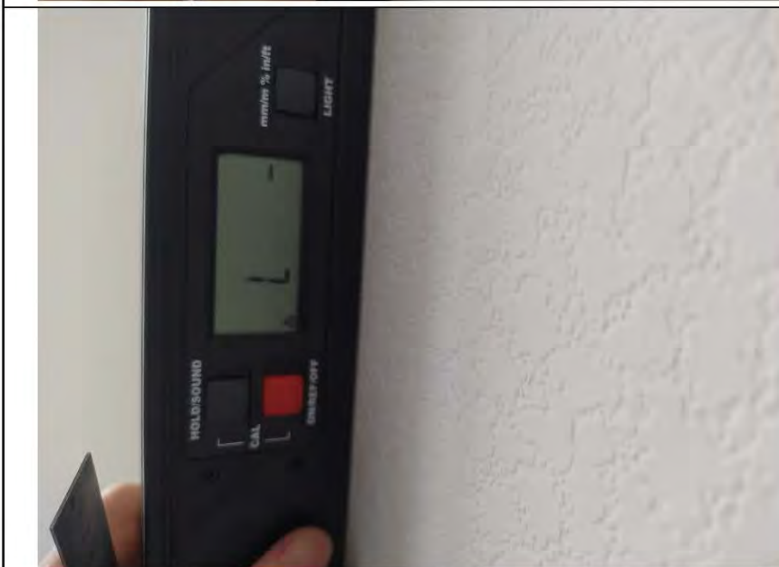
Фото №17. Измерение уровня стен в кабинете.
