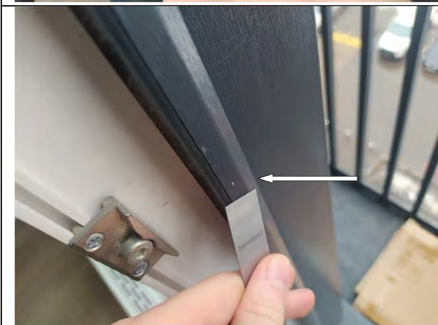
Фото №36. Профиль ПВХ дверного блока в кухне имеет дефекты (скол).
