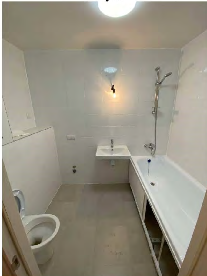
Фото 4. Санузел. Общий вид помещения.
