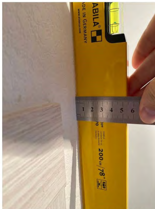
Фото 16, 17. Коридор (6,5 кв.м.) 1.4 Отклонения участков стен от горизонтали 9 мм, 4,5 мм
