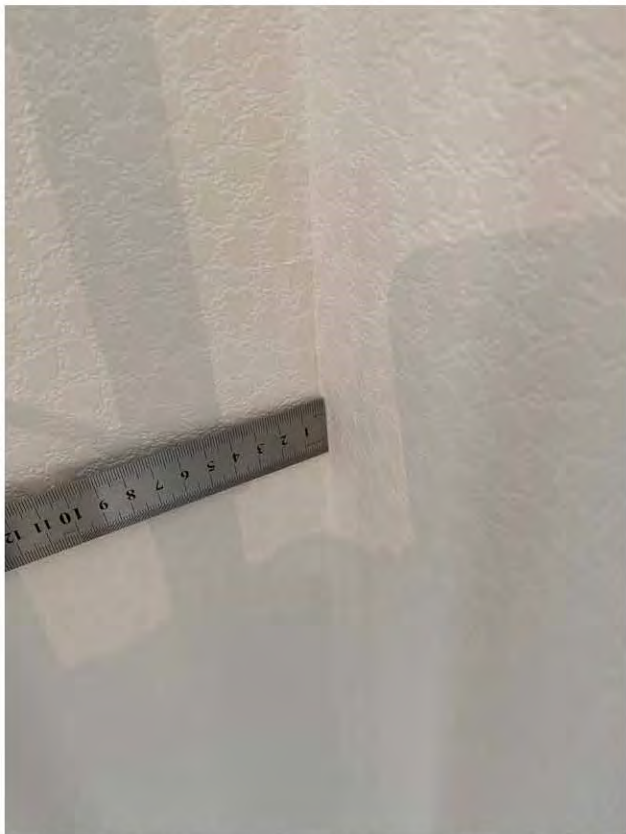
Фото 48, 49. Комната 1 (10,6 кв.м.) 4.1 Локальные участки имеют: замятины, пятна, загрязнения, отслоения обоев
