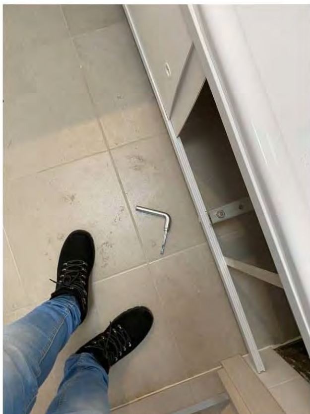
Фото 27, 28. Санузел (3,5 кв.м.) 2.4 Изменение характера звука при простукивании плитки (пустоты)
