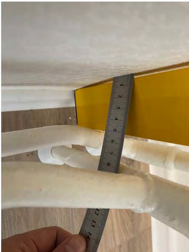
Фото 56, 57. Комната 1 (10,6 кв.м.) 4.6 Отклонения участков стен от горизонтали 6,5 мм, 5 мм
