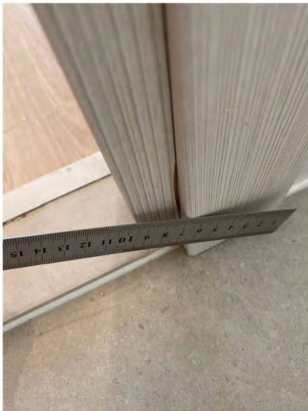
Фото 22, 23 Санузел (3,5 кв.м.) 2.1 На дверном блоке имеются: сколы и отслоения ламинации
