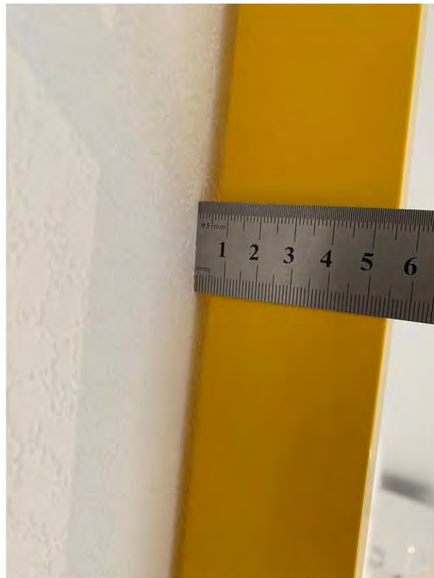
Фото 56, 57. Комната 1 (10,6 кв.м.) 4.6 Отклонения участков стен от горизонтали 6,5 мм, 5 мм
