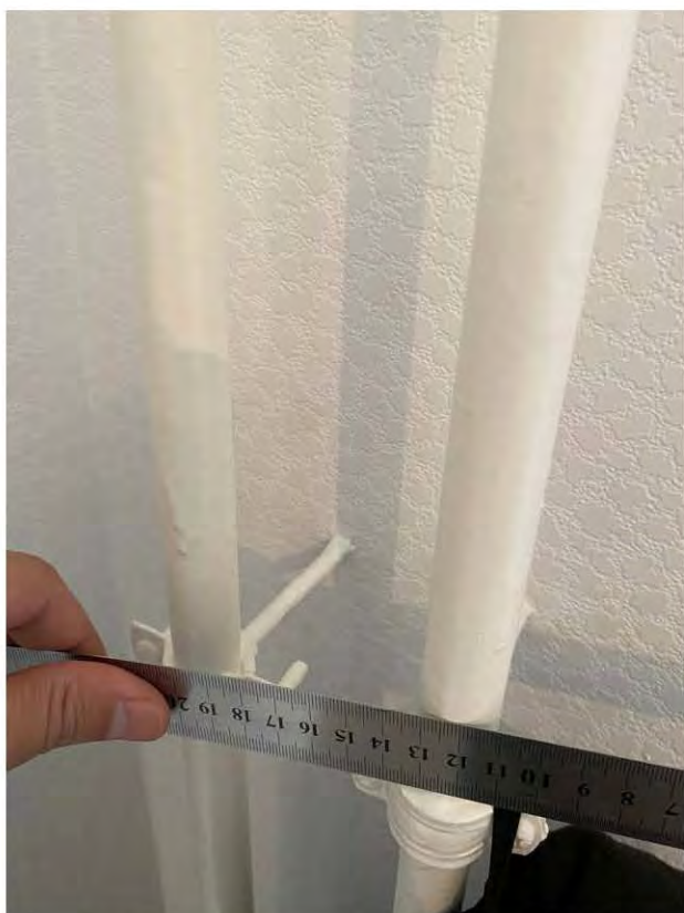
Фото 34, 35. Кухня (16,3 кв.м.) 3.2 Некачественная окраска труб отопления: разводы
