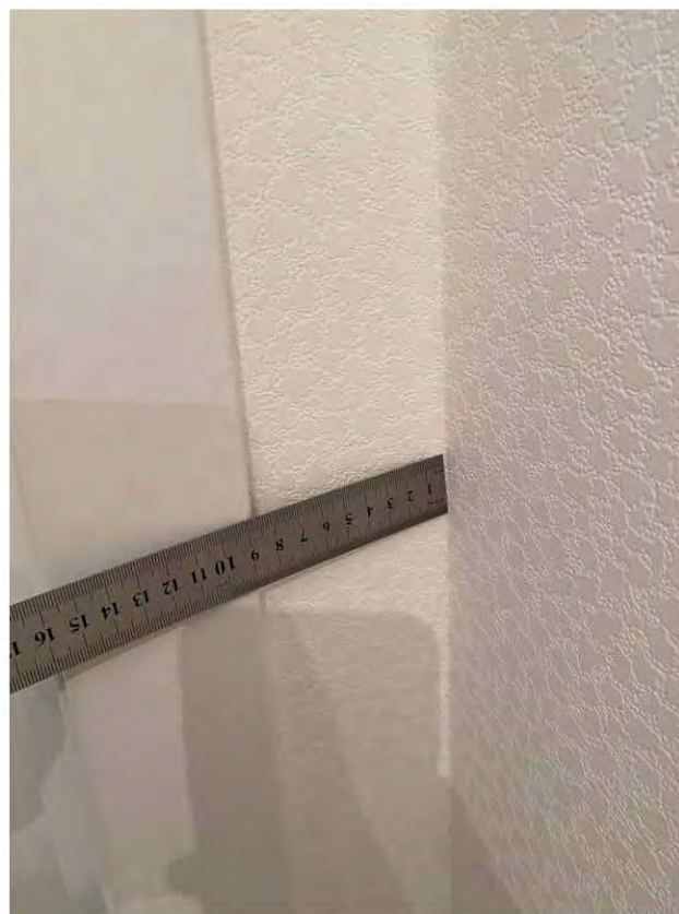
Фото 12. Коридор (6,5 кв.м.) 1.2 Неровности на полотне натяжного потолка (видна проводка)
