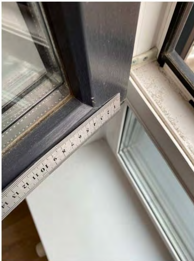
Фото 36, 37. Кухня (16,3 кв.м.) 3.3 Некачественная окраска оконных откосов: брызги, разводы
