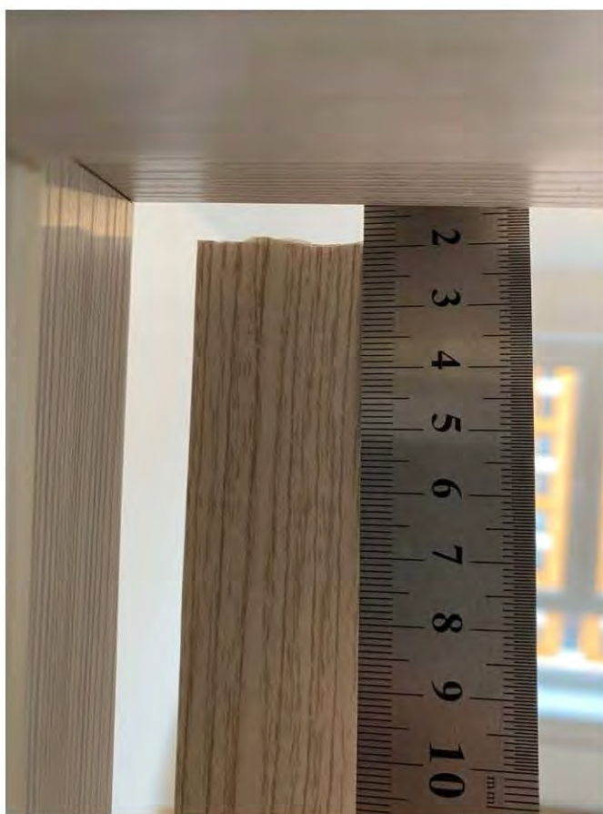
Фото 61. Комната 1 (10,6 кв.м.) 4.10 На дверном блоке имеется скол
