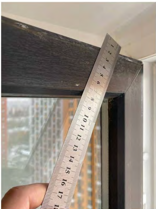
Фото 36, 37. Кухня (16,3 кв.м.) 3.3 Некачественная окраска оконных откосов: брызги, разводы
