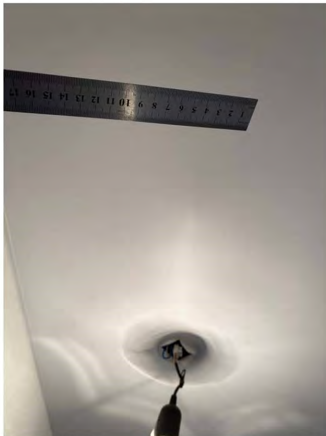
Фото 12. Коридор (6,5 кв.м.) 1.2 Неровности на полотне натяжного потолка (видна проводка)
