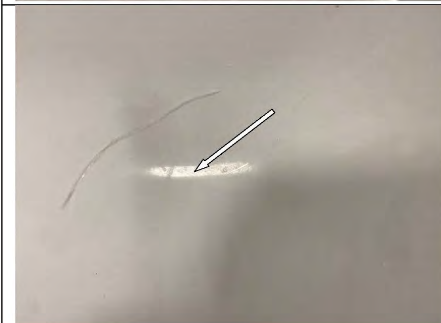
Фото №45. Царапины на унитазе в ванной комнате.
