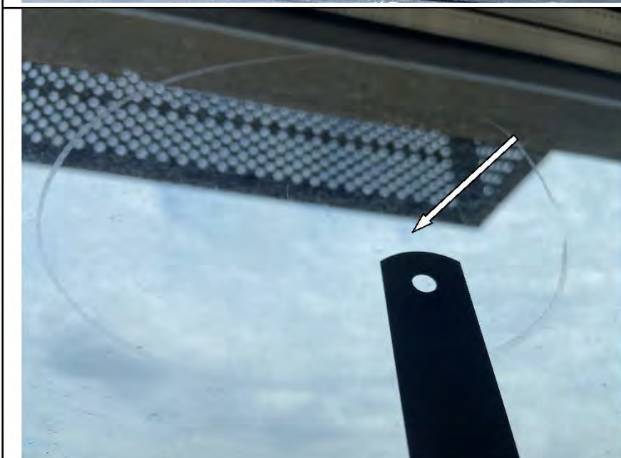
Фото №26. Царапина на стеклопакете оконного блока ПВХ в общей комнате.
