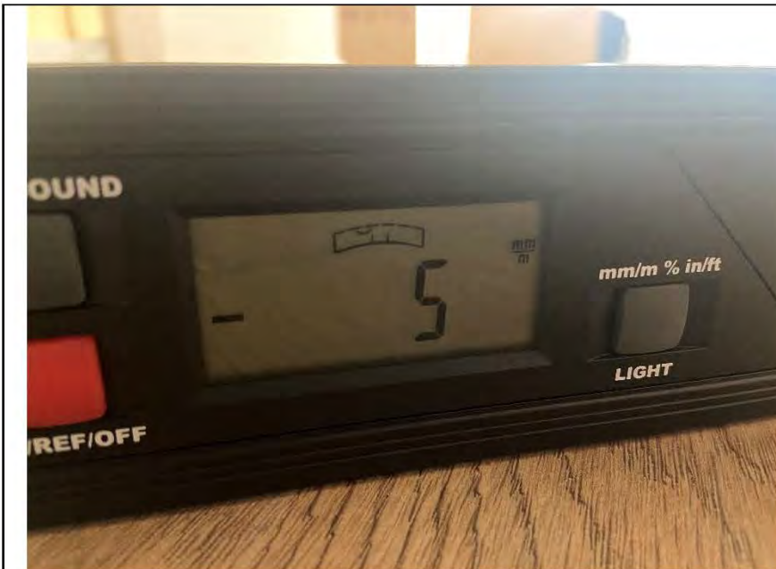
Фото №13. Отклонения поверхности напольного покрытия из ламината в коридоре.
