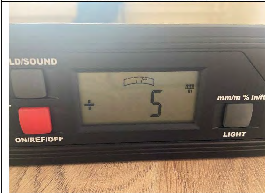
Фото №14. Отклонения поверхности напольного покрытия из ламината в общей комнате.
