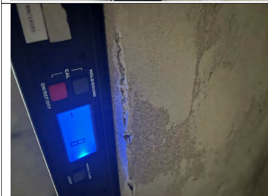
Фото №11. Измерение уровня стен в ванной комнате.
