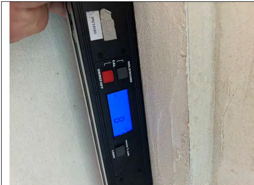
Фото №10. Измерение уровня стен в кухне.
