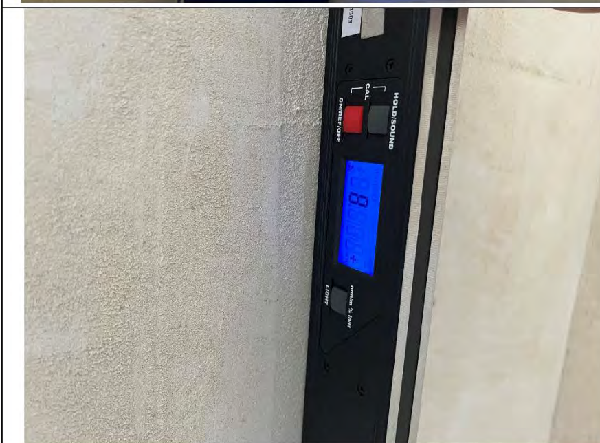
Фото №9. Измерение уровня стен в спальне.
