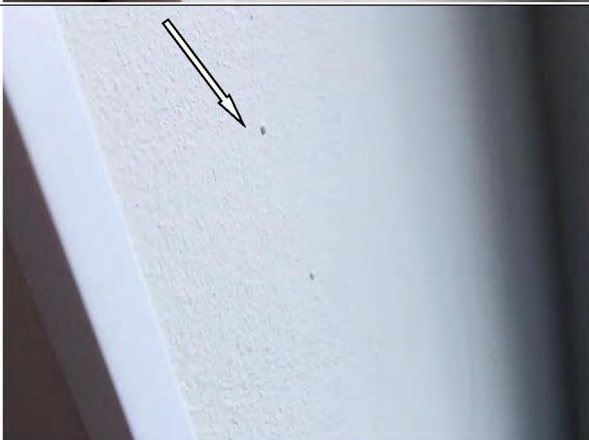
Фото №30. Неровности, сколы на окрашенных откосах оконного блока ПВХ в кухне в квартире.
