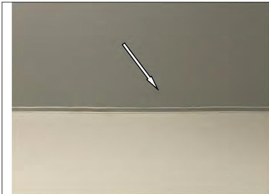
Фото №25. Загрязнения на полотне натяжного потолка в коридоре в квартире.
