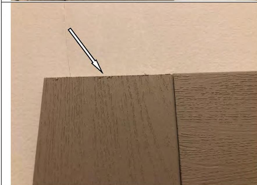
Фото №12. Скол на наличнике деревянного дверного блока в ванной комнате в квартире.
