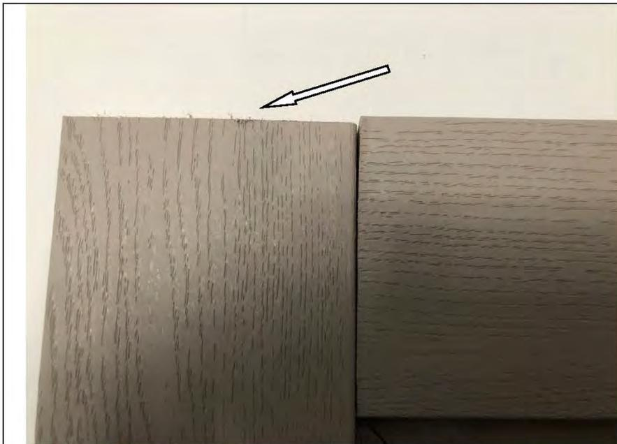
Фото №10. Скол на наличнике деревянного дверного блока в спальне в квартире.
