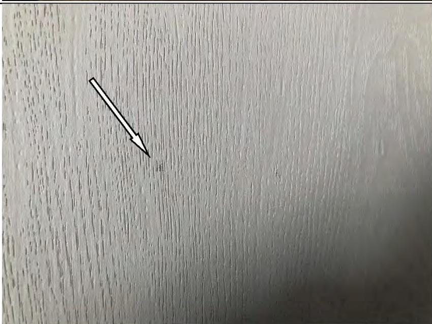
Фото №20. Загрязнения на полотне деревянного дверного блока в спальне в квартире.
