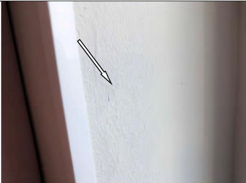
Фото №29. Неровности, сколы на окрашенных откосах оконного блока ПВХ в спальне в квартире.
