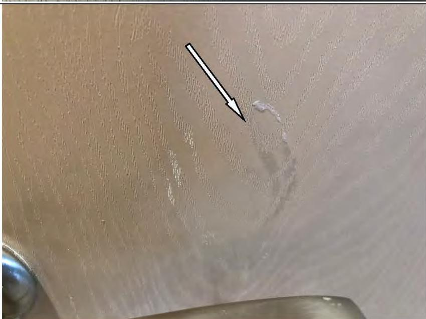
Фото №21. Загрязнения на полотне комбинированного дверного блока в коридоре в квартире.
