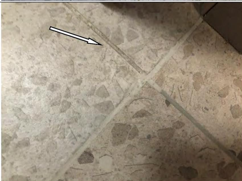
Фото №39. Неровный шов напольной керамической плитки в кладовке в квартире.
