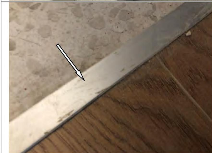
Фото №18. Царапины на напольном металлическом порожке в спальне в квартире.
