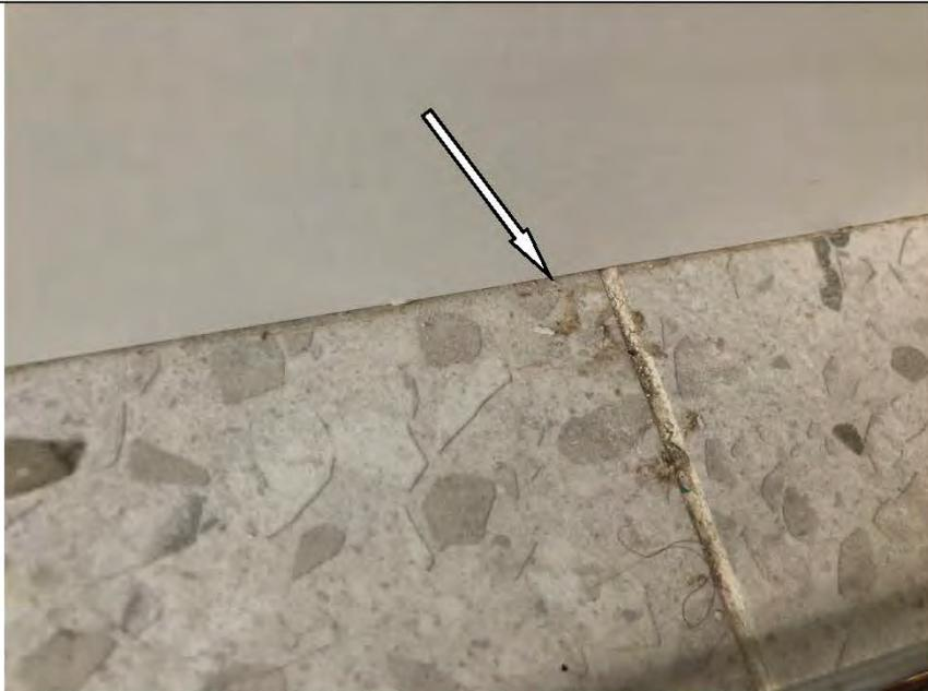
Фото №37. Загрязнения на напольной керамической плитке в кухне в квартире.
