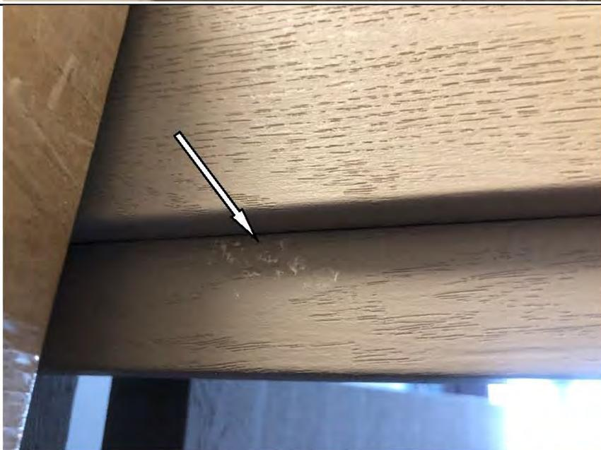
Фото №14. Загрязнения на коробке деревянного дверного блока в спальне в квартире.
