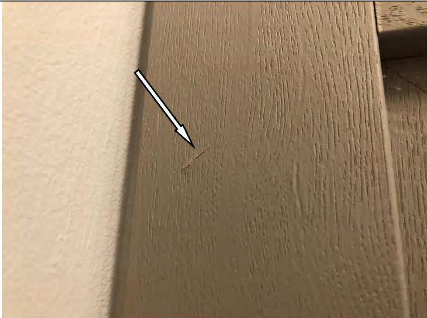
Фото №13. Царапина на наличнике деревянного дверного блока в кухне в квартире.
