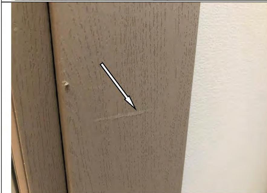
Фото №11. Скол на наличнике деревянного дверного блока в кладовке в квартире.
