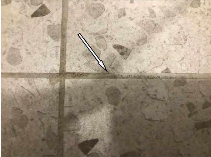
Фото №40. Неровный шов напольной керамической плитки в ванной комнате в квартире.
