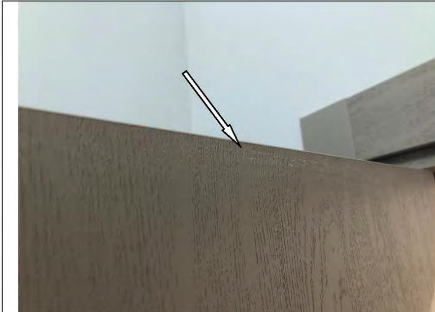
Фото №22. Загрязнения на полотне деревянного дверного блока в кладовке в квартире.
