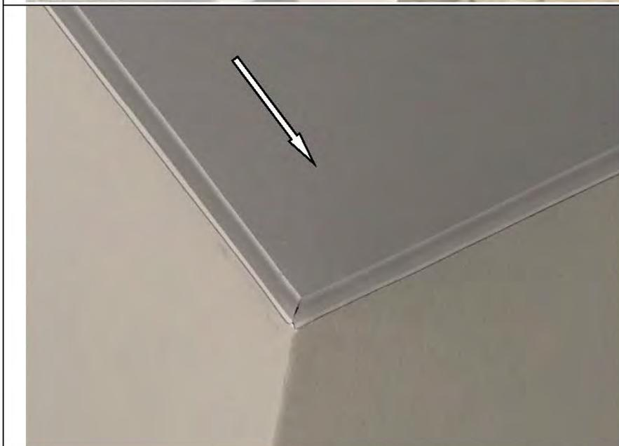
Фото №24. Загрязнения на полотне натяжного потолка в спальне в квартире.
