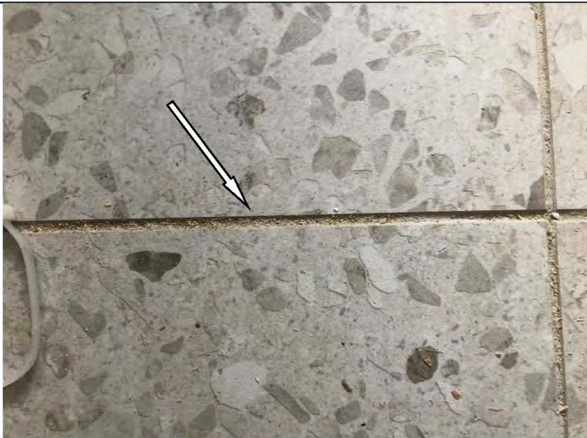
Фото №41. Неровный шов напольной керамической плитки в кухне в квартире.
