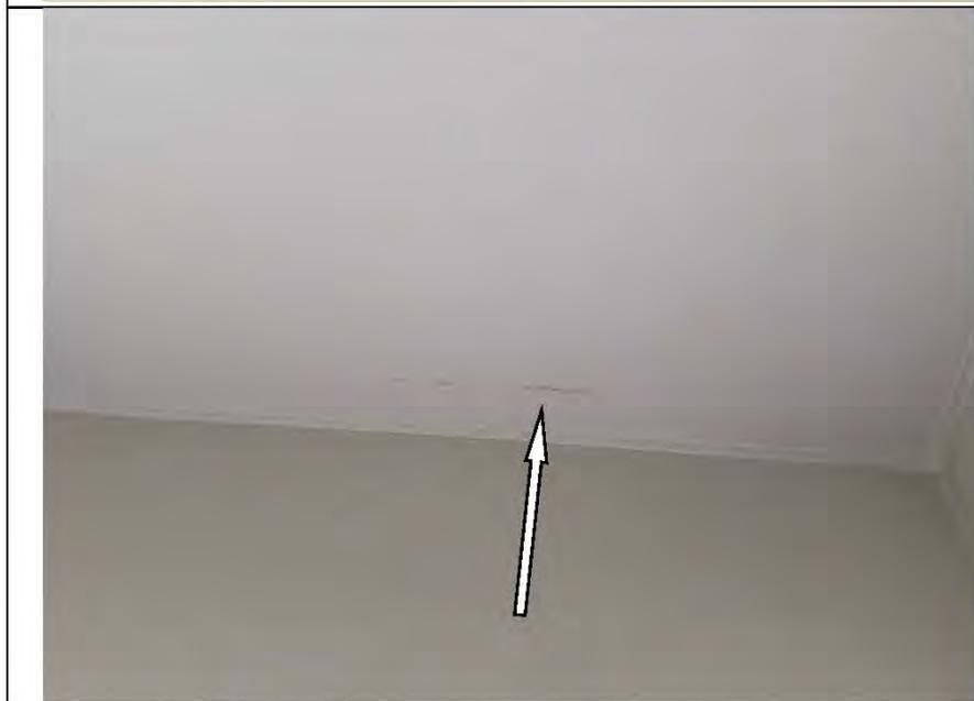
Фото №26. Загрязнения на полотне натяжного потолка в кладовке в квартире.
