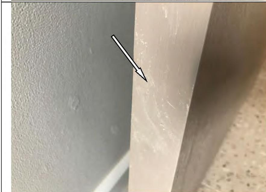
Фото №23. Загрязнения на полотне деревянного дверного блока в кухне в квартире.
