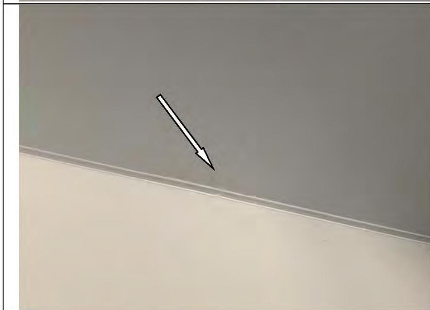
Фото №27. Загрязнения на полотне натяжного потолка в кухне в квартире.
