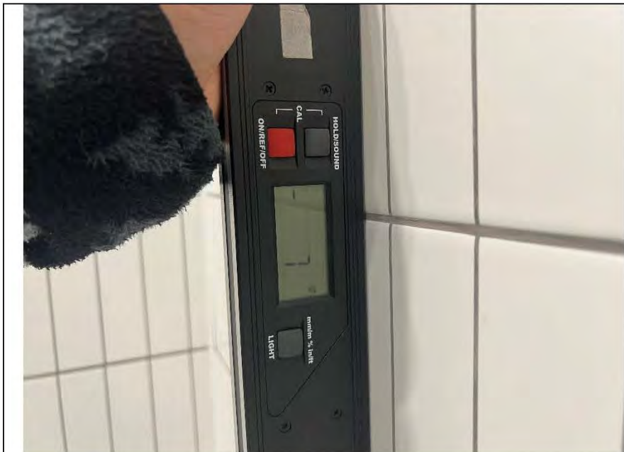
Фото №16. Измерение уровня стен в ванной комнате.
