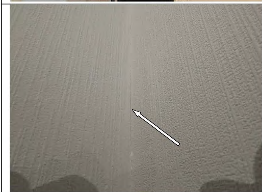
Фото №12. Читаемые обойные стыки в кухне.
