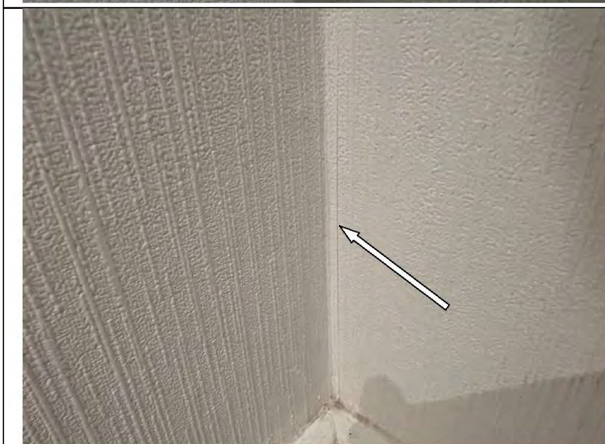
Фото №15. Читаемые обойные стыки в коридоре.
