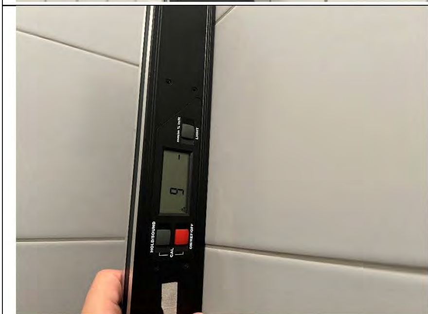
Фото №17. Измерение уровня стен в санузле.
