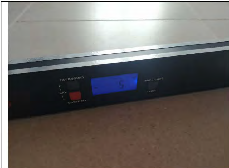
Фото №28. Отклонение по вертикали напольного покрытия из керамической плитки в кухне.
