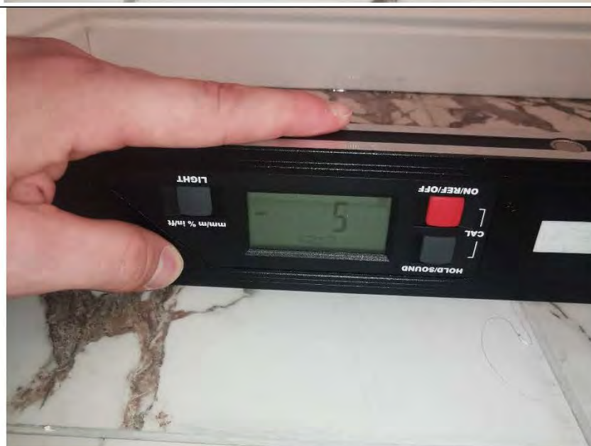
Фото №29. Измерение уровня пола в кухне.
