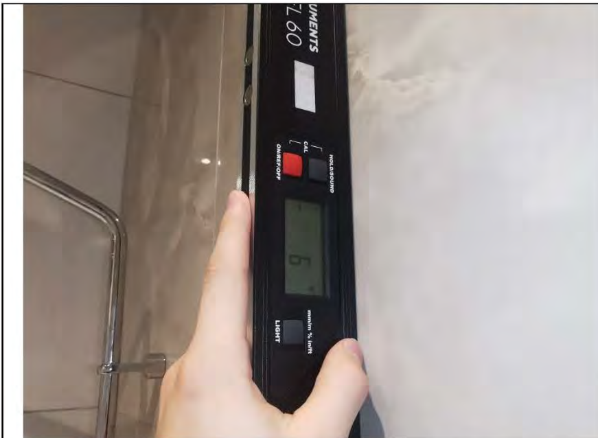
Фото №16. Измерение уровня стен в ванной комнате.
