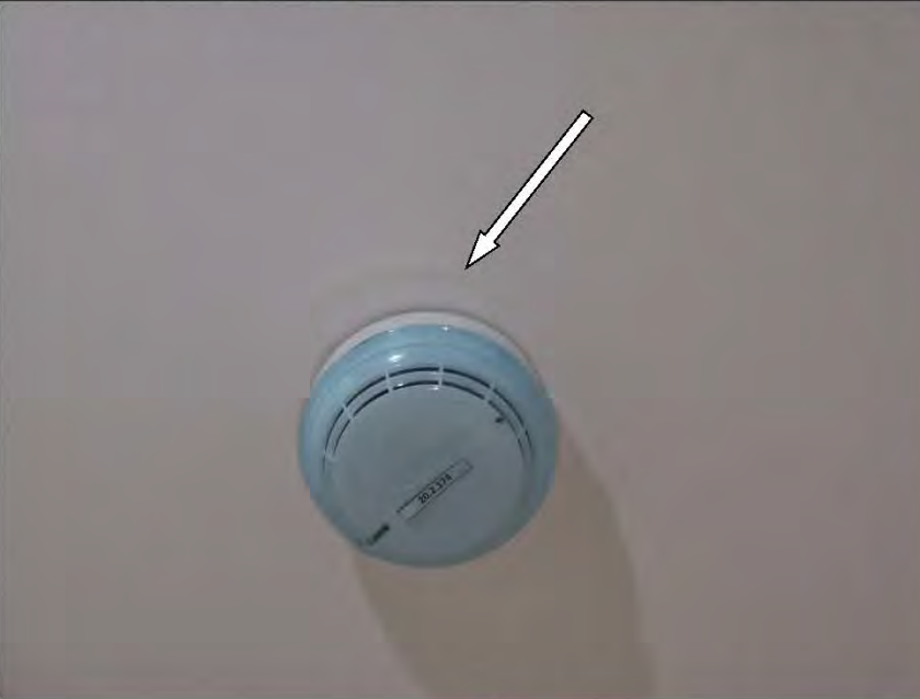
Фото №35. Видимость инженерных сетей на полотне натяжного потолка коридоре.
