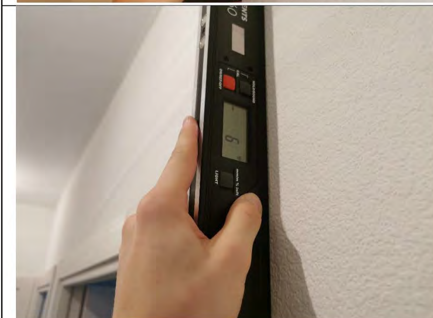
Фото №15. Измерение уровня стен в холле.
