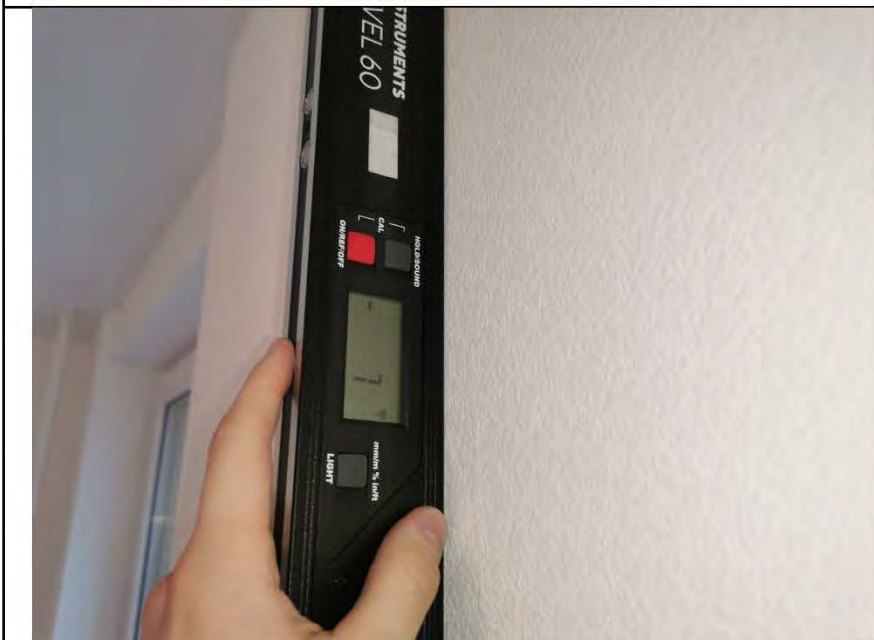
Фото №17. Измерение уровня стен в гостиной.
