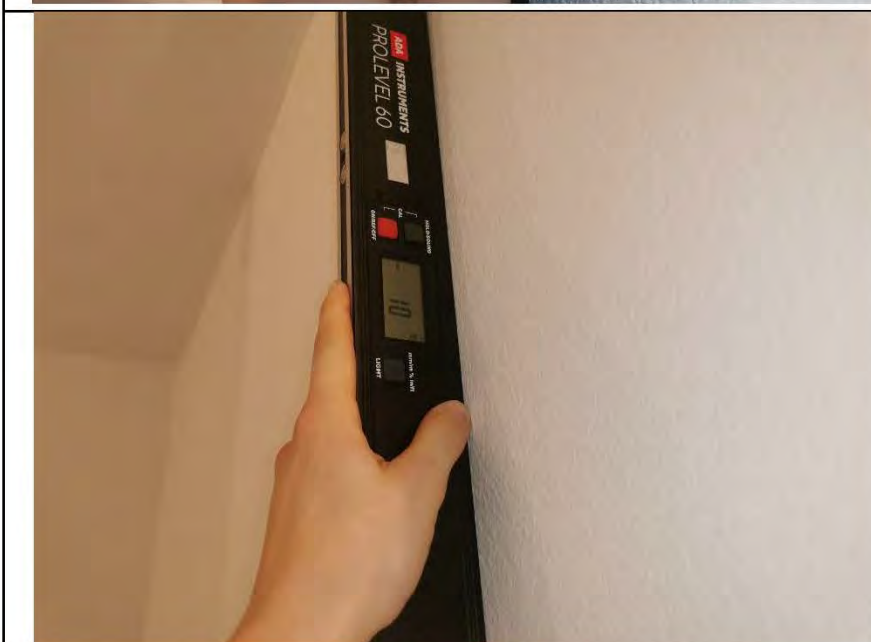
Фото №14. Измерение уровня стен в кухне.
