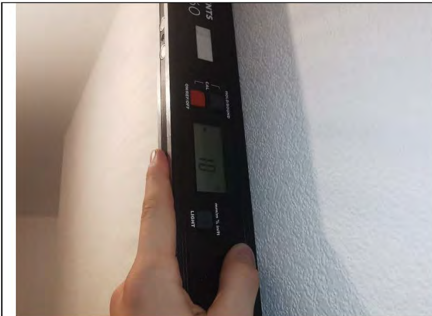
Фото №13. Измерение уровня стен в прихожей.
