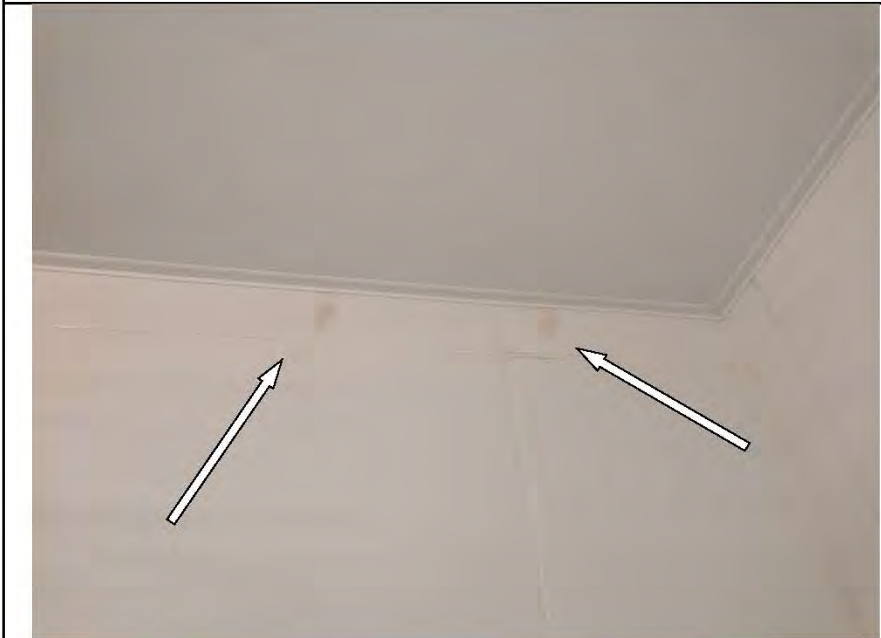
Фото №41. Загрязнение настенной керамической плитки в постирочной.
