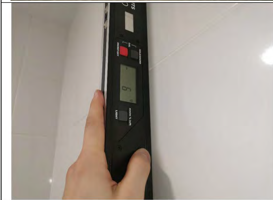
Фото №30. Измерение уровня стен в санузле.
