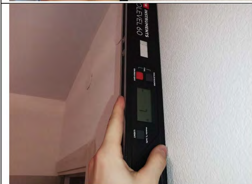
Фото №18. Измерение уровня стен в спальне.
