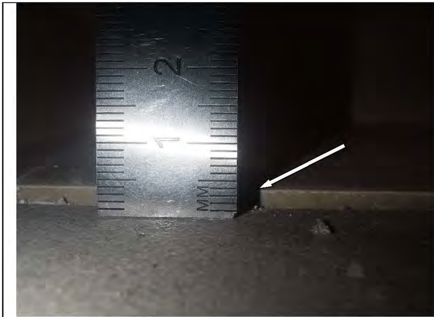
Фото №64. Уступы керамической плитки пола в прихожей.
