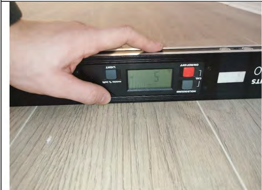
Фото №42. Измерение уровня пола в кухне.
