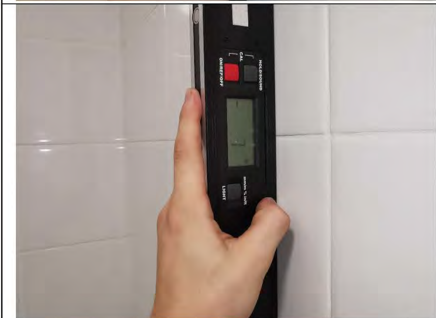
Фото №32. Измерение уровня стен в ванной комнате.
