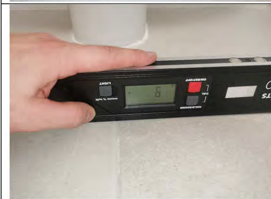
Фото №57. Измерение уровня пола в санузле.
