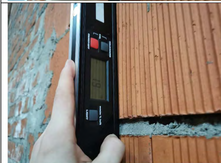
Фото №5. Измерение уровня стен в помещении.
