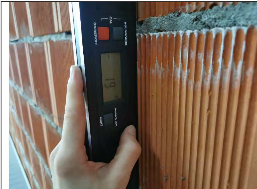
Фото №4. Измерение уровня стен в помещении.
