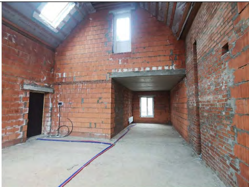
Фото №2. Общий вид помещения.
