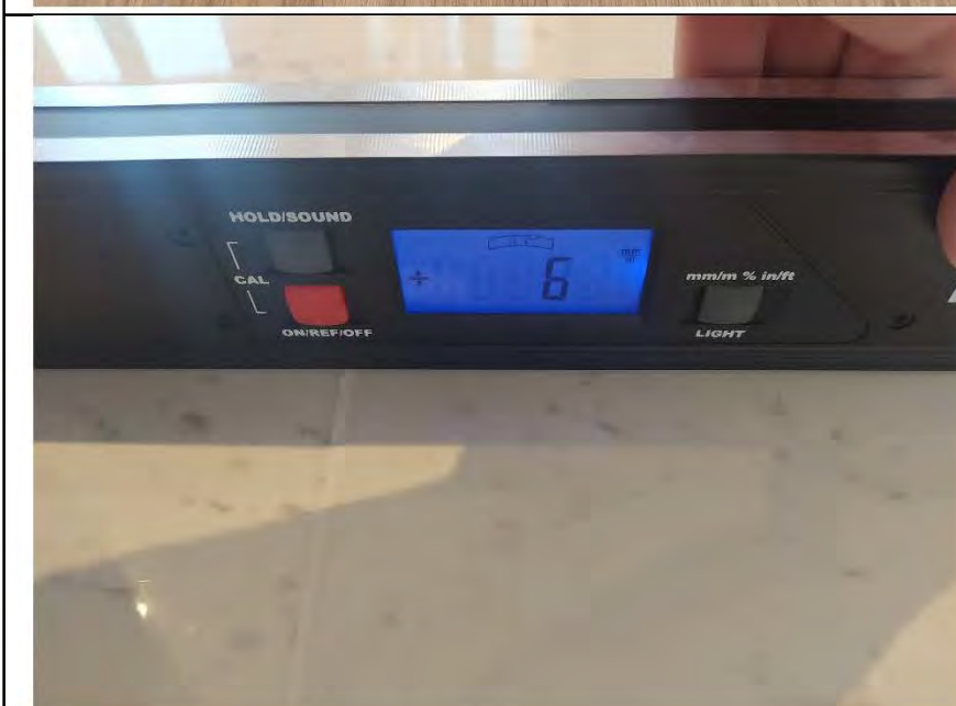
Фото №12. Измерение уровня напольного покрытия в кухне (керамическая плитка).
