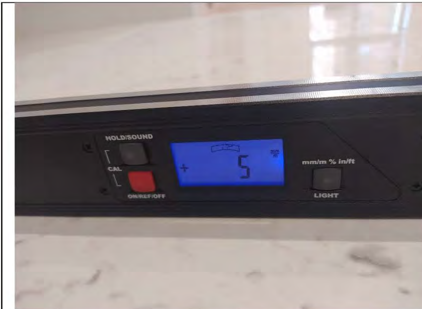
Фото №13. Измерение уровня напольного покрытия в прихожей (керамическая плитка).
