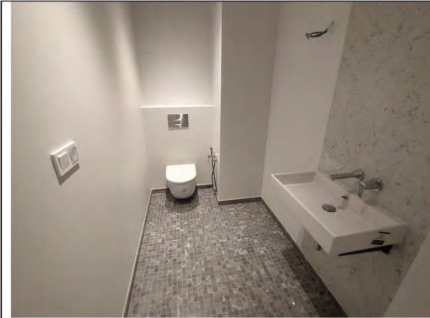
Фото №4. Общий вид санузла.
