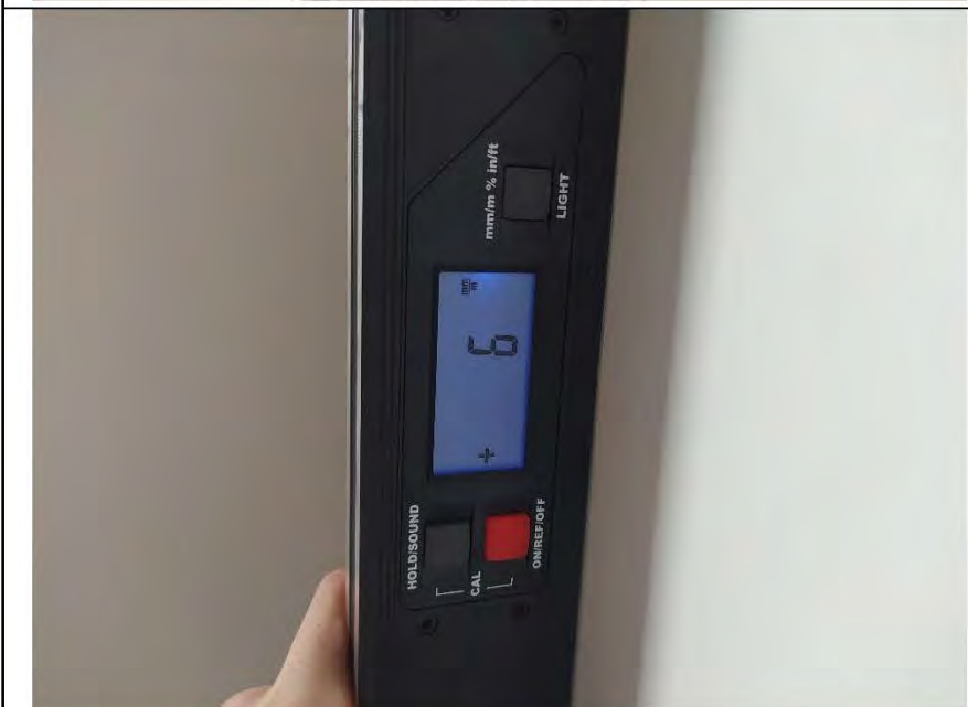
Фото №6. Измерение уровня стен в спальне.
