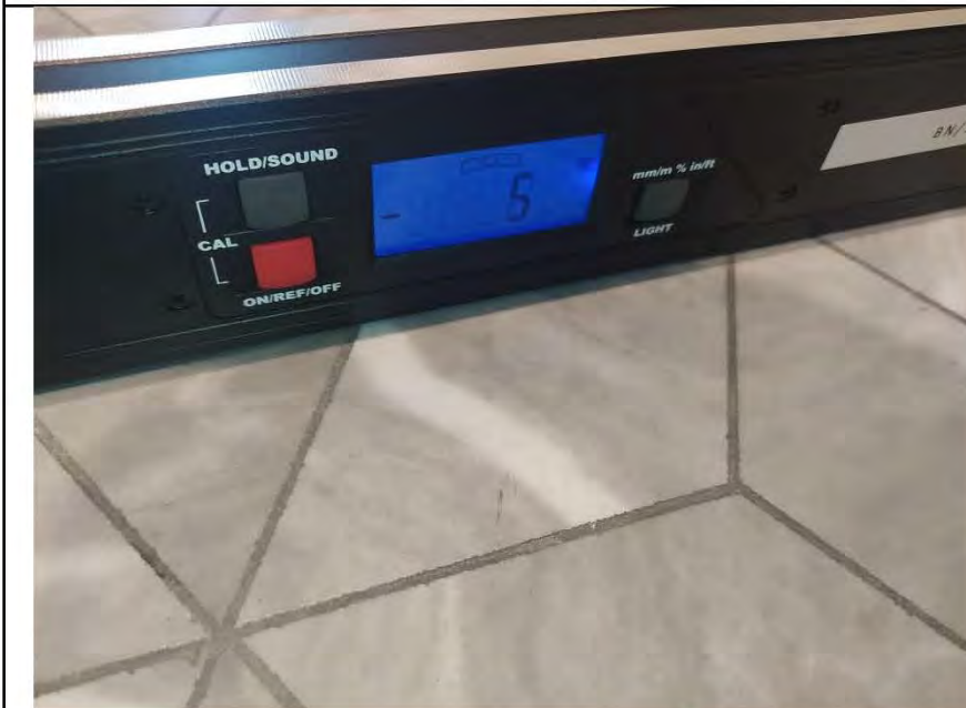
Фото №14. Измерение уровня напольного покрытия в ванной комнате (керамическая плитка).
