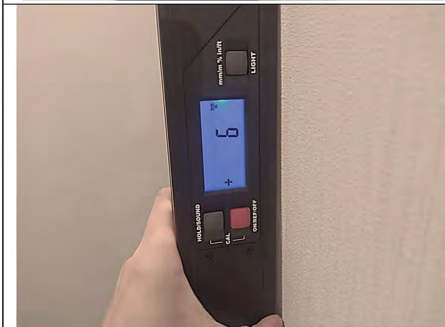
Фото №8. Измерение уровня стен в прихожей.
