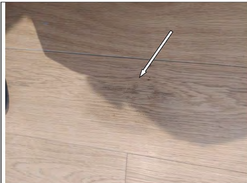
Фото №43. Загрязнения на поверхности инженерной доски в спальне.
