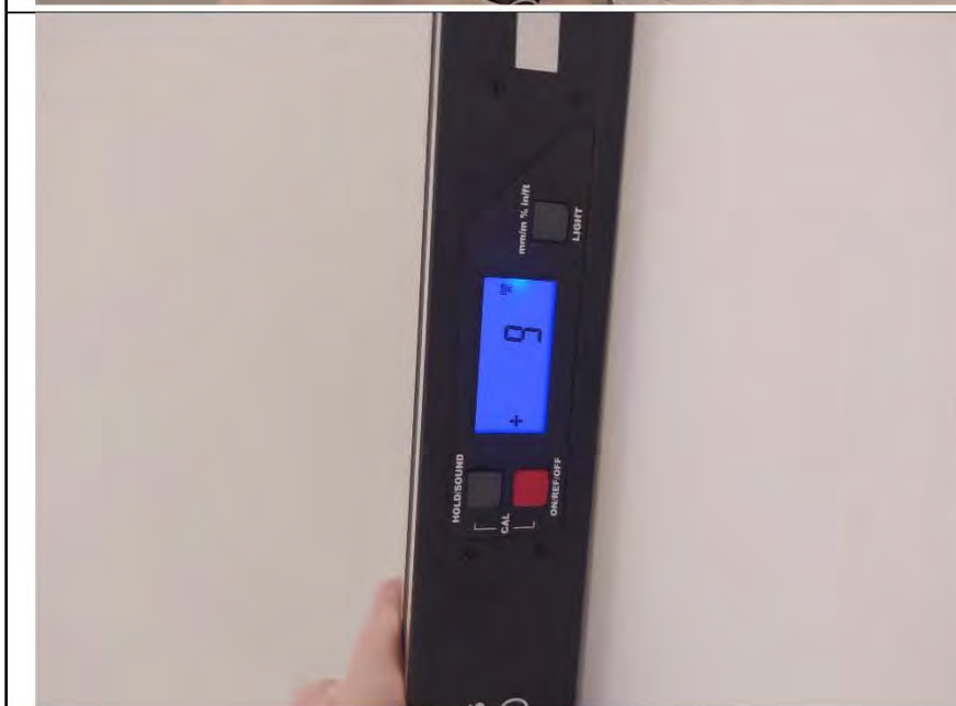
Фото №9. Измерение уровня стен в санузле.
