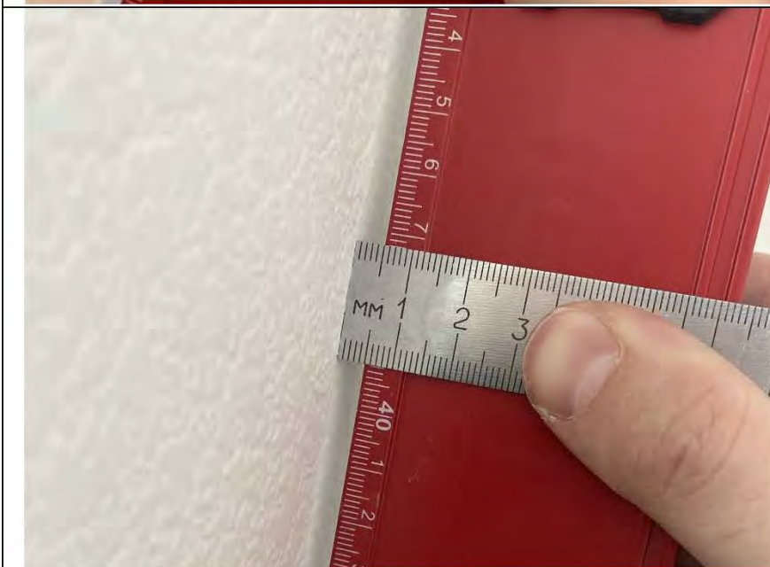
Фото №17. Измерение уровня стен в детской комнате в квартире.
