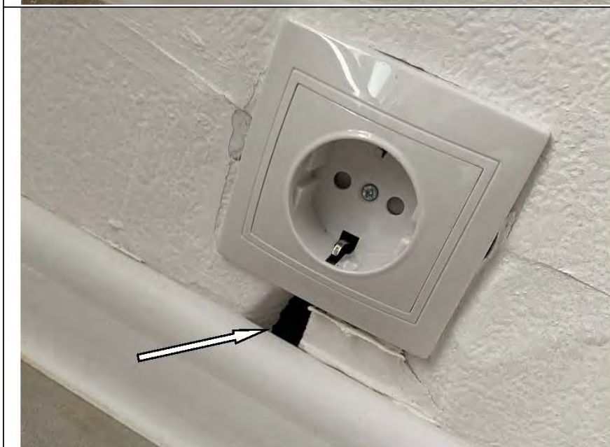
Фото №83. Стены, оклеенные обоями, в кухне выполнены с дефектами.
