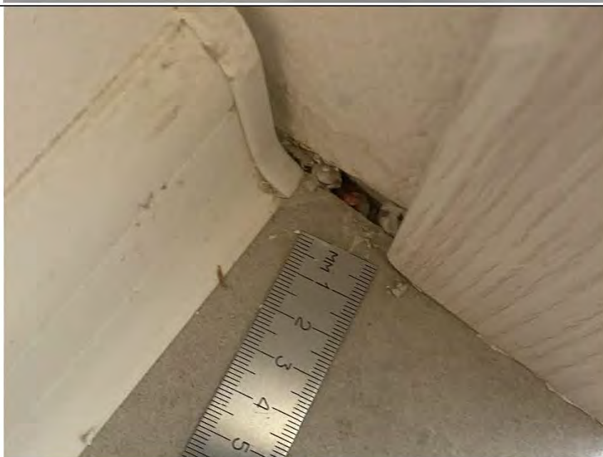
Фото №38. Коротко подрезана напольная керамическая плитка на стыке элементов в санузле.
