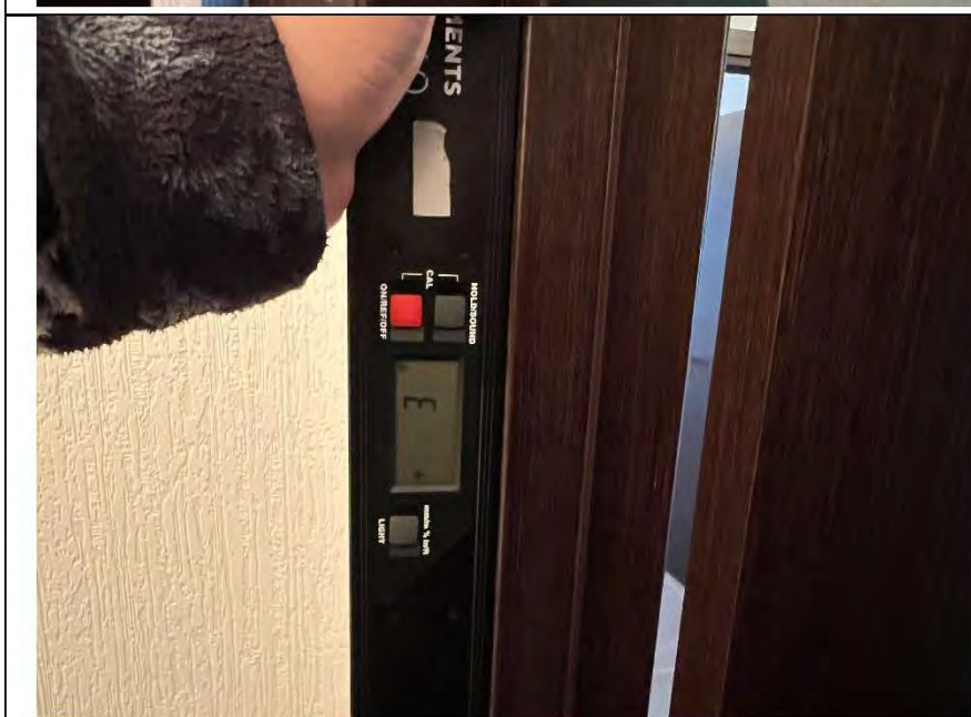
Фото №120. Отклонение коробки от плоскостности и прямолинейности дверного блока в гардеробной составляет 3 мм.
