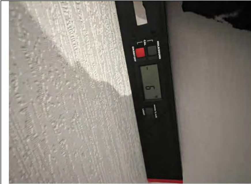
Фото №16. Измерение уровня стен в кабинете.
