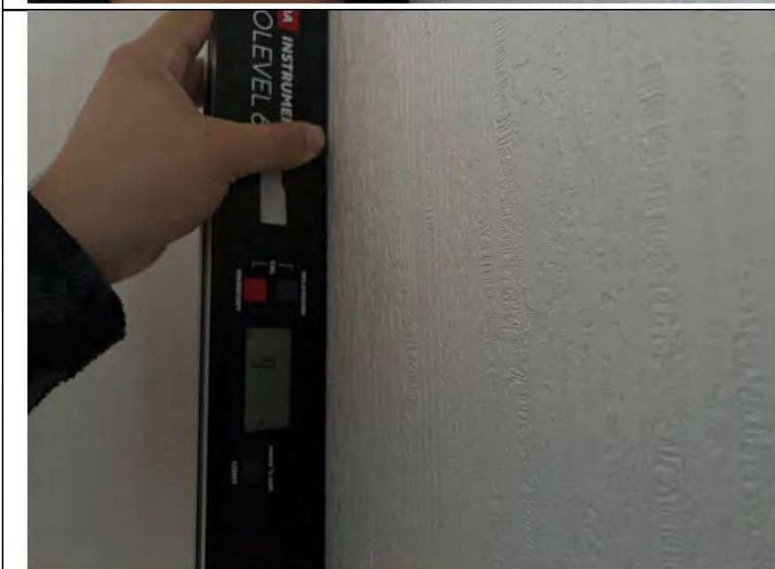
Фото №14. Измерение уровня стен в спальне.
