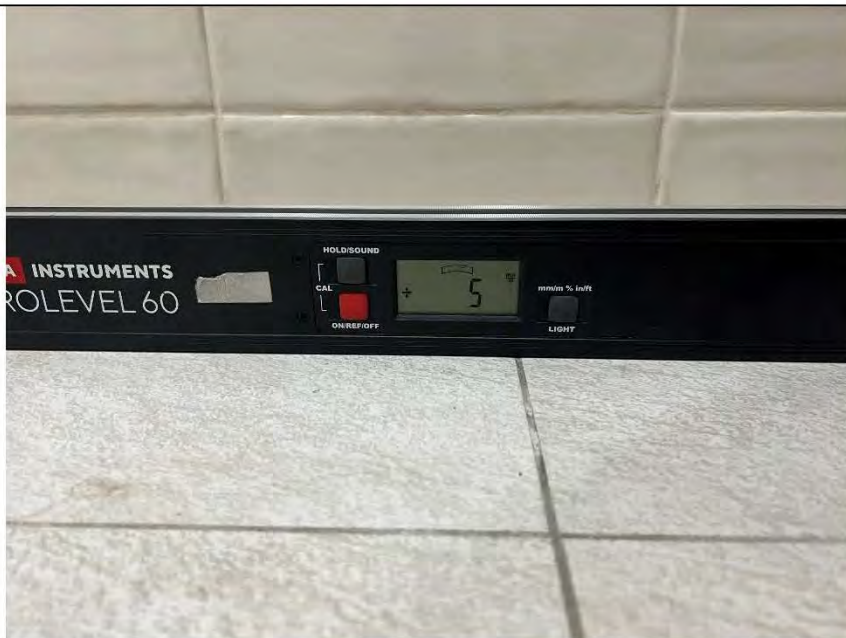
Фото №40. Измерение уровня напольного покрытия в санузле.
