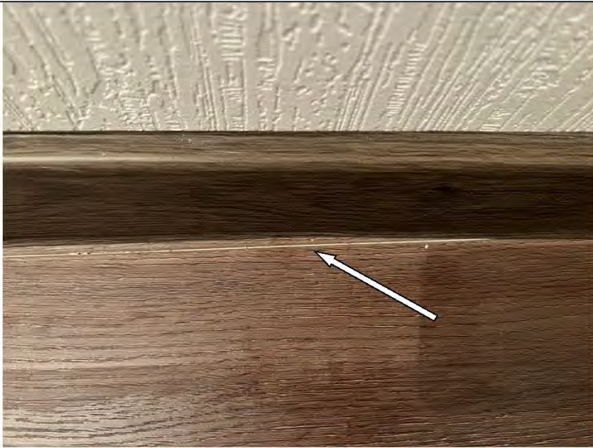
Фото №46. Коротко подрезан ламинат в гардеробной на стыке элементов.
