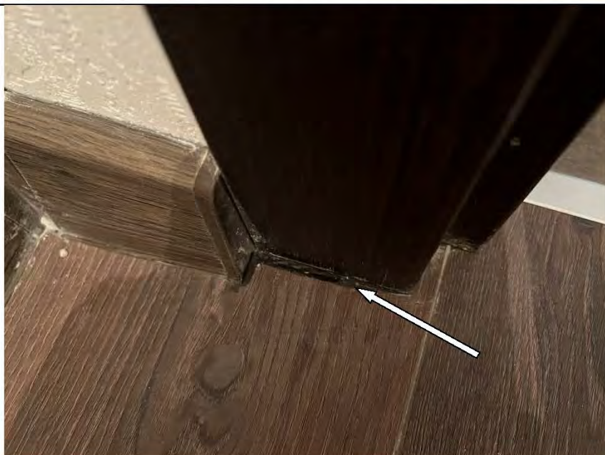
Фото №45. Коротко подрезан ламинат в гардеробной на стыке элементов.
