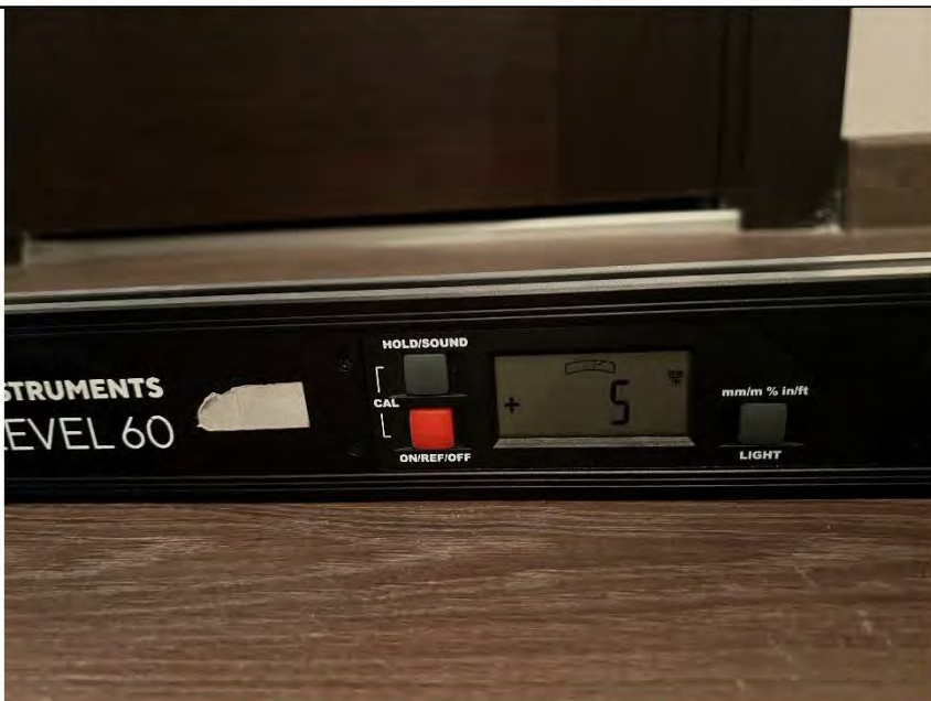
Фото №39. Измерение уровня напольного покрытия в коридоре.
