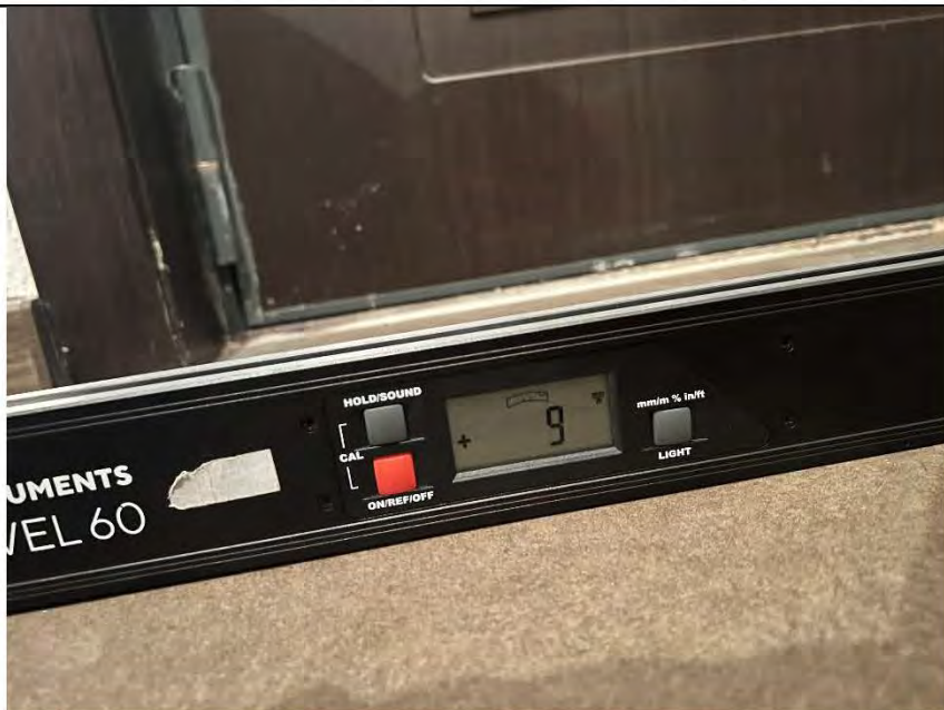
Фото №44. Измерение уровня напольного покрытия в коридоре.
