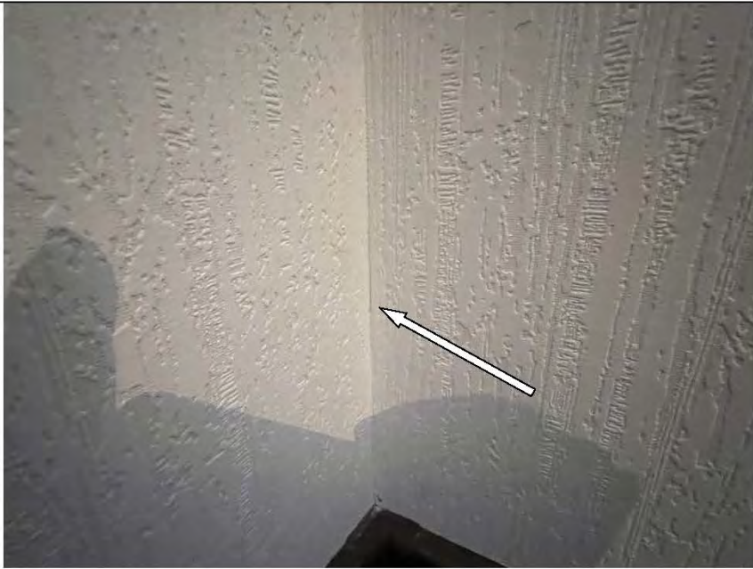
Фото №25. Читаемые обойные стыки в кухне.
