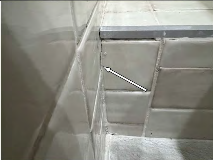
Фото №32. Трещина затирочного раствора в шовном пространстве настенной керамической плитки в санузле.
