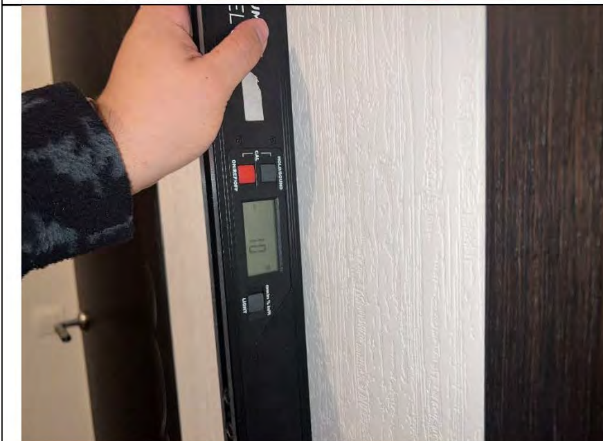
Фото №17. Измерение уровня стен в коридоре.
