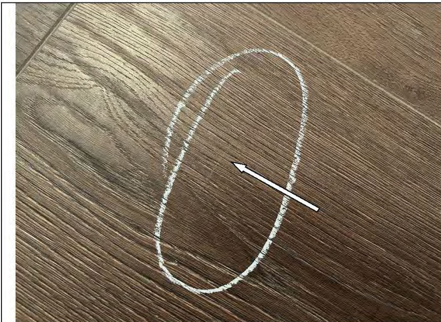
Фото №55. Царапина на поверхности ламината в кабинете.
