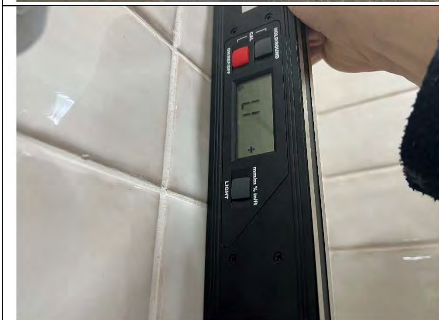
Фото №29. Измерение уровня стен в санузле.
