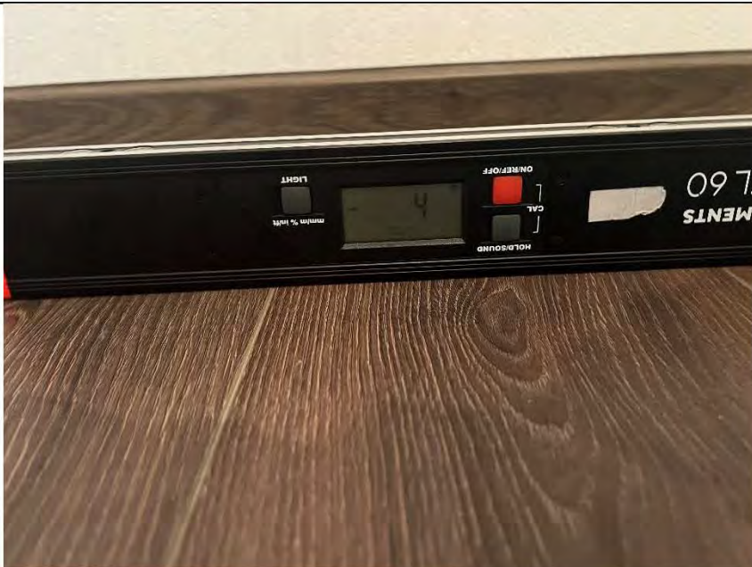
Фото №38. Измерение уровня напольного покрытия в кабинете.
