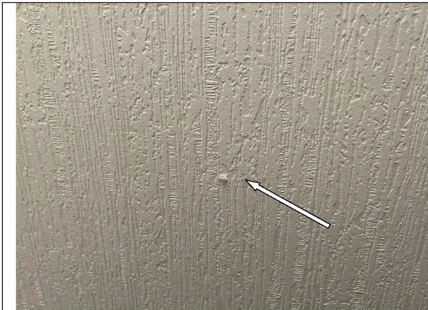
Фото №22. Сколы обоевого полотна в гардеробной.
