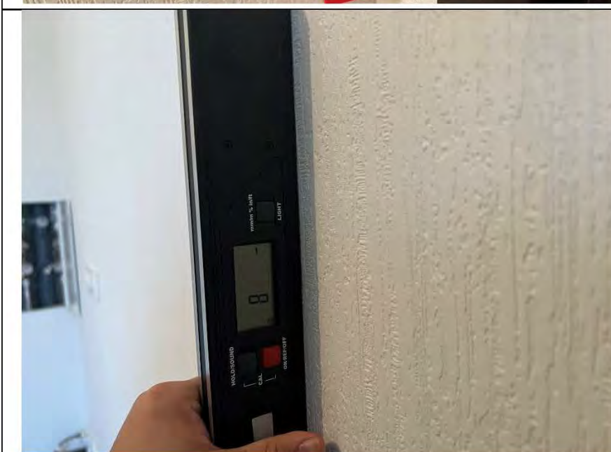
Фото №12. Измерение уровня стен в кухне.
