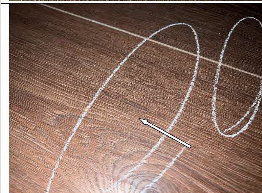
Фото №56. Царапина на поверхности ламината в кабинете.
