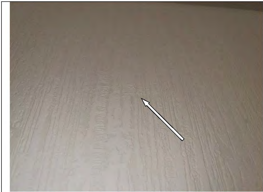
Фото №19. Вмятина обойного полотна в коридоре.
