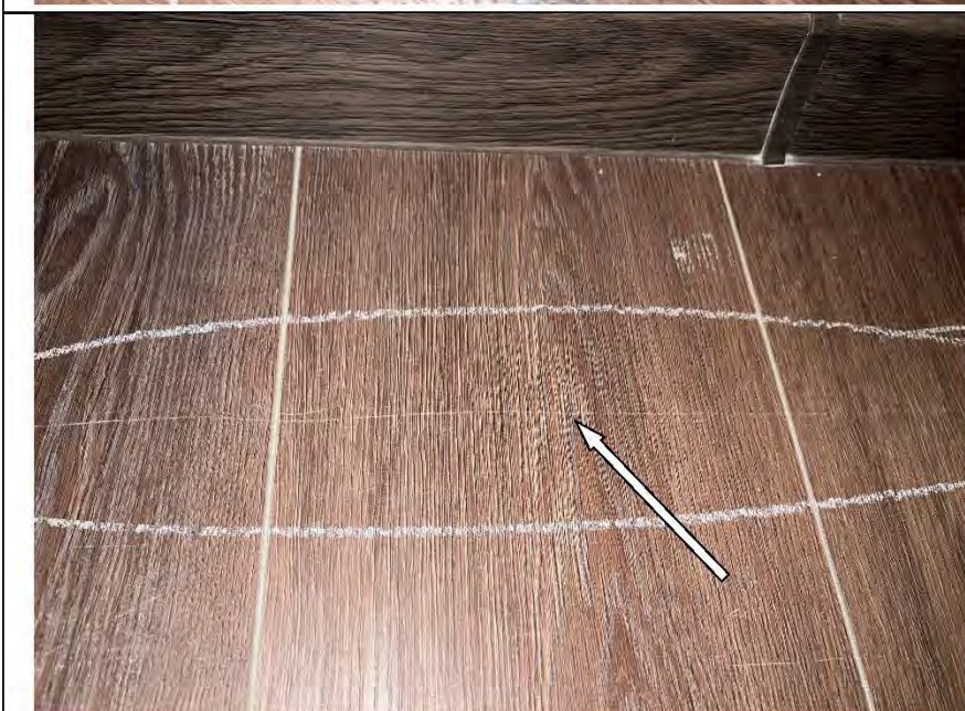
Фото №57. Царапина на поверхности ламината в коридоре.
