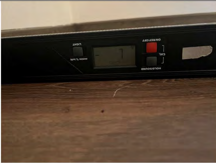
Фото №37. Измерение уровня напольного покрытия в детской.
