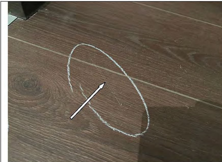
Фото №58. Царапина на поверхности ламината в коридоре.
