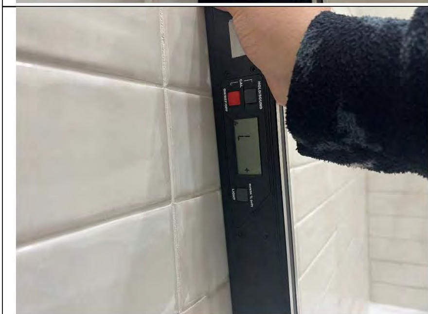
Фото №30. Измерение уровня стен в ванной комнате.
