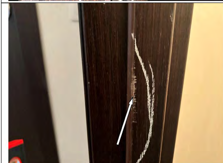
Фото №128. Царапины на коробе деревянного дверного блока в гардеробной.
